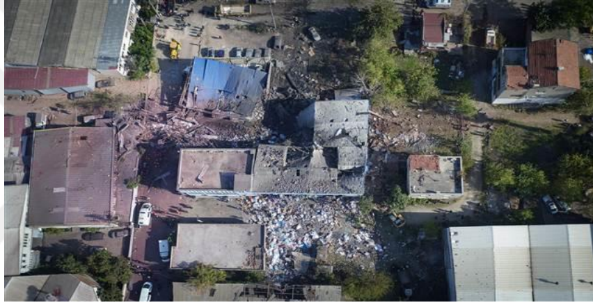
Resim 4. Bursa Tekstil Fabrikasında Boyahane Patlaması
