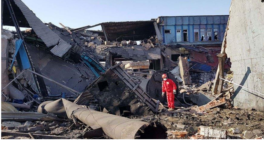
Resim 5. Bursa Makina İmalat Fabrikasında Boyahane Patlaması
