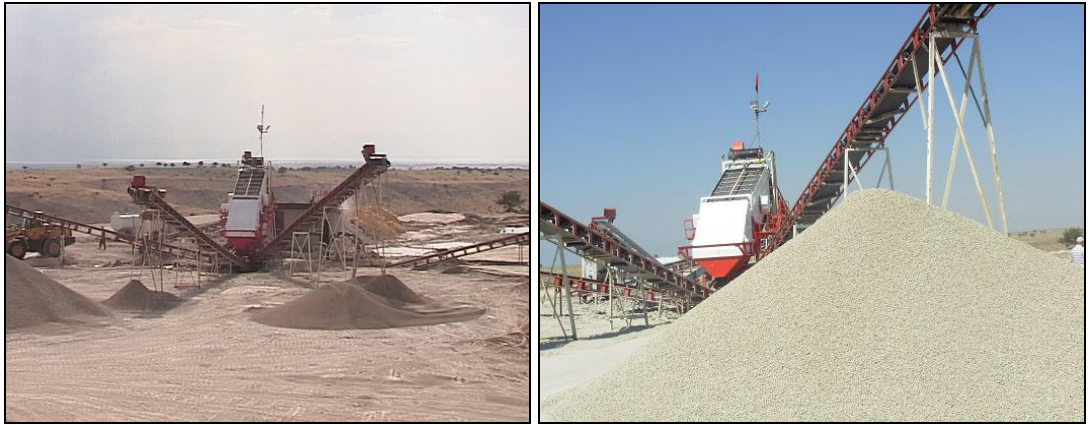
Şekil 2.7 Bims Eleme Ve Sınıflandırma Tesisinden Görünümler
