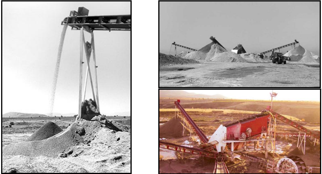
Şekil 3.25 Doğanbey Saflaştırma Tesisinden Görünümler
