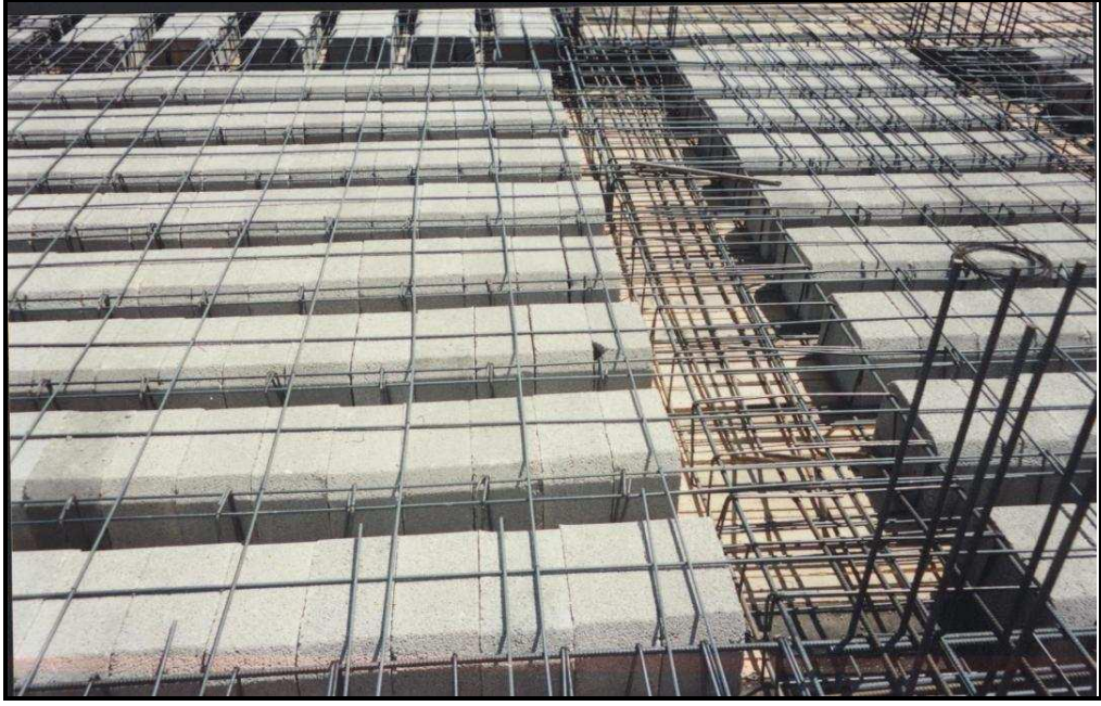
Şekil 3.9 Asmolen Döşemeden Bir Görünüm
