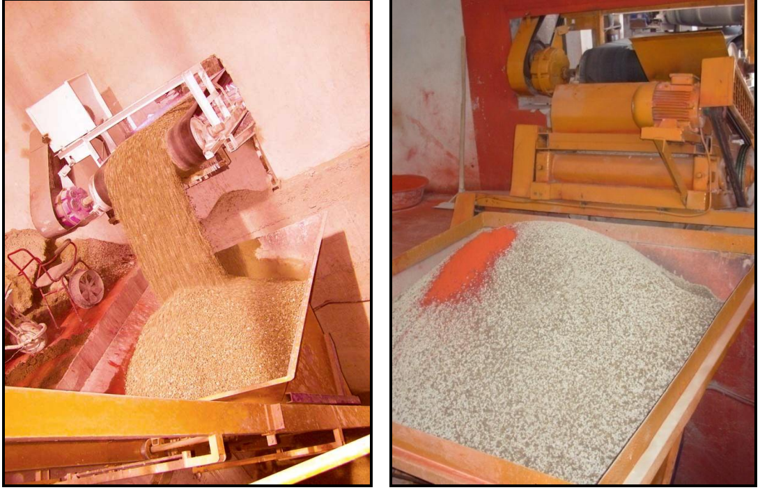
Şekil 3.28 Bunkerlerden Agregaların Karışıma Alındığı Hazne ( Skraypere)
