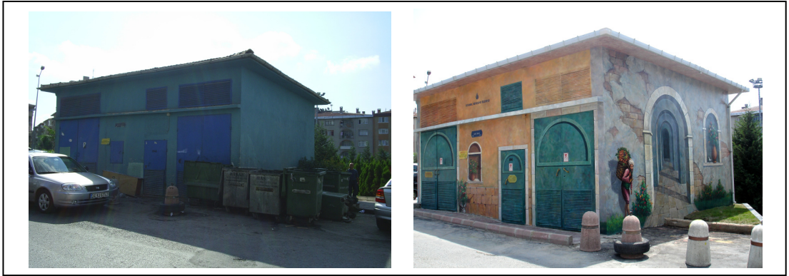
Şekil 3. 8. Trafoların “Sihirli Resim Tekniđi” İle Boyanması
