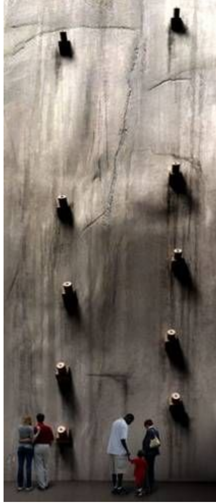
Şekil-4.33: İkiz Kulelere ait betonarme temel duvarları ait detay görünüşü
