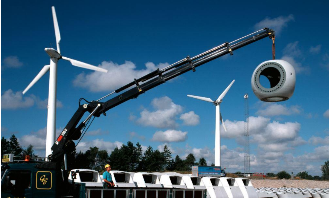
Şekil 10: Rotor göbeğinin kaldırılması 30
