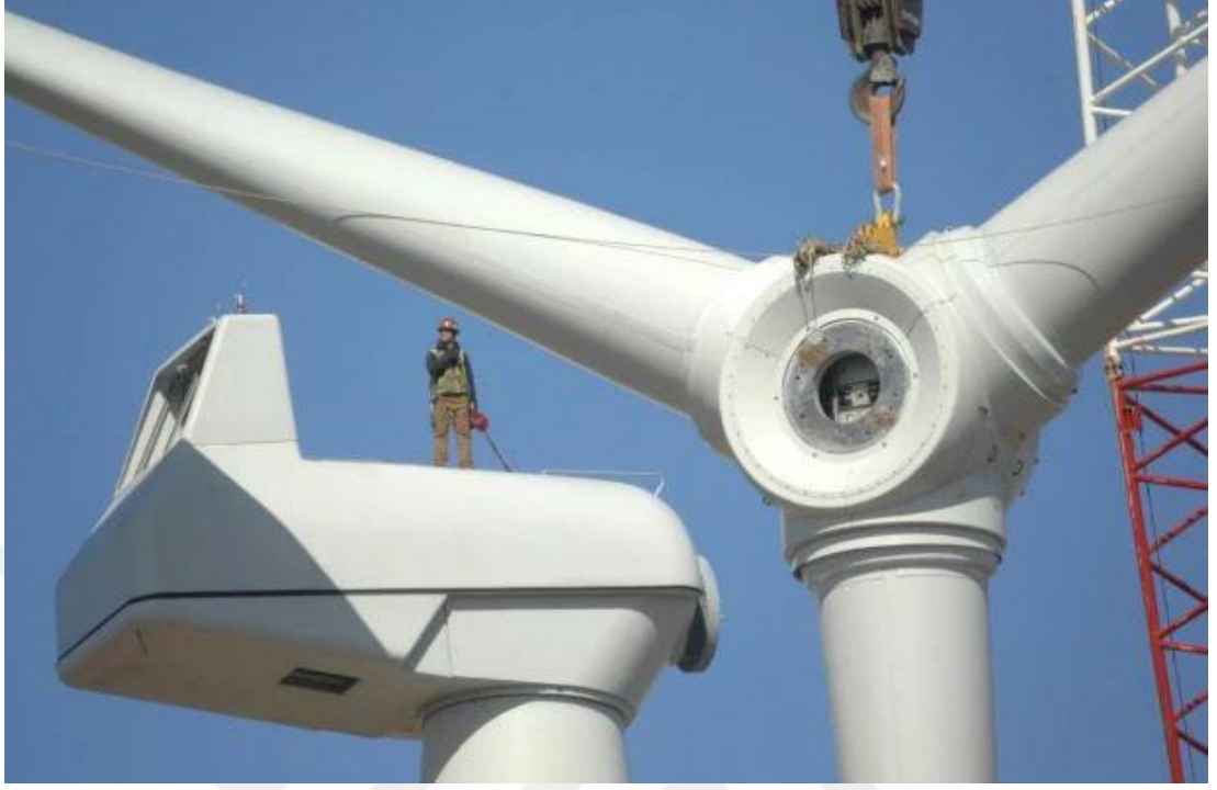
Şekil 12: Bıçakların kaldırılması ve montaj işlemi 32
