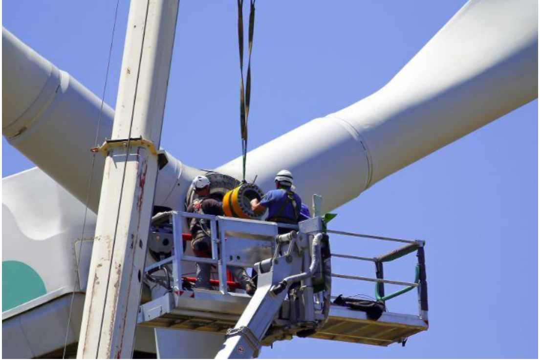
Şekil 13: Bıçakların göbeğe montajı 33
