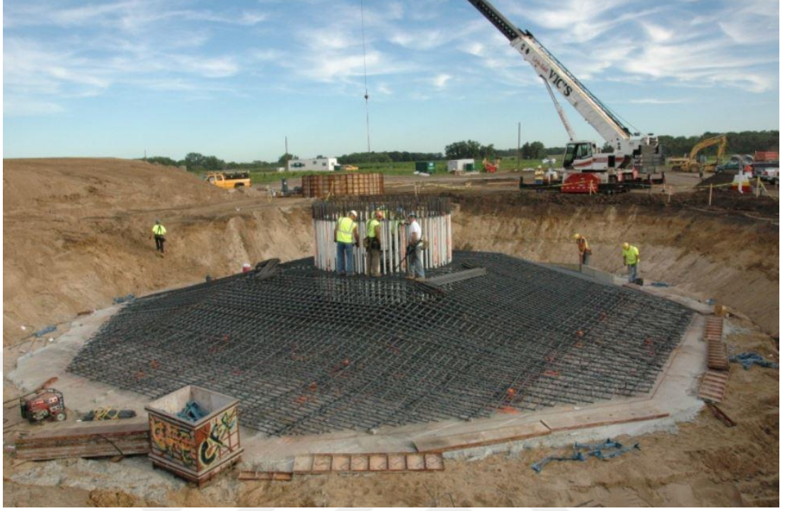
Şekil 8: Çelik tabanlığın yerleşeceği alanın inşaatı 28
