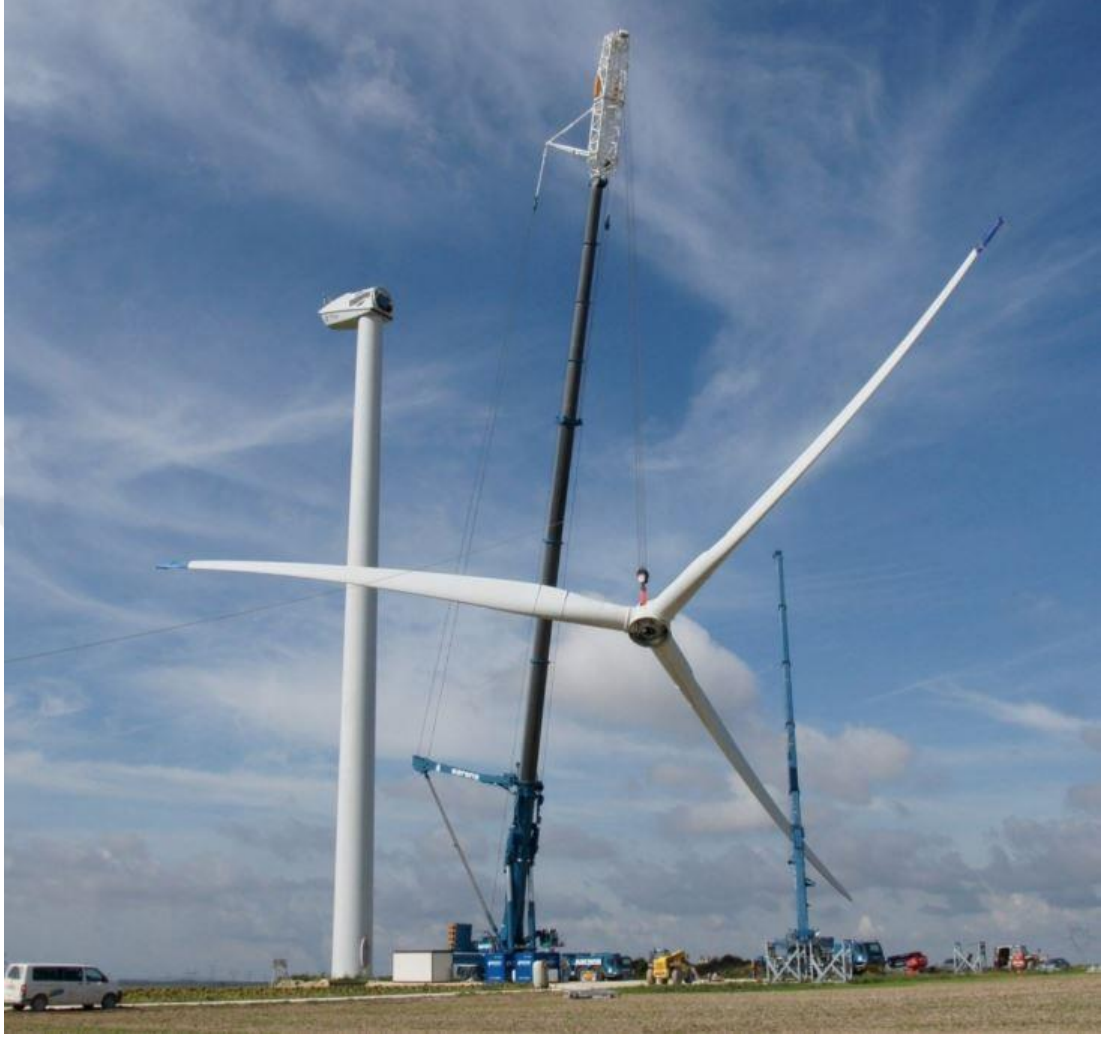
Şekil 11: Bıçakların kaldırılması 31
