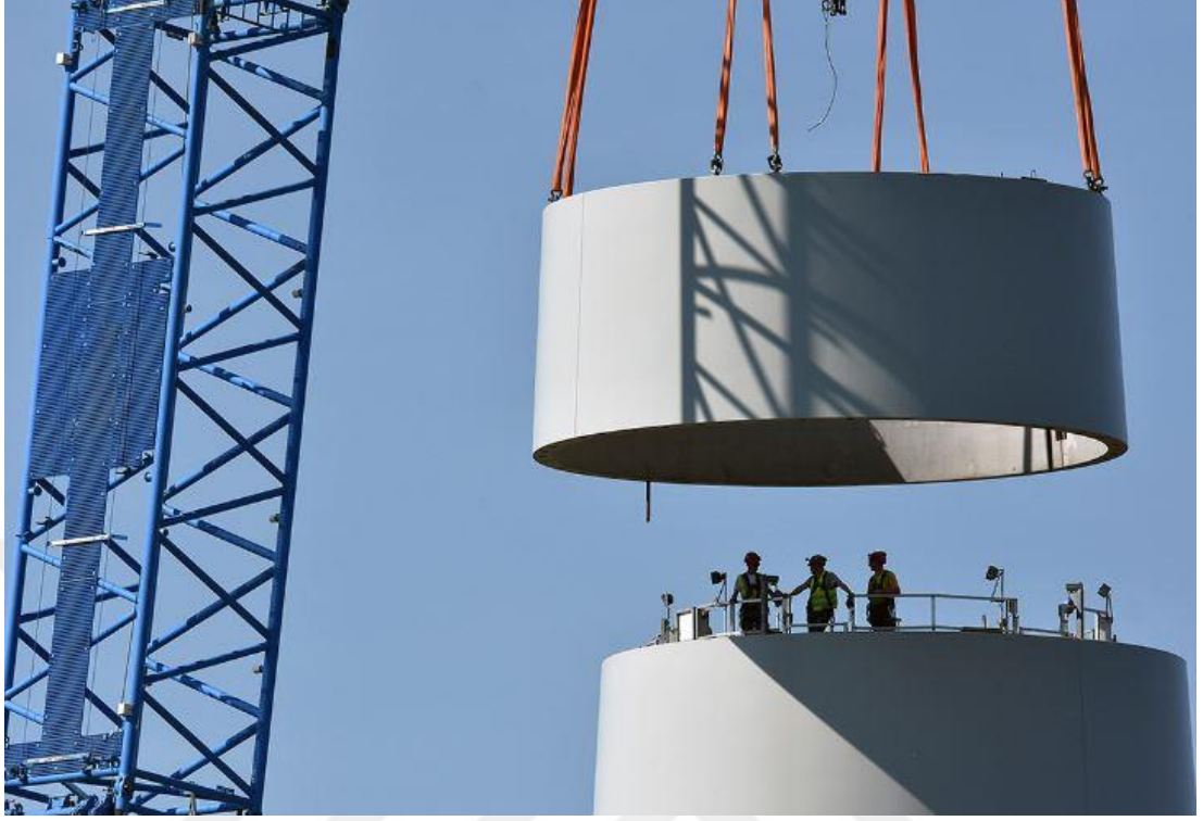
Şekil 14: Türbin kule parçalarının montajı 34
