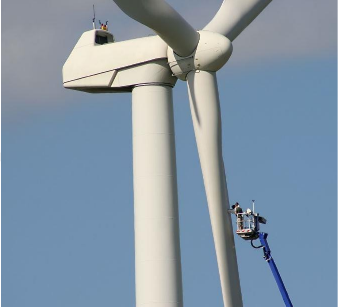
Şekil 16: Türbin bıçaklarına bakım-onarım faaliyetleri 36
