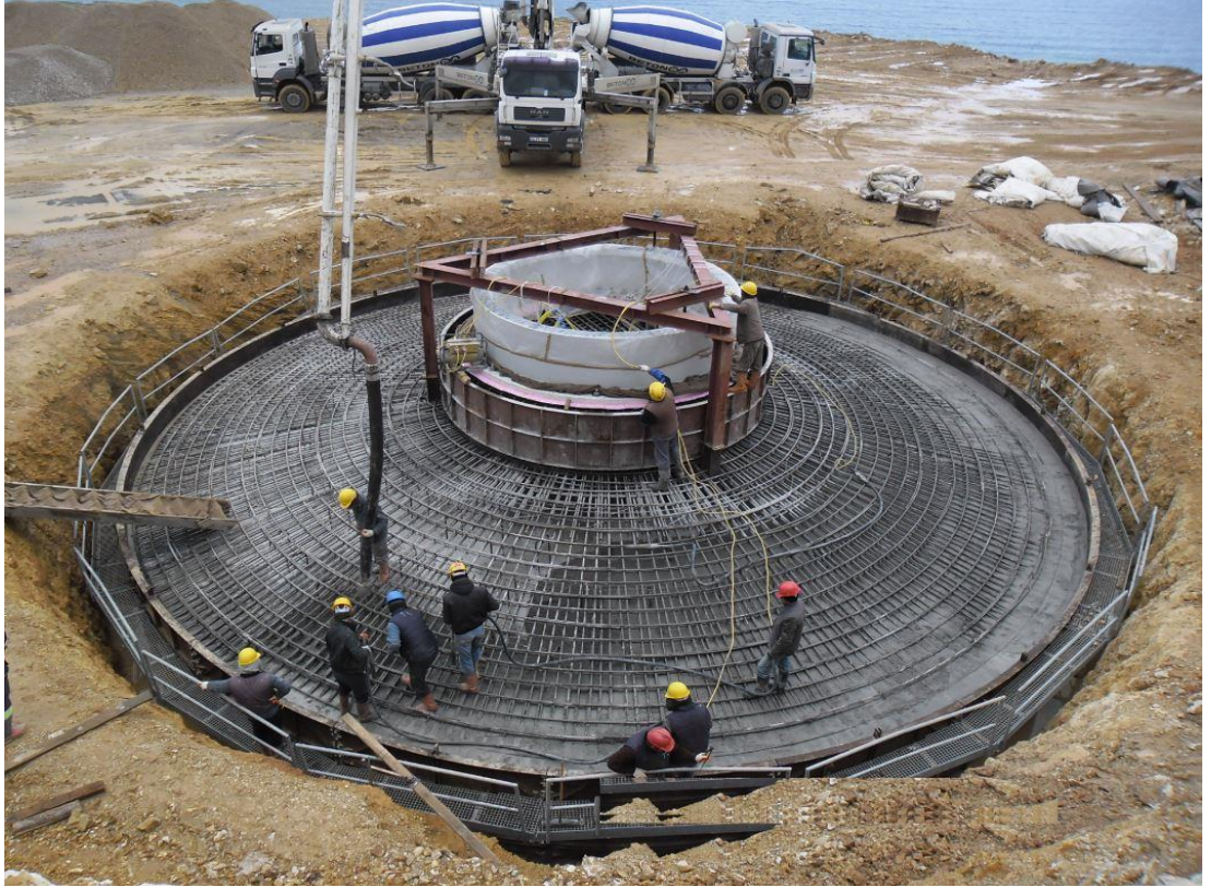
Şekil 9: Türbinin yerleştirileceği alanın beton döküm işlemi 29
