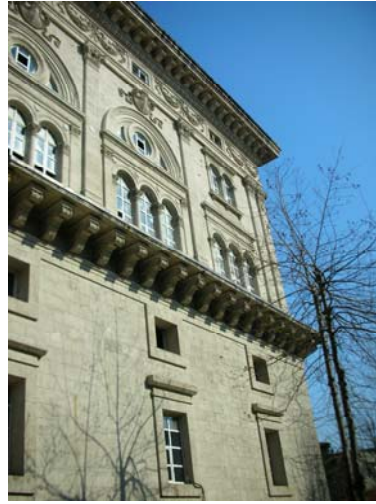
Fotoğraf 2.84. İtalya Elçilik Binası cephe detay
