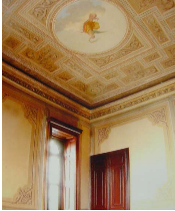
Fotograf 2.107. Amerikan Elçilik Binası tavan süslemeleri
