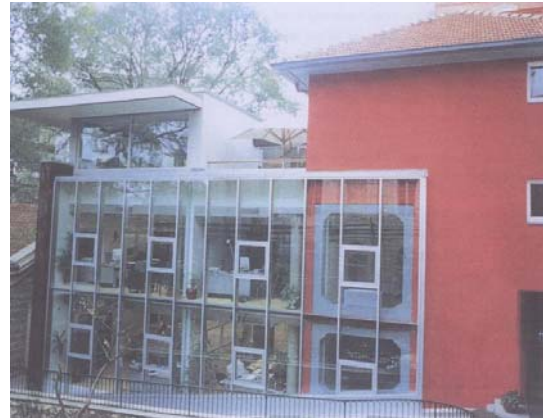
Fotoğraf 2.36. Yeni konsolosluk ofis binası-2000
