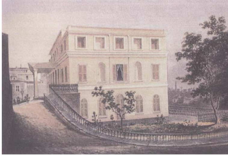
Şekil 2.25. Hollanda Sarayı yan cephesi- Van Zuylen van Nijevelt'in suluboya kitabı
