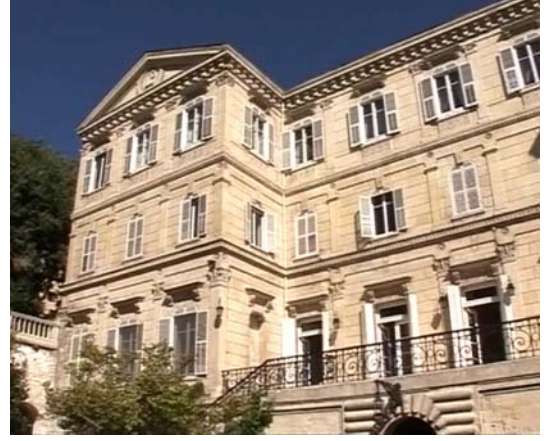
Fotoğraf 2.5. Fransız Sarayı güney cephesi
