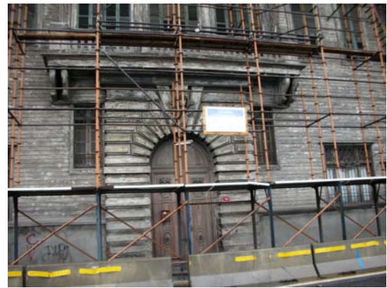
Fotoğraf 3.2. İtalya Elçilik Binası cephe detay
