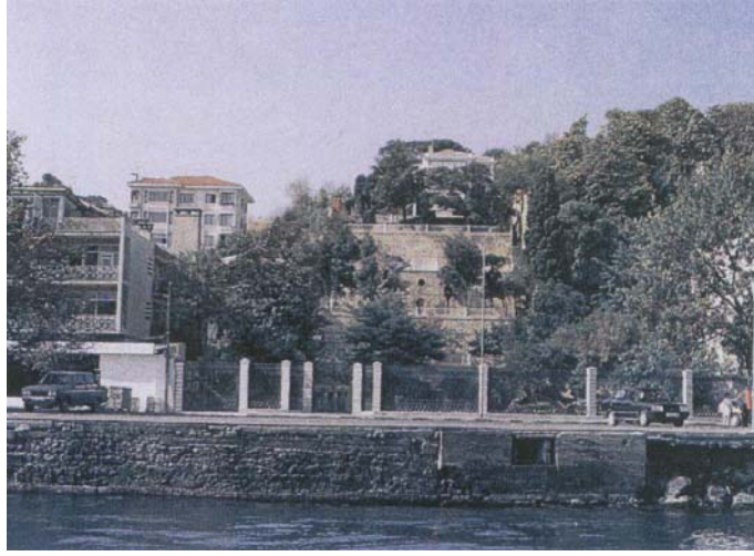
Fotoğraf 2.146. Polonya Elçilik Binası'nın yıkımdan sonra boş kalan arsası
