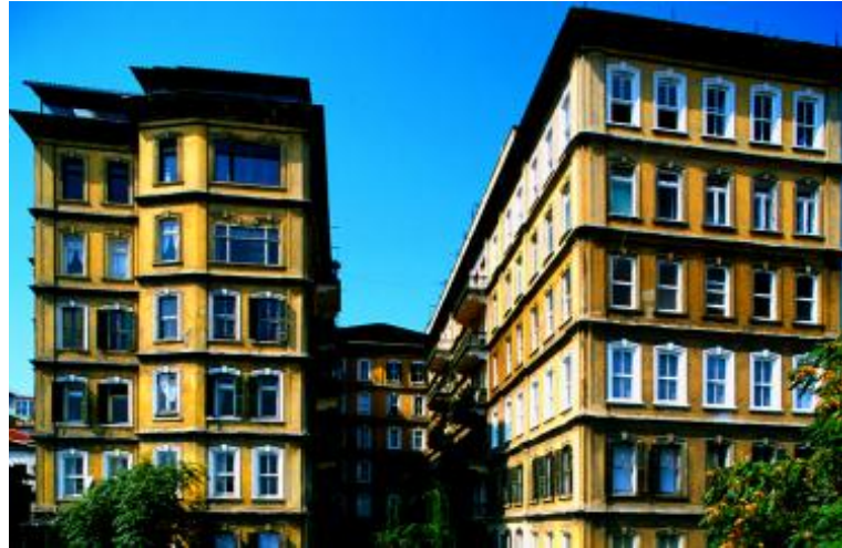
Fotoğraf 2.154. Doğan apartmanı deniz cephesi
