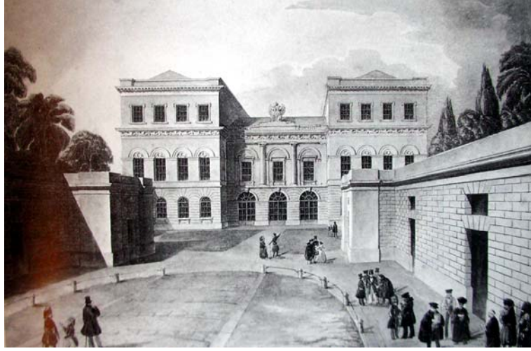
Şekil 2.15. Rus Sarayı batı (giriş) cephesi-1850
