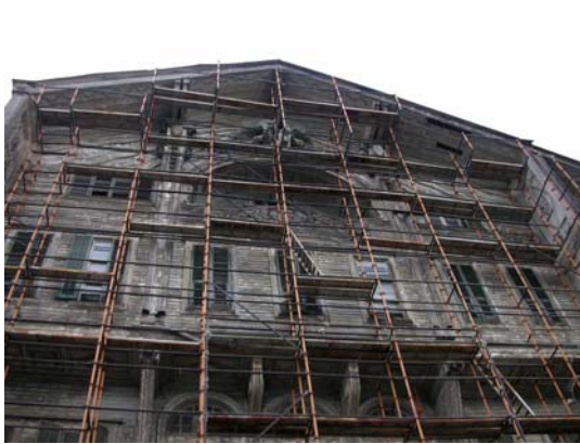
Fotoğraf 3.1. İtalya Elçilik Binası cephe
