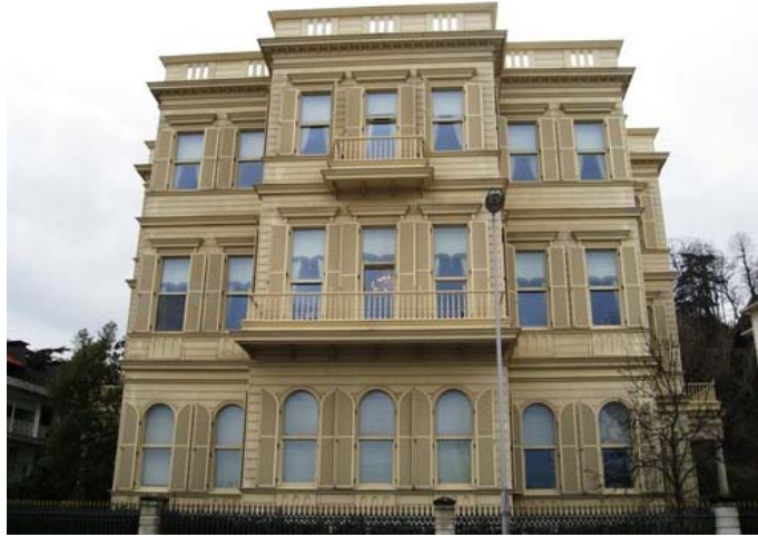
Fotoğraf 2.147. Yeniden yapılan betonarme yapının deniz cephesi
