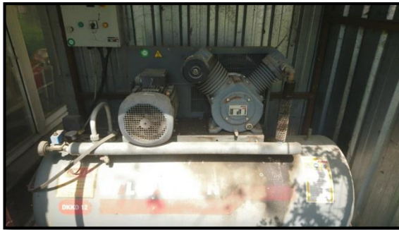
Resim 28: İSFALT Merkez Laboratuvarı – Korunmalı Kompresörler
