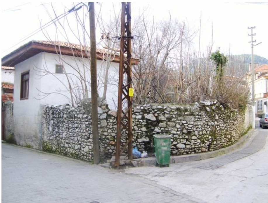
Fotoğraf 74 Saburhane Sokađında Bulunan Bahçe Duvarı Foto: F. Üzeyirođlu 2009
