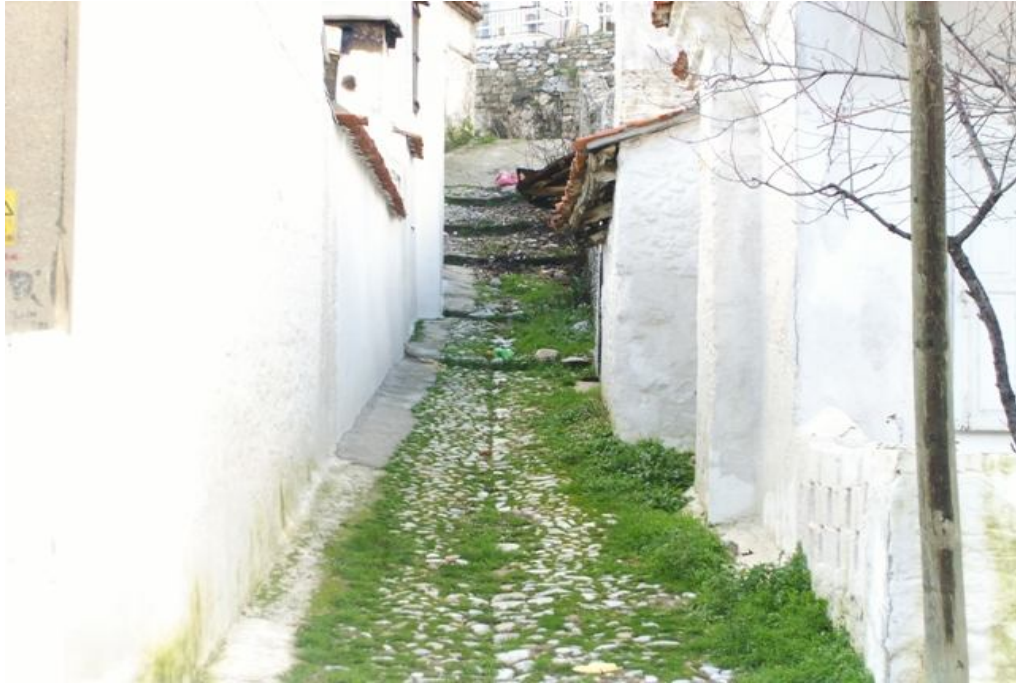
Fotoğraf 94 Dere Kenarından Getirilen Taşlarından Yapılan Yol Kaplaması Foto: F. Üzeyirođlu 2009
