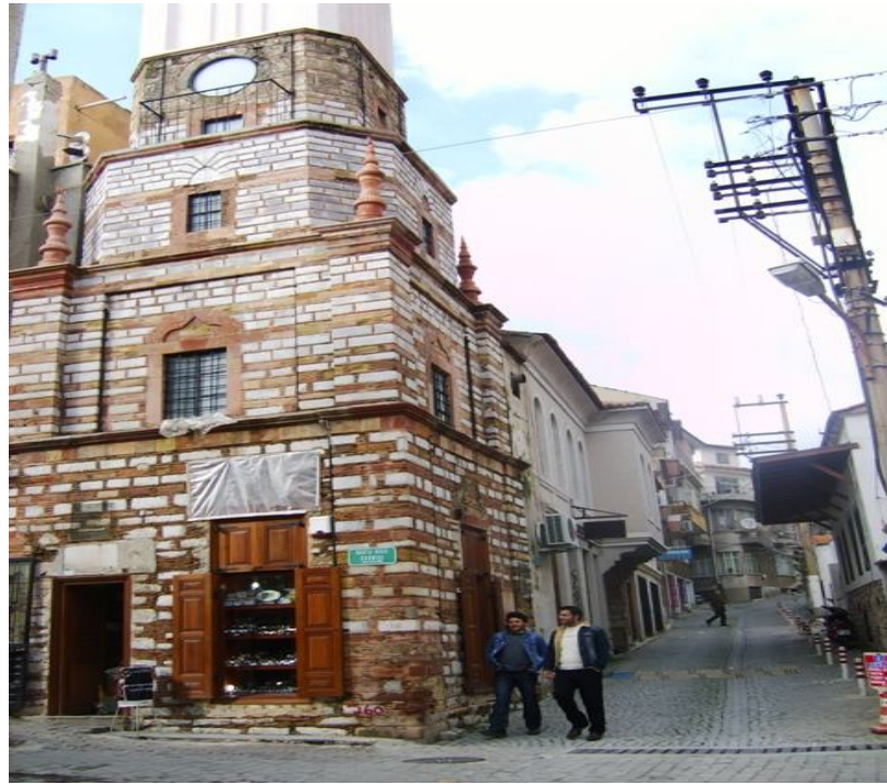
Fotoğraf 43 Saatli Kule Binası Foto: F. Üzeyirođlu 2009
