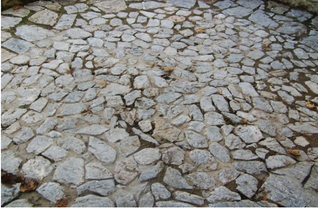
Fotoğraf 95 Dođal Tařlardan Yapılan Yol Kaplaması Foto: F. Üzeyirođlu 2009
