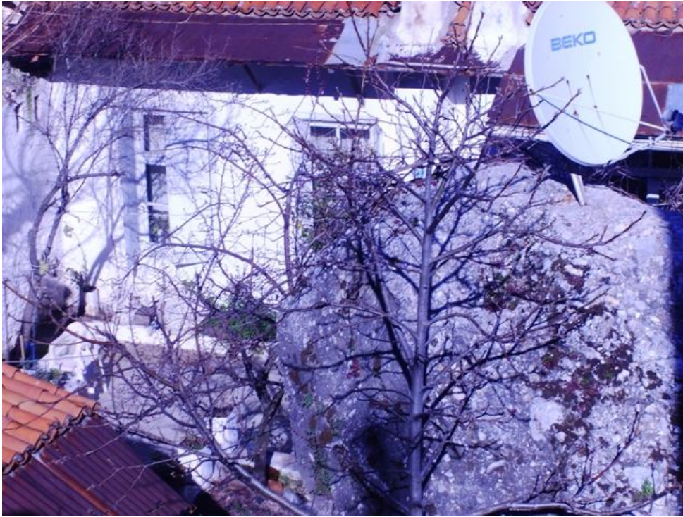
Fotoğraf 69 Kayalarla Bütünleşen Yapı Foto: F. Üzeyirođlu 2009
