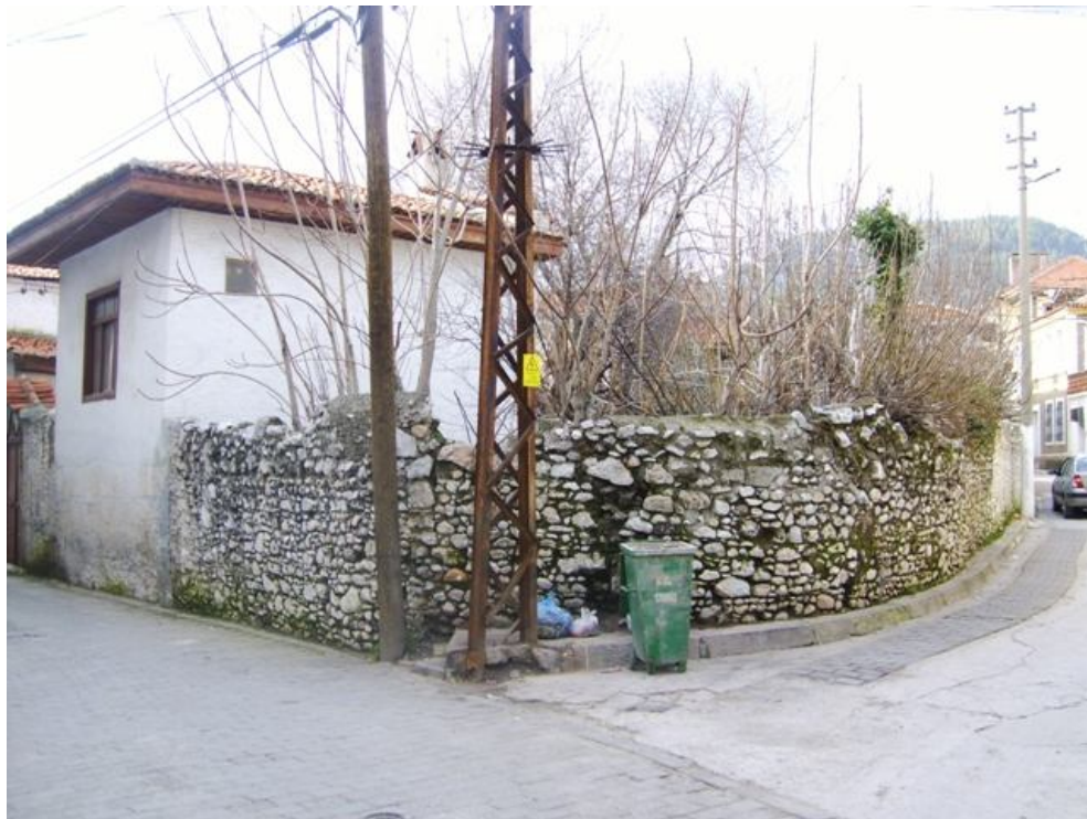
Fotoğraf 55 Saburhane Sokağının Bahçe Sokakla Birleştiği Yer Foto: F. Üzeyiroğlu 2009
