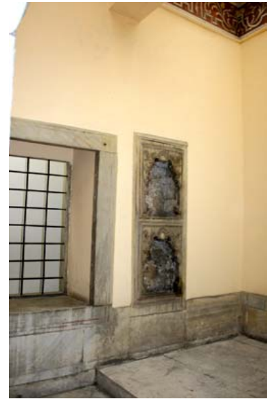
Şekil 4.23: Soğukluk Bölümü sol cephesi
