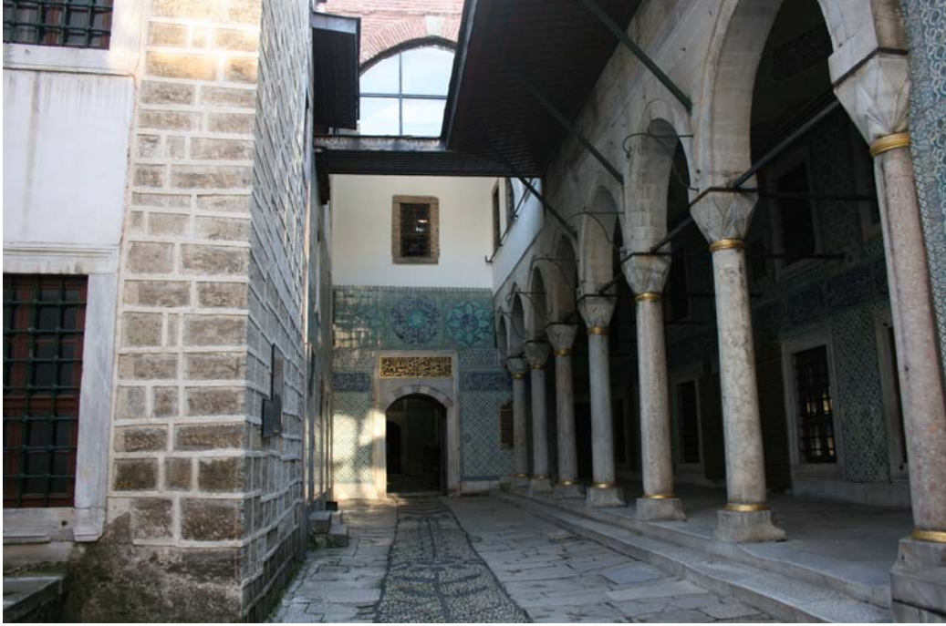
Şekil 4.3: Karaağalar Taşlığı giriş cephesi
