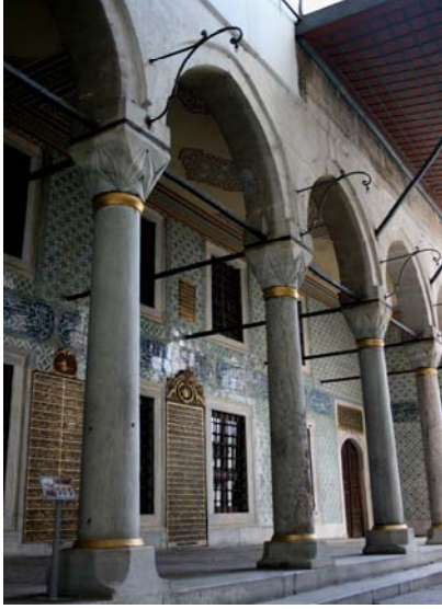
Şekil 4.12: Taşlığın sol cephesindeki revaklı bölüm
