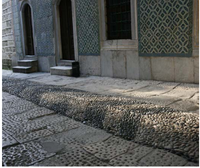
Şekil 4.7: Taşlık döşemesi, oluklu taş yüzeyler
