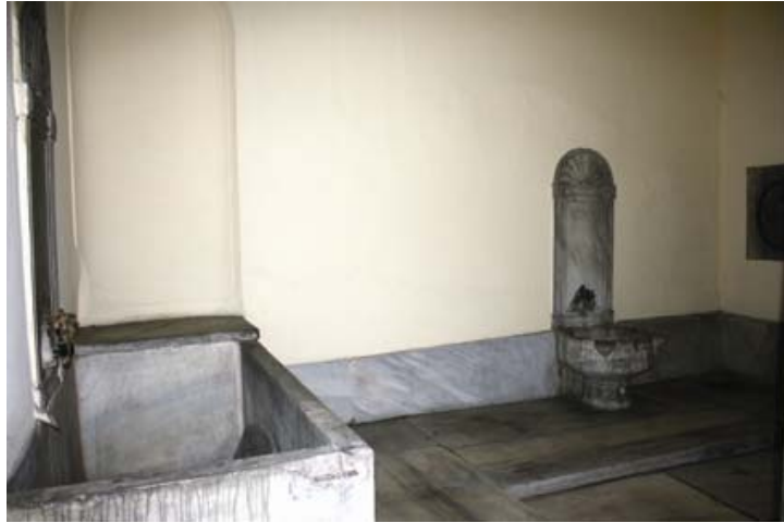
Şekil 4.34: Sıcaklık Bölümü sağ cephesi
