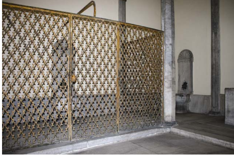
Şekil 4.32: Sıcaklık Bölümü sol cephesi
