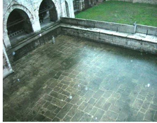
Şekil 4.126: Büyük Havuzun sol (batı) cephesi
