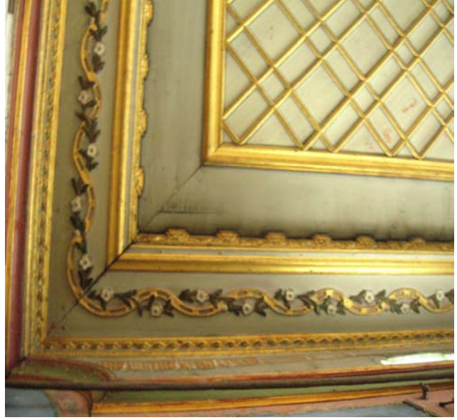
Şekil 2.44: Tavan kaplamasında ahşap üzerine varak uygulaması
