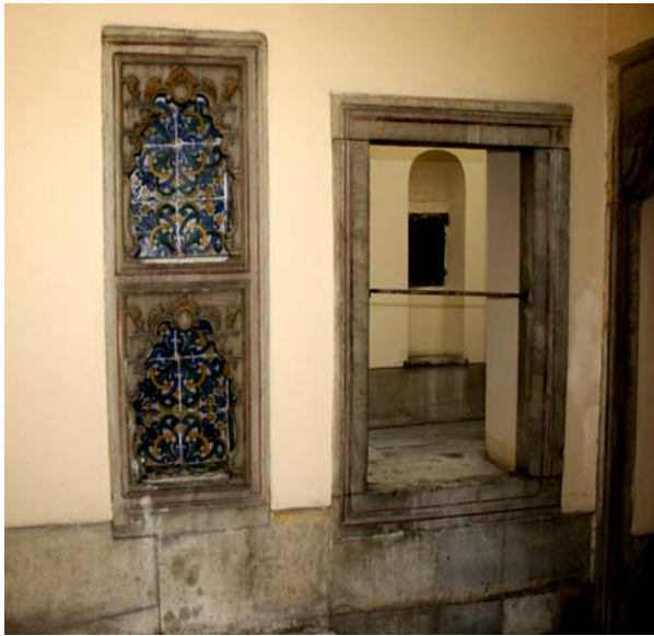
Şekil 4.22: Valide Sultan Hamamı Soğukluk Bölümü sağ cephesi
