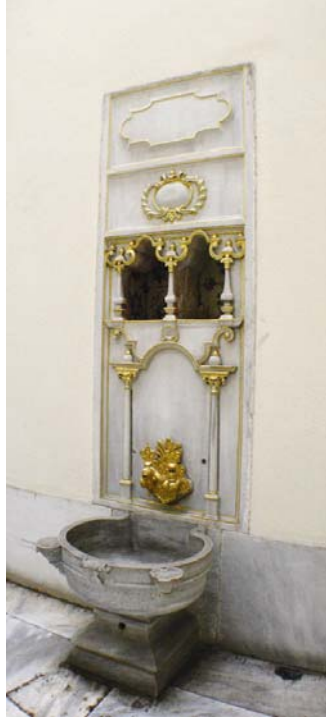
Şeki 4.41: Ilıklık bölümü sol cephesi
