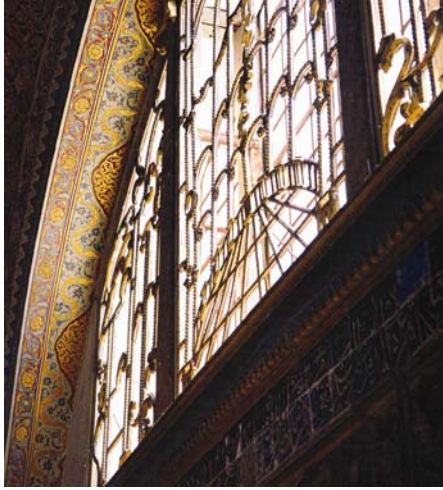
Şekil 4.68: Mekânın giriş cephesinde yer alan eğrisel pencere
