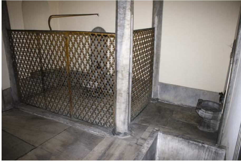
Şekil 4.30: Sıcaklık Bölümünün sol cephesi genel görünümü
