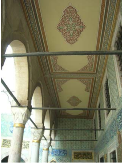
Şekil 2.41: Tavan kaplamasında malakari uygulaması Şekil 2.42: Kubbe yüzeyinde alçı üzerine kalem işi malakari uygulaması
