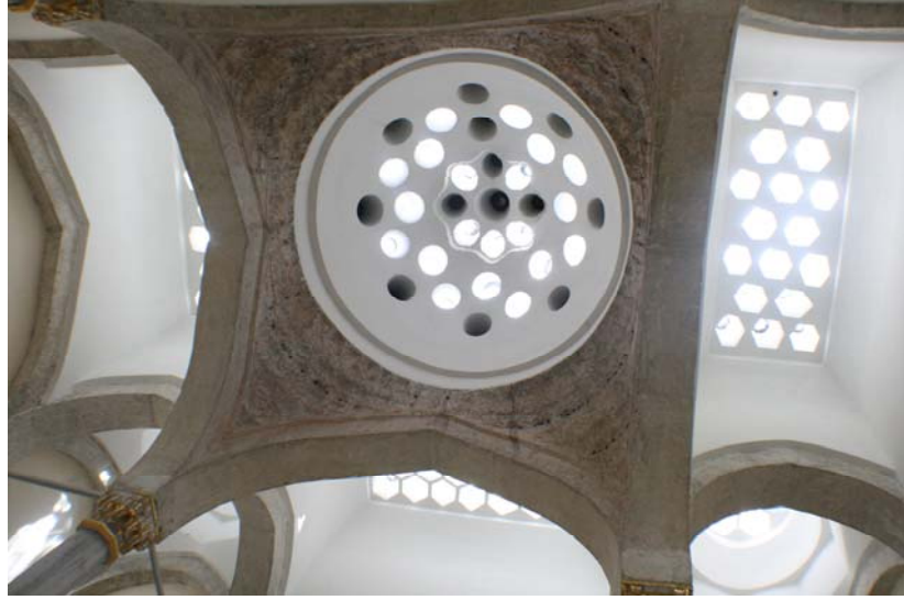
Şekil 4.53: Sıcaklık bölümü girişi üzerinde yer alan fil gözü pencereli kubbe
