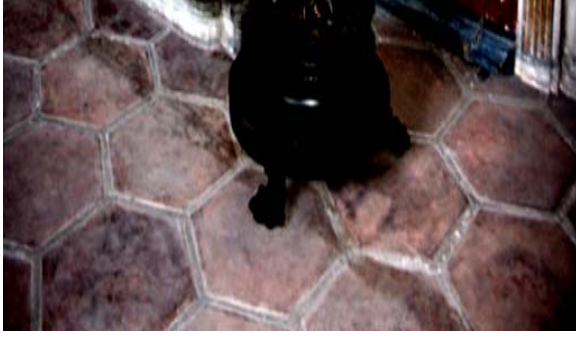
Şekil 4.73: Mekanın Tuğla Taş Döşemesi
