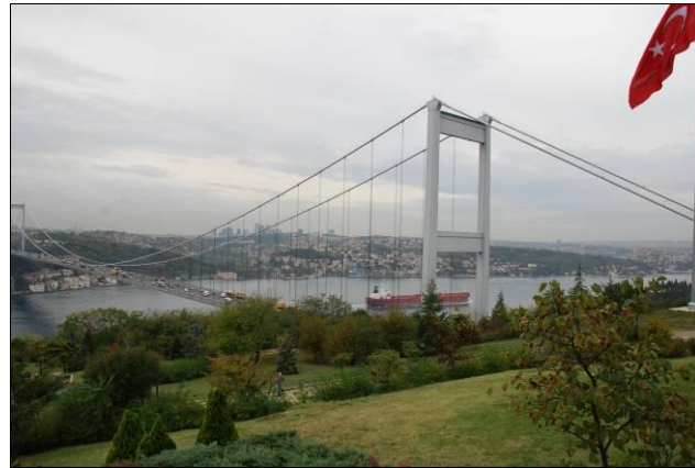
Şekil 2.2.2.6.2.Fatih Sultan Mehmet Köprüsü
