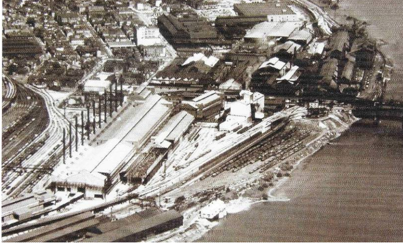
Resim 3.8 Kentin kıyı bölgesinde yer alan eski çelik fabrikası ve çevresinin dönüşüm geçirmeden önceki hali, SouthSide Works, Pittsburgh, Pennsylvania/ABD (2002). [41]
