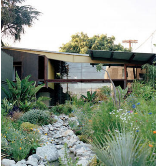
Şekil 5.28. Bahçe ve Ön Cephe (URL-22, 2009).
