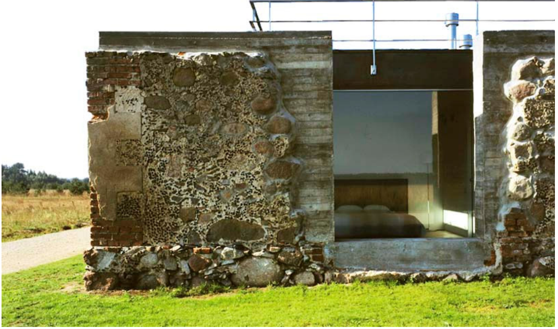
Şekil 5.58. İyileştirilmiş Ambar Duvarları (URL-31, 2009).
