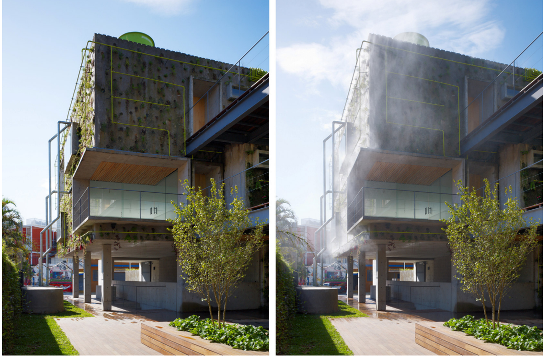
Şekil 5.18. Dış Cepheye Kurulu Sulama Sisteminin Çalışması (URL-20, 2009).
