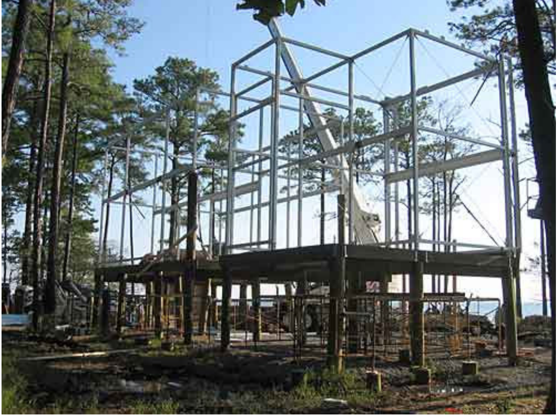
Şekil 5.8. Yapı İskeleti (URL-17, 2009).
