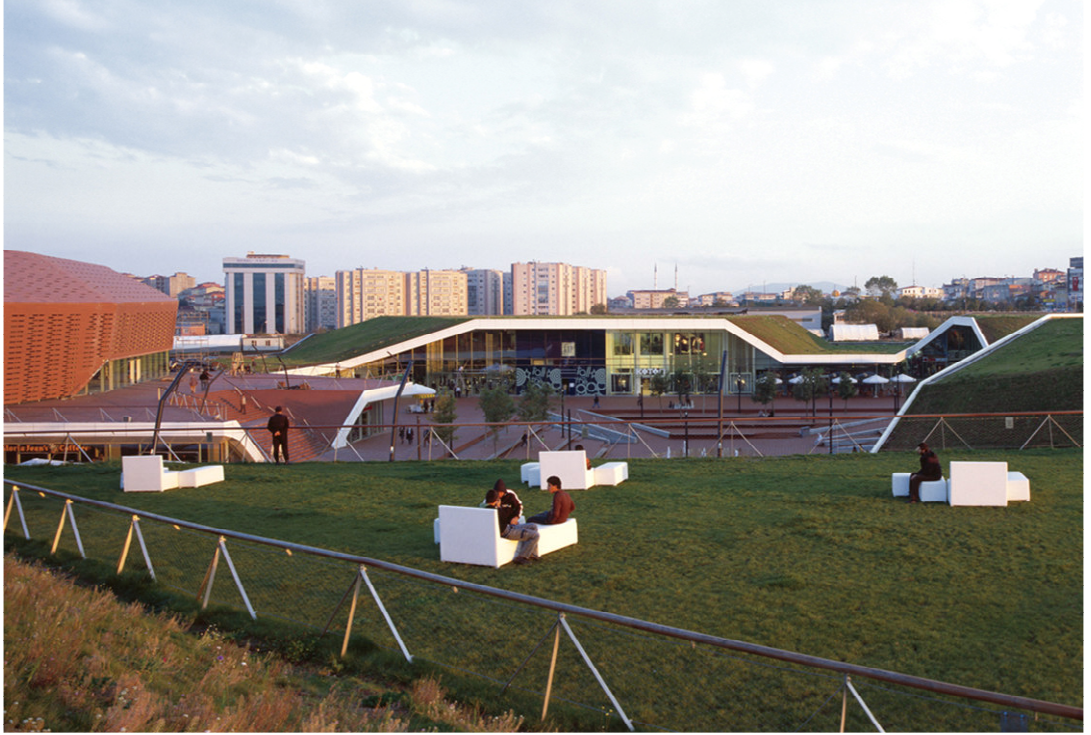
Şekil 5.91. Yeşil Çatılar ve Kullanımı (URL-54, 2009).
