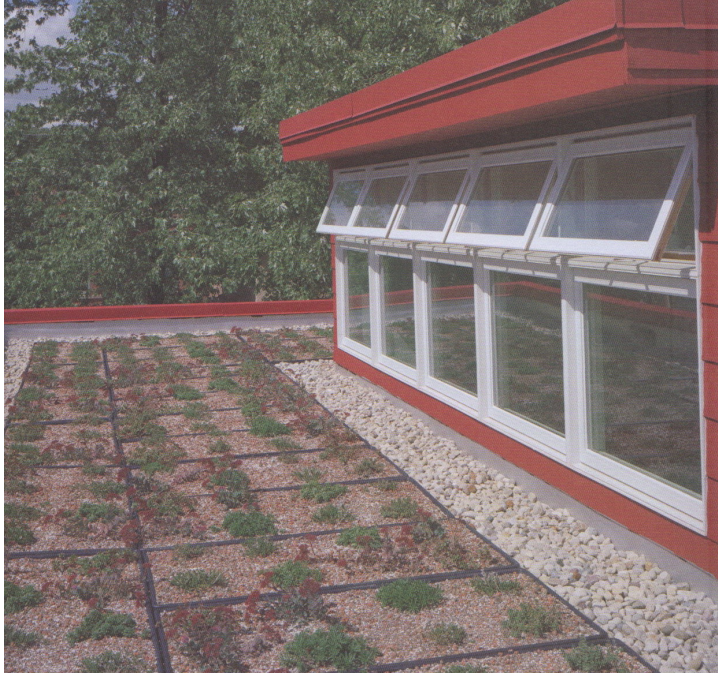
Şekil 5.24. Yeşil Çatı ve Isı Bacası Üzerindeki Pencereleler (Duran, 2007).
