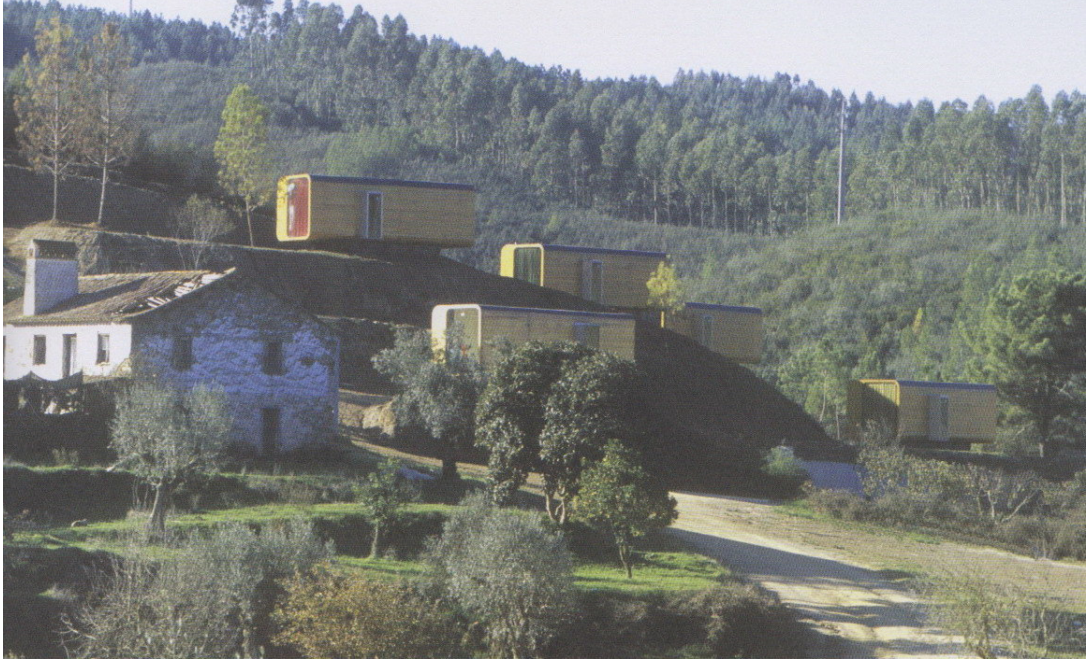
Şekil 5.12. Genel Görünüş (Duran, 2007).
