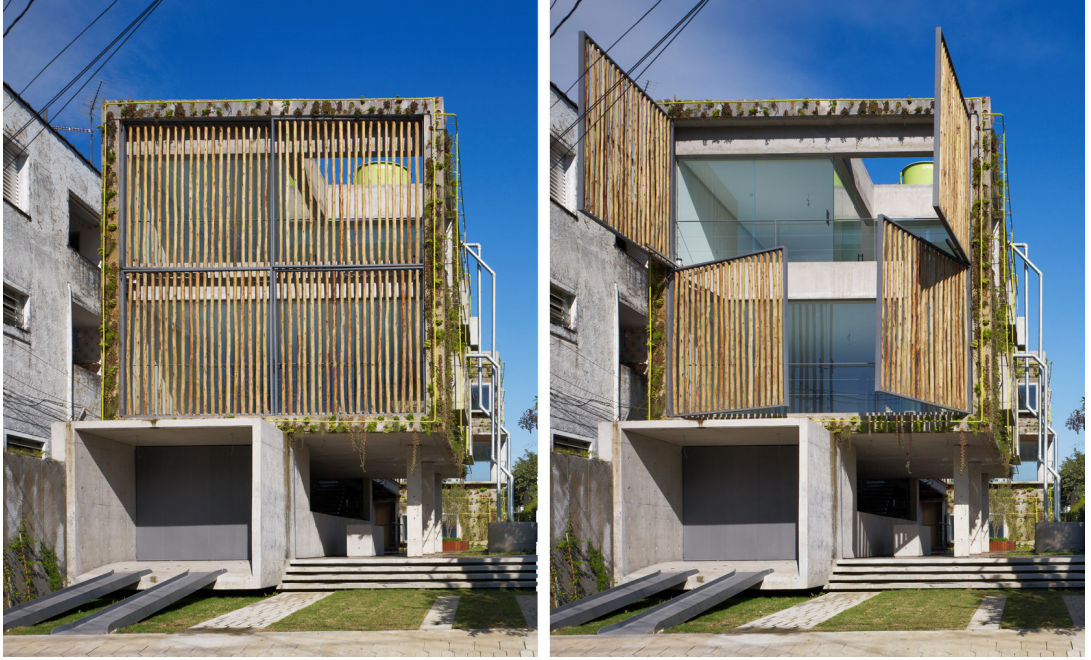
Şekil 5.20. Ön Cephe ve Ahşap Güneş Kırıcılar (URL-20, 2009).
