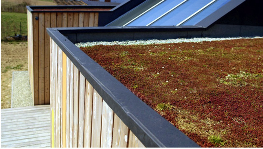
Şekil 5.36. Yeşil Çatı ve İşlenmemiş Ahşaplar (URL-23, 2009).
