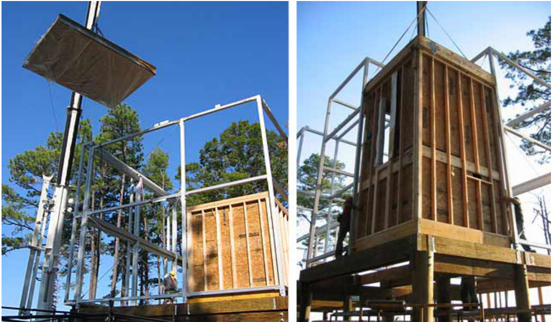
Şekil 5.9. İnşaat Aşaması (URL-17, 2009).
