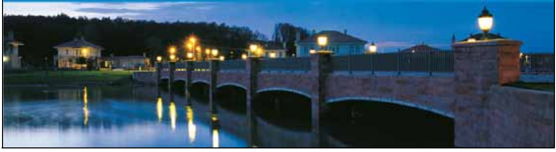
Şekil 4.24: Kasaba Evleri yerleşmesi genel görünüm
