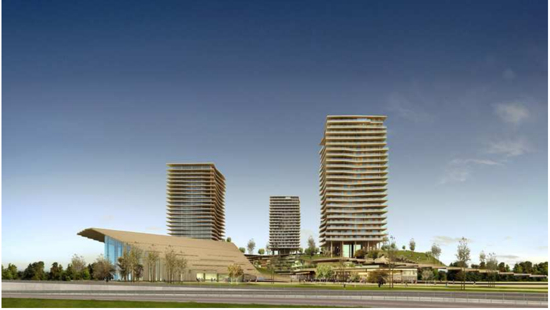
Şekil 5.38. EAA-Tabanlıoğlu Mimarlık Genel Görünüm (URL-19, 2009)
