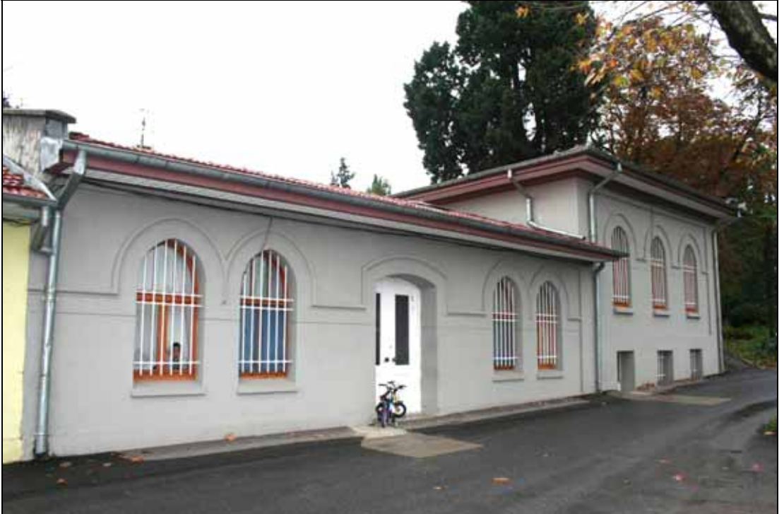
Resim61 Lojman Binası Cephesi (Büyükseçgin, İ., Kandilli, Aralık 2008)
