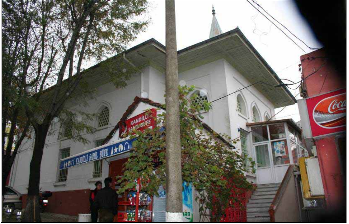
Resim40 Kandilli Camii Doğu ve Kuzey cepheleri görünüşü (Büyükseçgin, İ., Kandilli, Aralık 2008)
