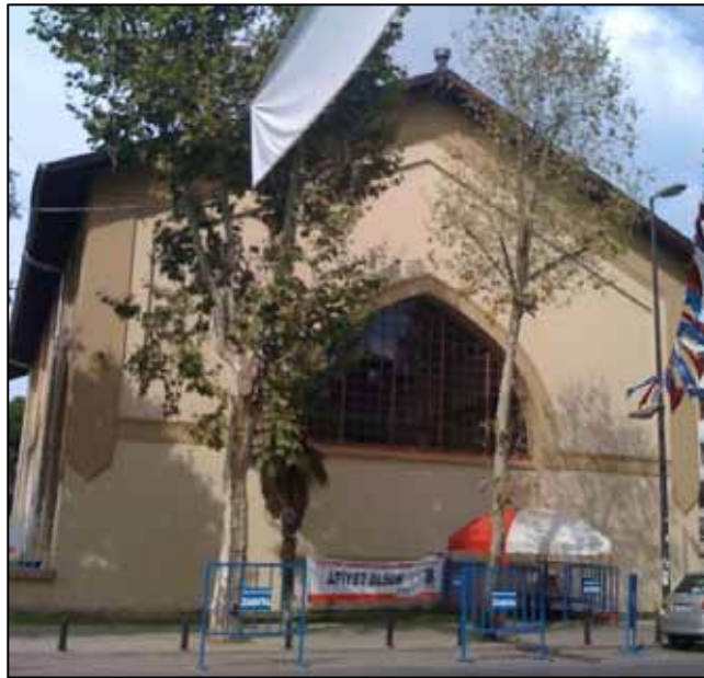
Resim80 Tramvay Muhavvile Merkezi Yan Cephe Görünüşü ( Büyükseçgin, İ., Eylül 2009)
