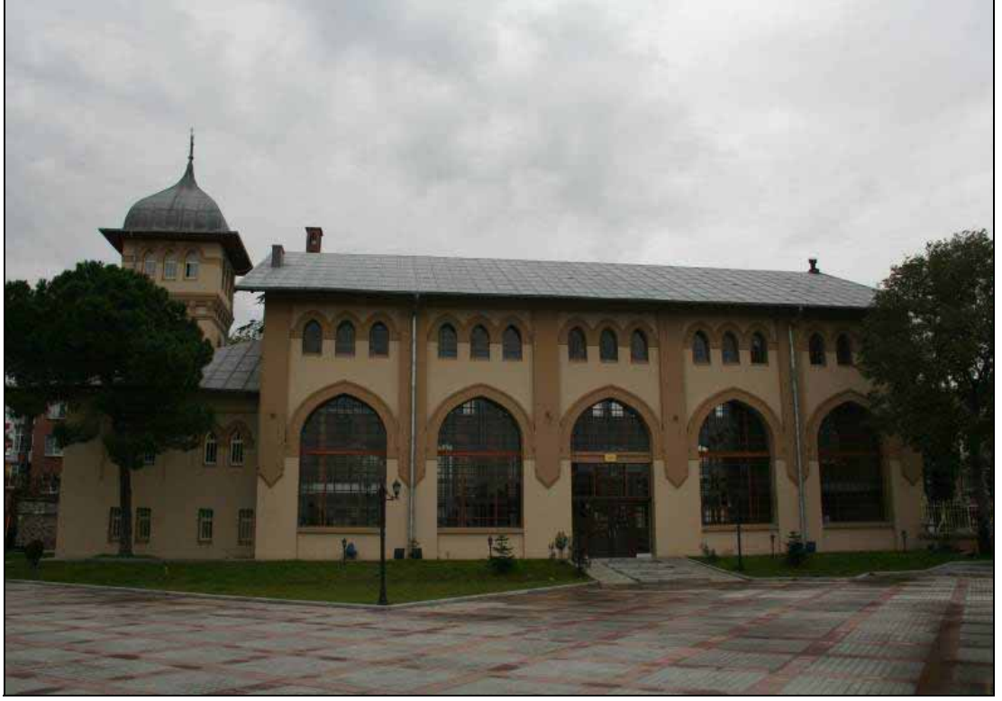
Resim 36 Tramvay Muhavvile Merkezi Giriş Cephesi Görünüşü (Büyükseçgin, İ., Bağlarbaşı, Aralık 2008)
