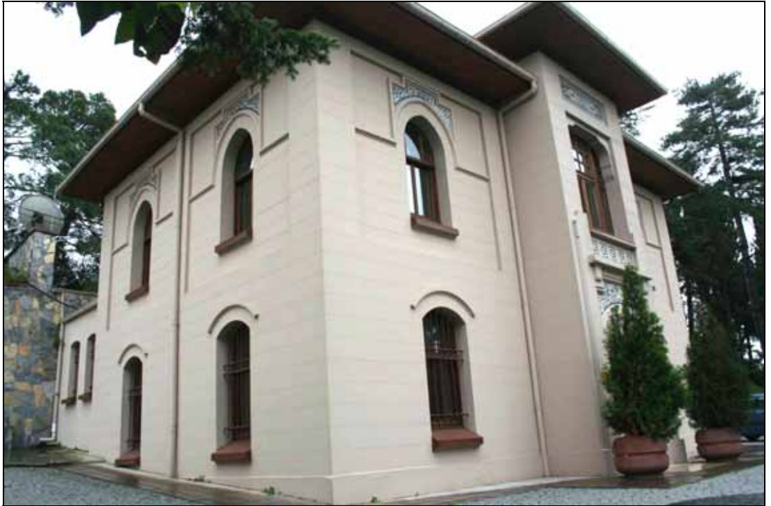
Resim55 Müze Binası Cephesi (Büyükseçgin, İ., Kandilli, Aralık 2008)
