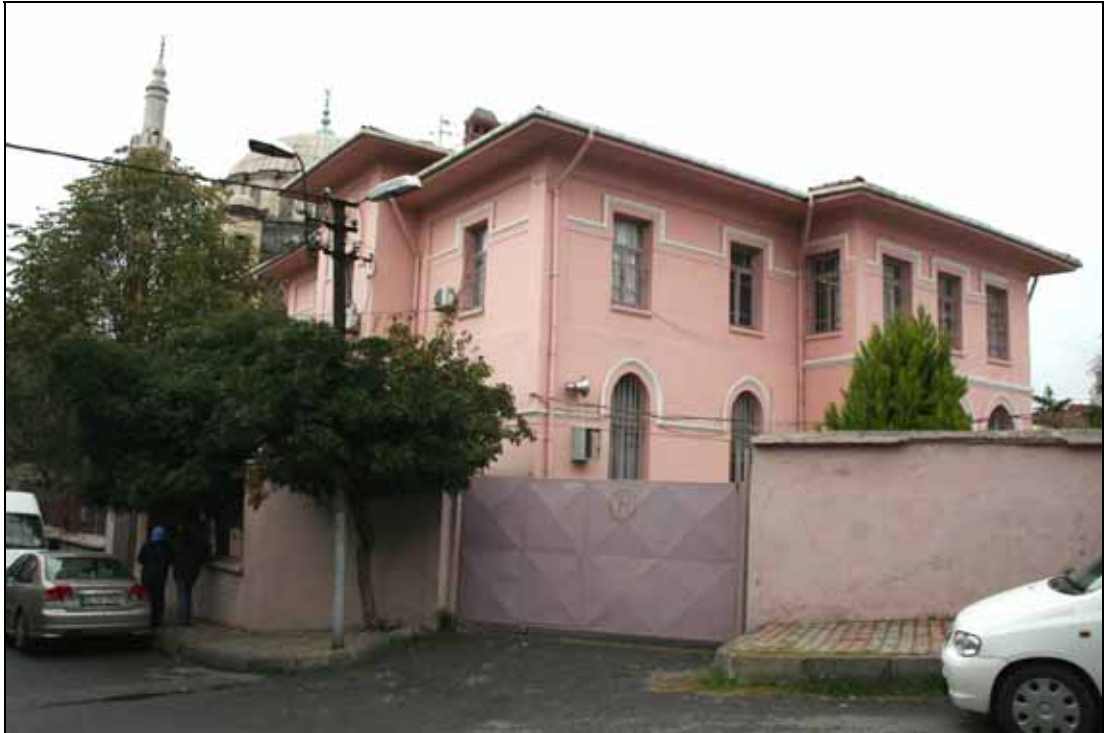
Resim47 Ayazma Mektebi Sağ Yan Cephe (Büyükseçgin, İ., Üsküdar, Aralık 2008)
