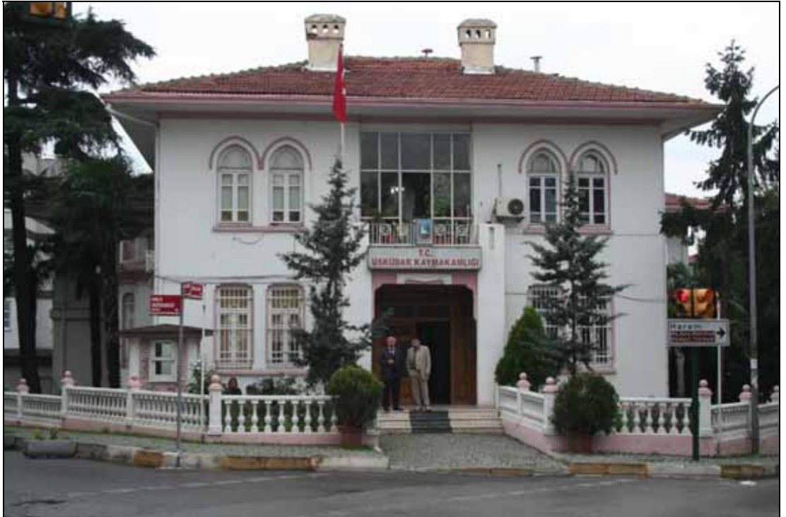
Resim71 Üsküdar Halkevi Binası Giriş Cephesi Görünüşü (Büyükseçgin, İ., Üsküdar, Aralık 2008)
