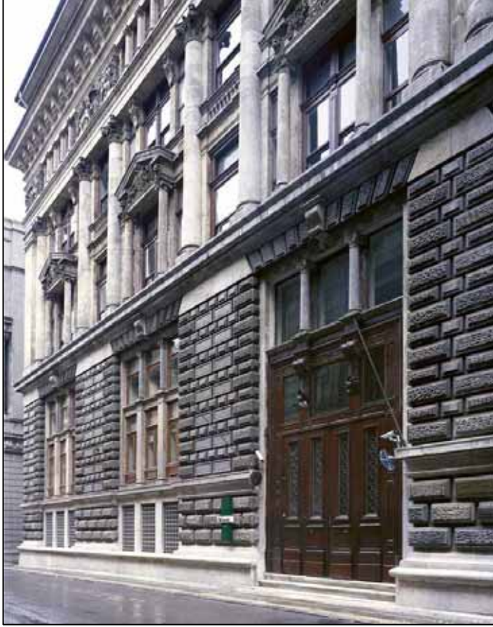
Resim7 Osmanlı Bankası Binası
