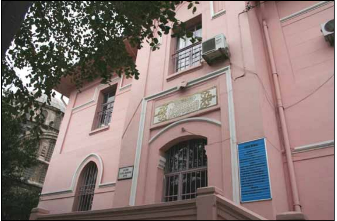
Resim45 Ayazma Mektebi Giriş Cephesi (Büyükseçgin, İ., Üsküdar, Aralık 2008)
