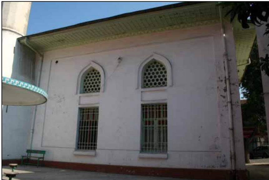
Resim 83 Kandilli Camisi Cephe Bozulmaları (Büyükseçgin, İ., Eylül 2009)
