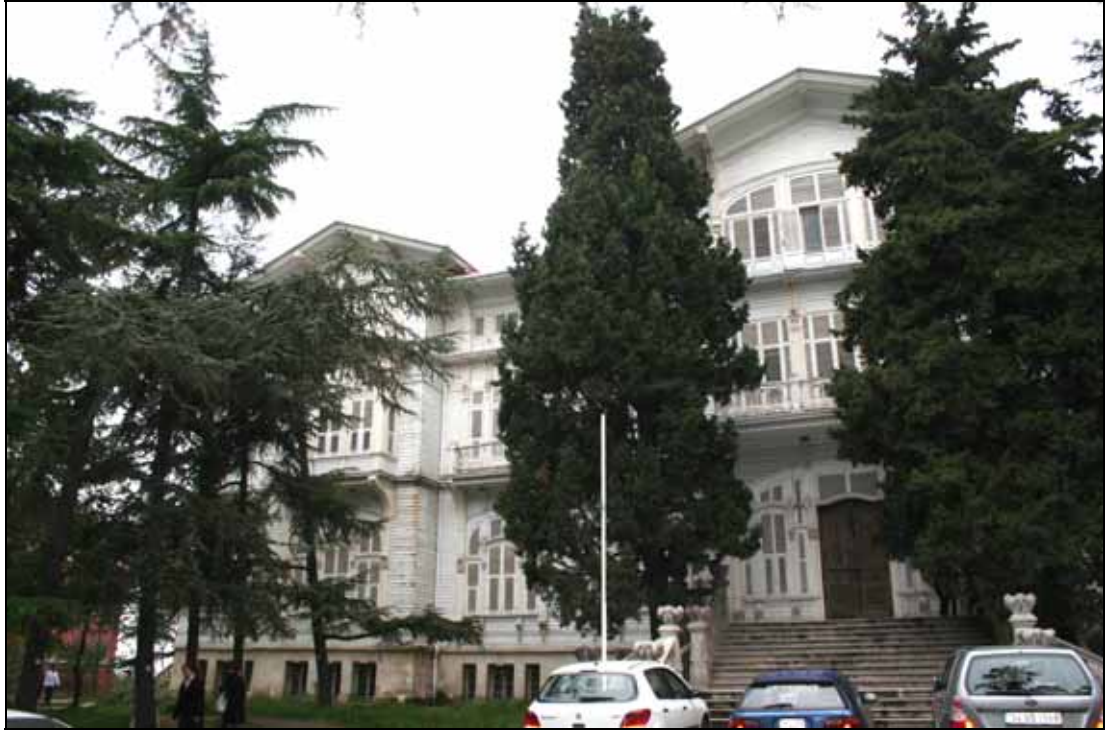
Resim41 Ahmet Ratıp Paşa Köşkü Giriş Cephesi (Büyükeçgin, İ., Acıbadem, Aralık 2008)
