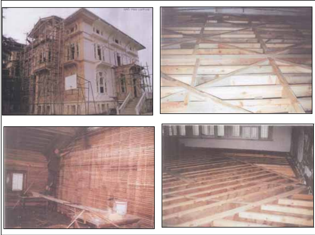
Resim84 Ahmet Ratıp Paşa Köşkü 1999 Onarımları (İstanbul 6 No'lu Koruma Kurulu Arşivi)
