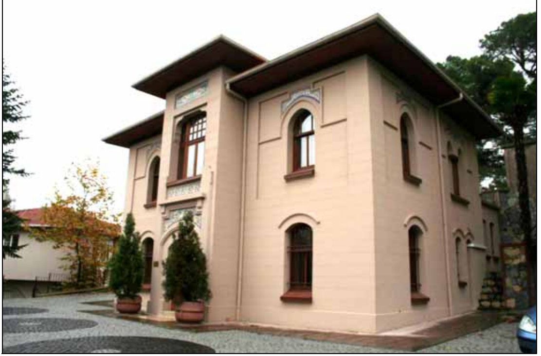
Resim54 Müze Binası Cephesi (Büyükseçgin, İ., Kandilli, Aralık 2008)
