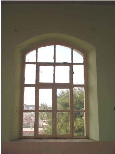
ekil 5.21 Birinci kat pencere iç görünüşü
