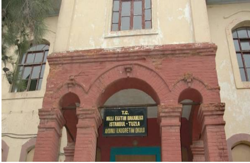
ekil 5.5 Ön cephe tu la kemer detay,
