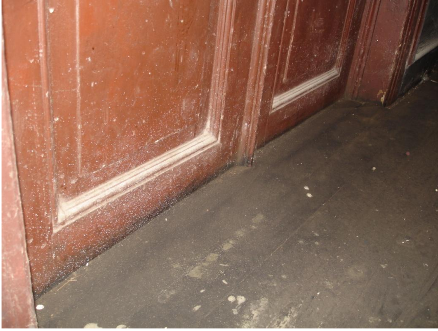
ekil 5.10 lave dö emeden dolay, kapanan kap,
