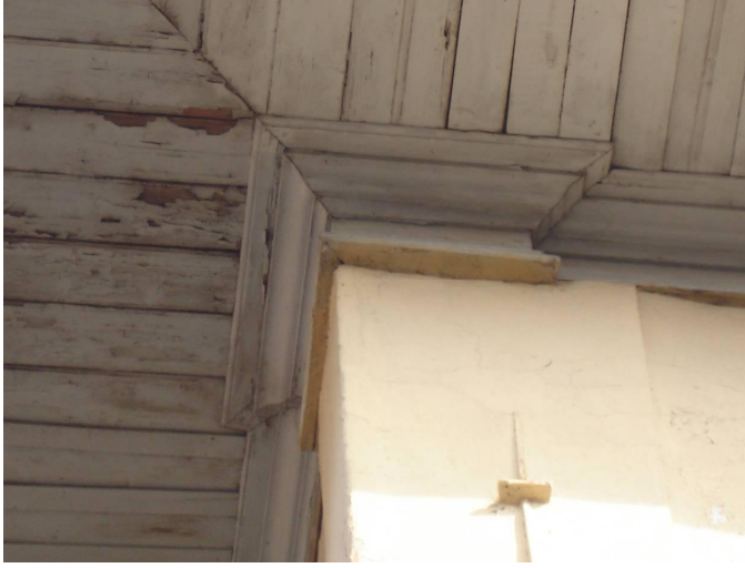
Resim 5.22 Ahap saçak tavan silmesi detay,
