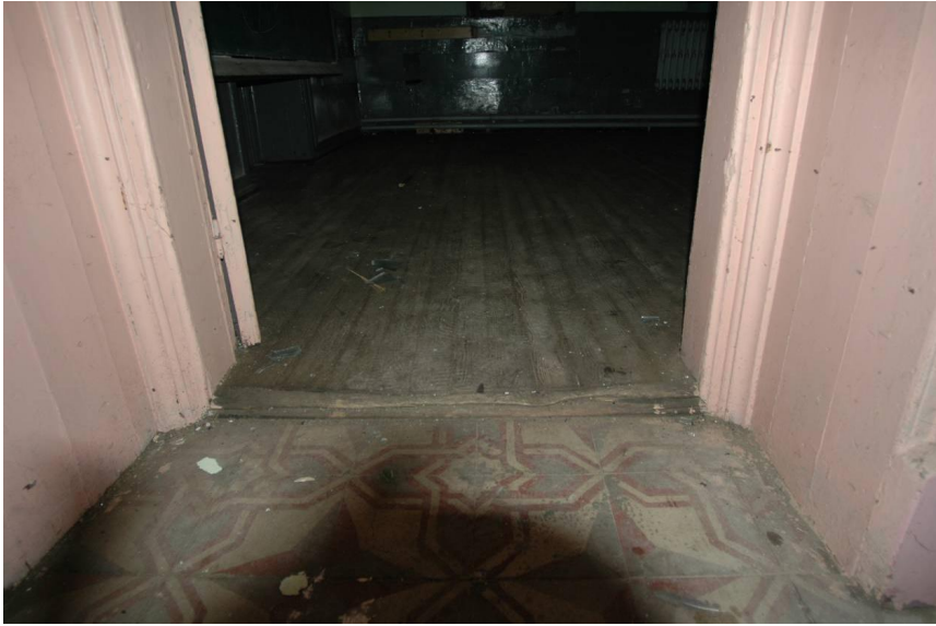
ekil 5.11 Zemin kat s,n,flar,na mevcut ah ap kaplama üzerine yap,lm, ah ap kaplama
