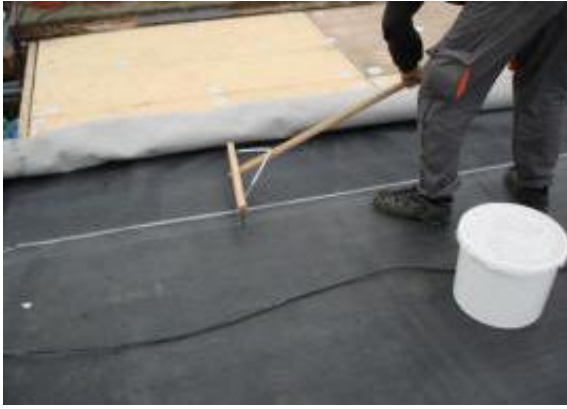
Resim 3.10 Teras çat,ya membran uygulaması,
