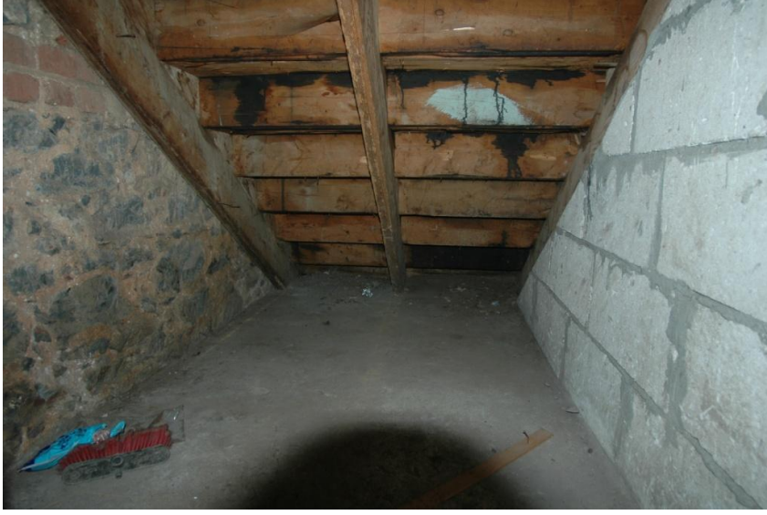
ekil 5.15 Ah ap merdiven konstrüksiyonu ve ytong duvar
