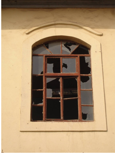
ekil 5.20 Birinci kat pencere dış görünüşü ve pencere kenar, siva sövesi.
