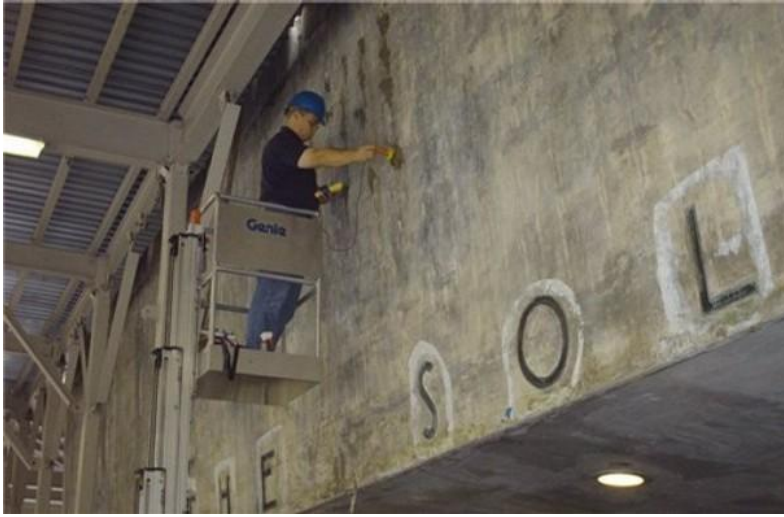
ekil 3.1 Solomon R. Guggenheim Müzesi New York. Binada bak,m çal, malar, yap,l,rken yap, kabu unda olu mu pas lekerinin test edilmesi.
