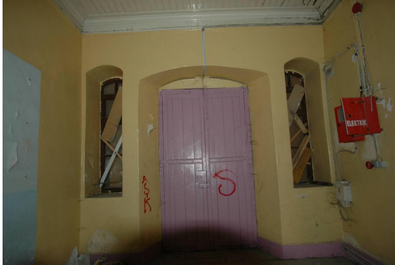
ekil 5.18 Bina ana giri kap,s, ve yan pencereleri iç görünü ü
