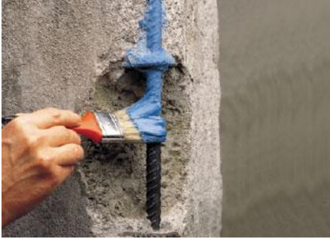
ekil 3.3 Paslanm, çeli e koruyucu tabaka uygulanması,
