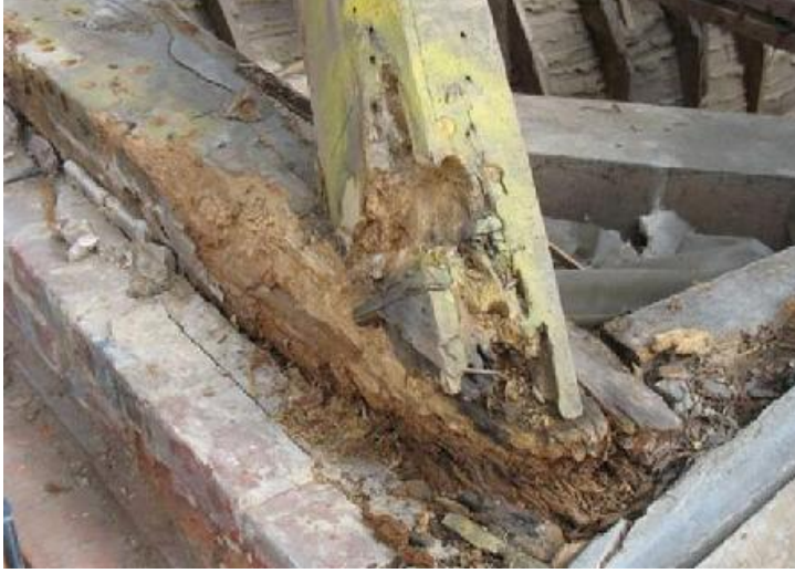
ekil 2.4 Nem ve böcek saldırılarının dolay, ahaptay, c, eleman, n çürümesi
