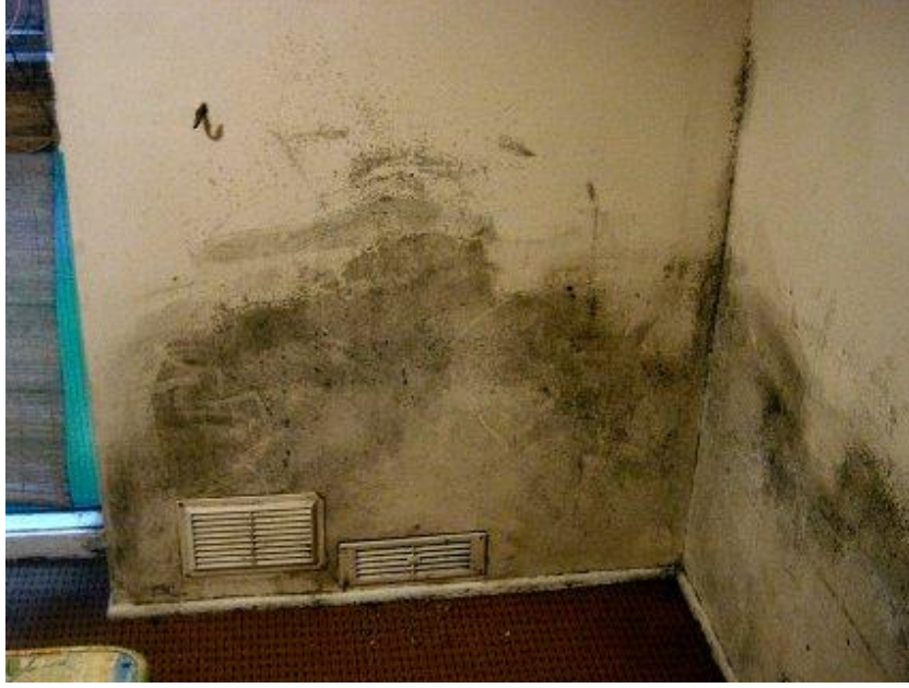
ekil 2.3 Islak mekanda duvardaki yo u ma
