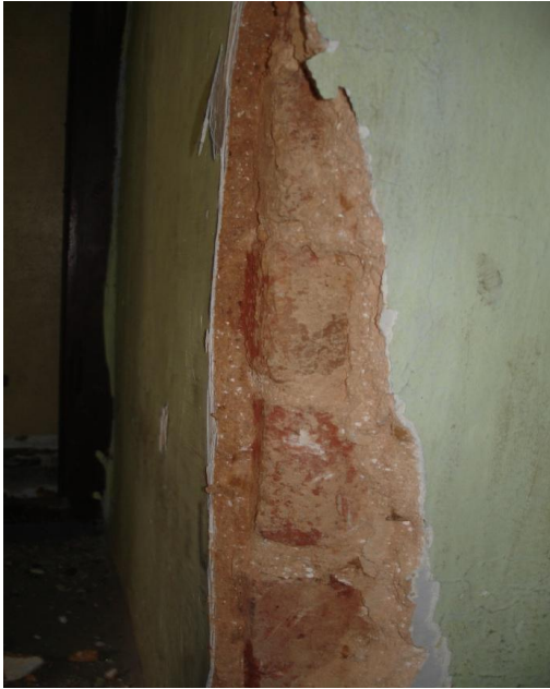
ekil 5.8 Y, ma duvar ve horasan s,va
