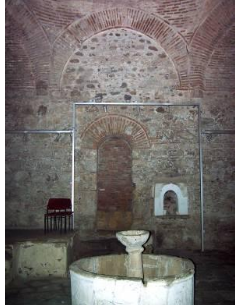
Resim 4.49 Erkekler kısmı sonradan açılan ve tekrar kapatılan kapı
