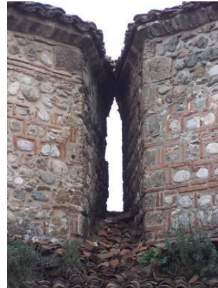
Resim 4.47 Çatı örtüsü – Soğukluk bölümleri, kasnak aralarında üçgen
