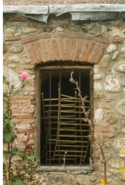
Resim 4.35 Güney Cephesi - Kadınlar kısmı tarafında yer alan pencere
