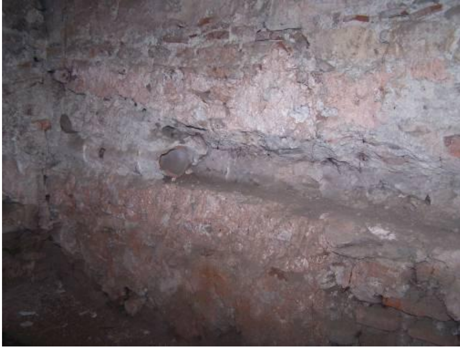
Resim 4.101 Sıcaklık bölümü - Halvet'te duvar içinde yer alan su künkleri
