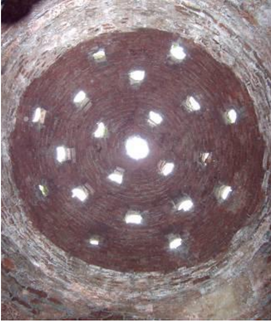
Resim 4.102 Sıcaklık bölümü Halvet kubbesi
