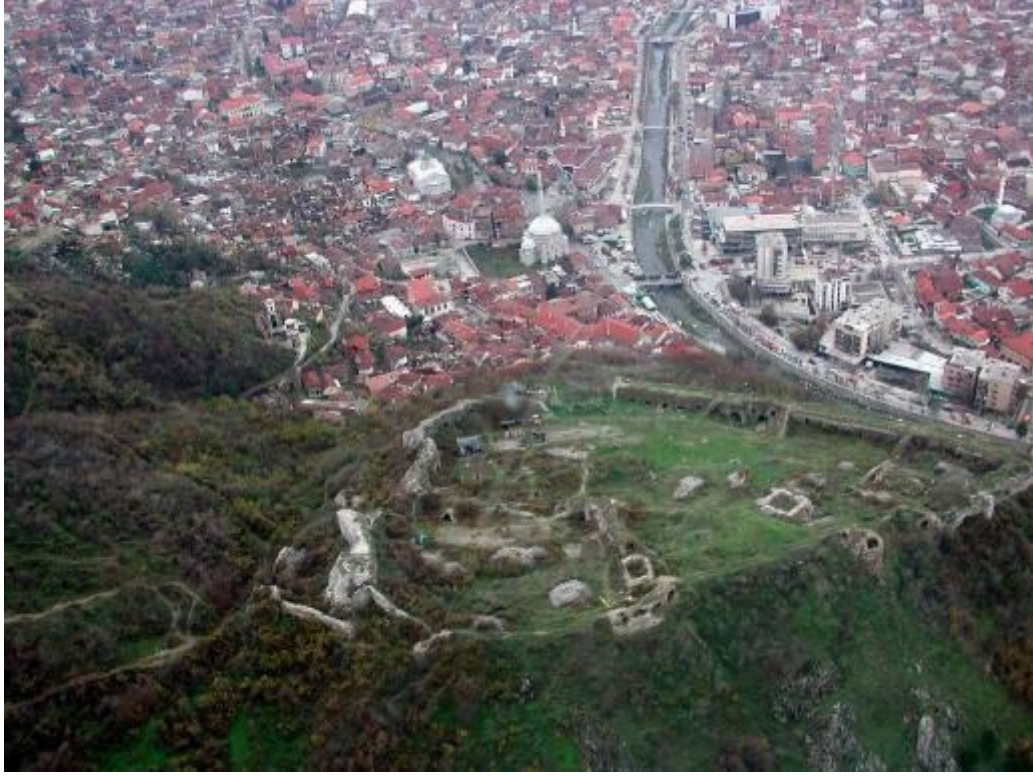
Resim 2.1 Prizren – Prizren Kalesi ve şehir görünümü (Anonim)
