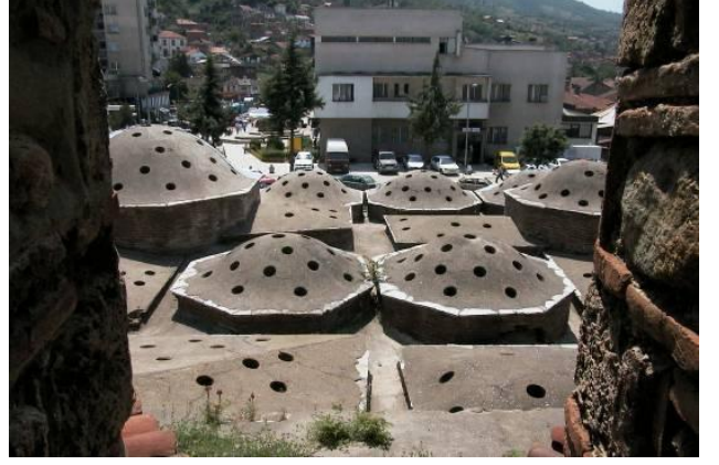
Resim 4.39 Çatı örtüsü – Genel görünüm (Prizren – Anıtlar Koruma Enstitüsü'nden)
