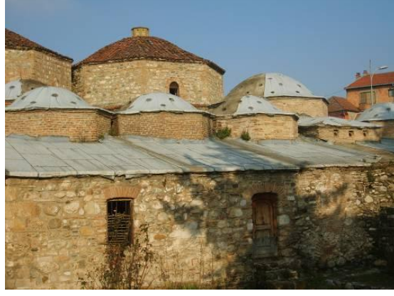
Resim 4.32 Güney Cephesi– Sıcaklık bölümü kubbeleri
