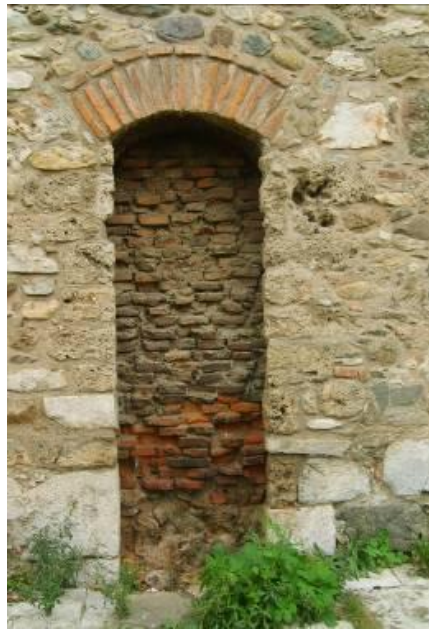
Resim 4.11 Sonradan açılmış ve tekrar kapatılmış Erkekler kısmı kapısı
