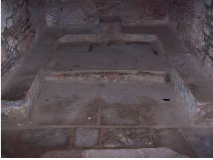
Resim 4.72 Sıcaklık bölümü Eyvan oturma sekileri
