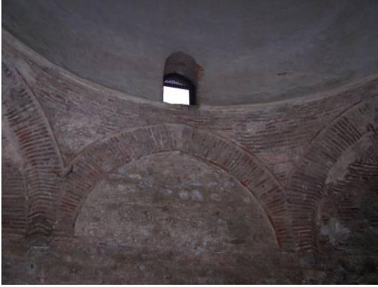
Resim 4.50 Erkekler kısmı Soğukluk bölümü, kasnak ve kasnak penceresi
