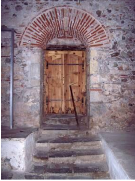
Resim 4.48 Erkekler kısmı Soğukluk bölümü giriş kapısı
