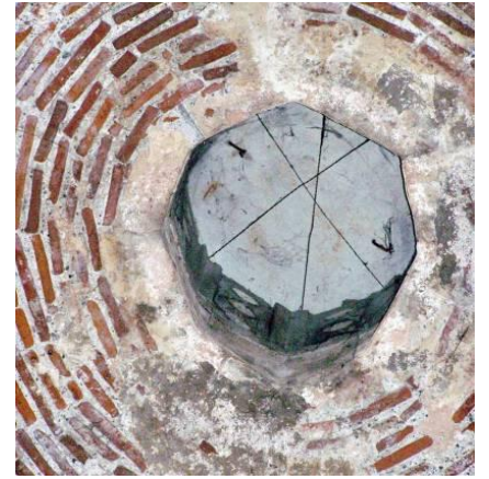
Resim 4.87 Kadınlar kısmı – Soğukluk bölümü çatı feneri
