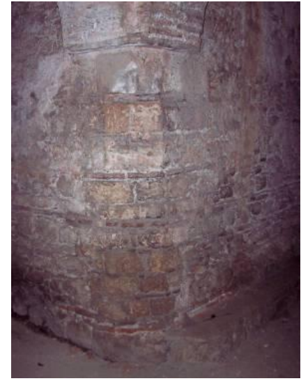
Resim 4.98 Kadınlar kısmı - Sıcaklık bölümünde kemer birleşimi
