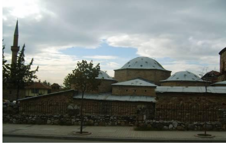
Resim 4.15 Doğu Cephesi – Sıcaklık Kısmı
