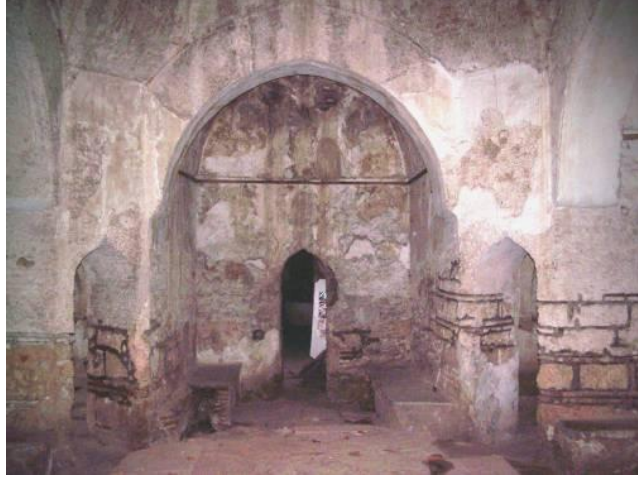
Resim 4.68 Erkekler kısmı Sıcaklık bölümü
