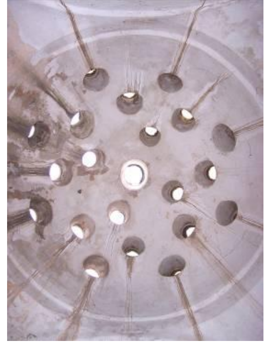
Resim 4.77 Sıcaklık bölümü Halvet kubbeleri ve ışık gözleri
