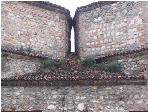
Resim 4.46 Çatı örtüsü – Soğukluk bölümleri, kasnak aralarında üçgen kısımlar
