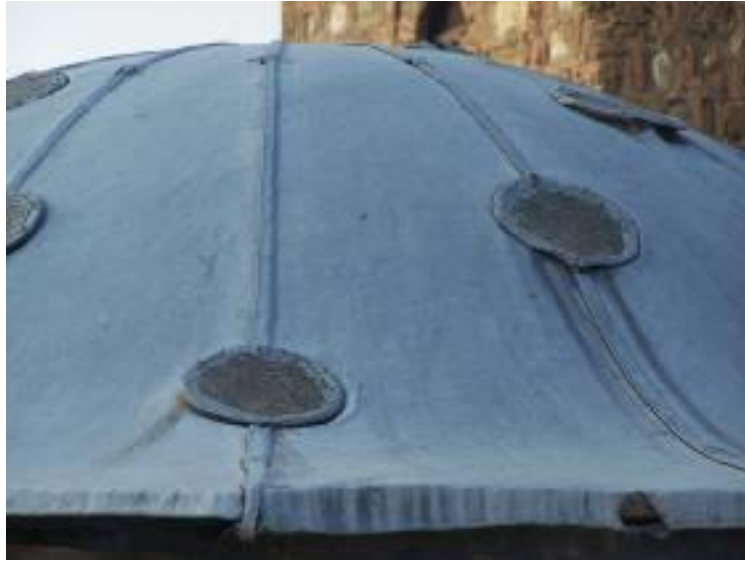
Resim 4.21 Sıcaklık bölümü Halvet kubbesi - Kurşun ve ışık gözü detayları
