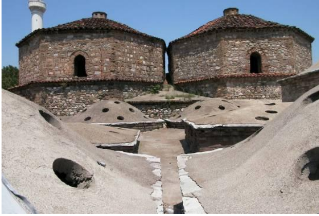
Resim 4.38 Çatı örtüsü – Genel görünüm (Prizren – Anıtlar Koruma Enstitüsü'nden)
