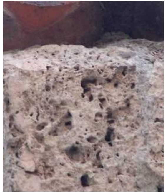
Resim 4.26 Doğu Cephesi – Silme detayı
