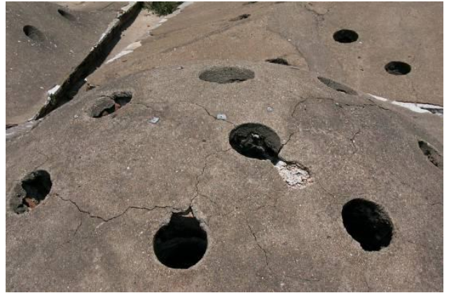
Resim 4.41 Çatı örtüsü – Kubbe'de ışık gözü detayı (Prizren – Anıtlar Koruma Enstitüsü'nden)
