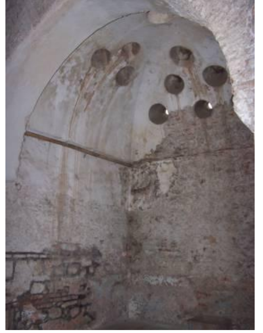
Resim 4.73 Sıcaklık bölümü Eyvan tonozu
