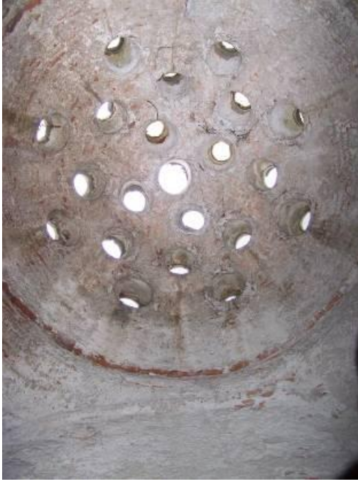
Resim 4.76 Sıcaklık bölümü Halvet kubbeleri ve ışık gözleri
