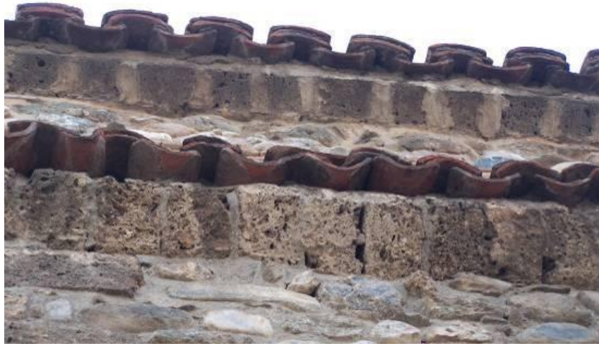
Resim 4.24 Doğu Cephesi – Silme
