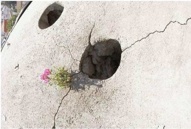
Resim 4.40 Çatı örtüsü – Kubbe'de ışık gözü detayı (Prizren – Anıtlar Koruma Enstitüsü'nden)
