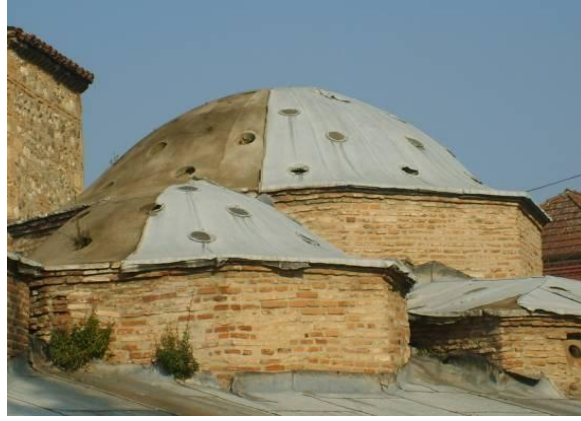
Resim 4.33 Güney Cephesi– Sıcaklık bölümü kubbeleri
