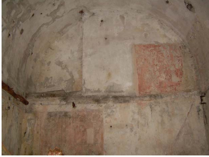
Foto 47 20 No'lu parsel iç görünüş
