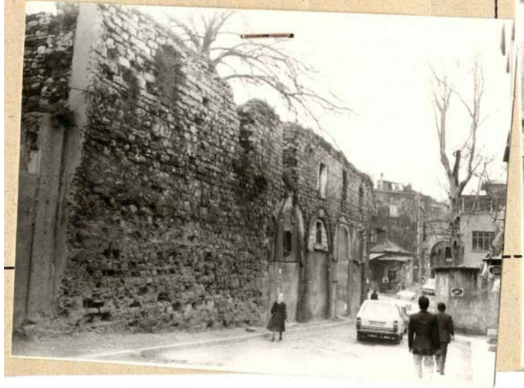
Foto 8 1970'li yıllara ait cephe fotoğrafı
