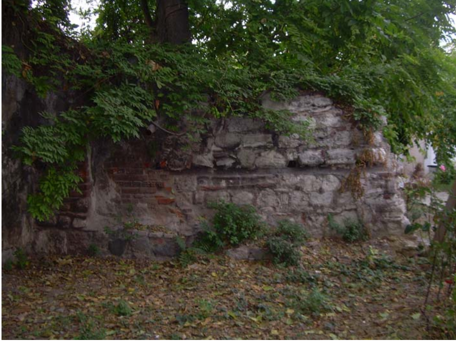
Foto 55 21 No'lu parsel üst kot
