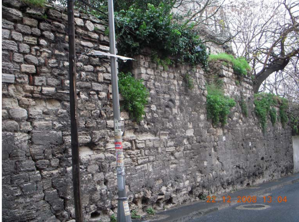
Foto 85 Süleymaniye Caddesi 2,3,4 parsel cephesi
