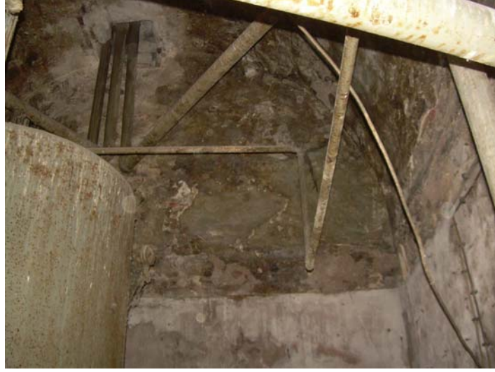
Foto 72 25 No'lu parsel iç mekan
