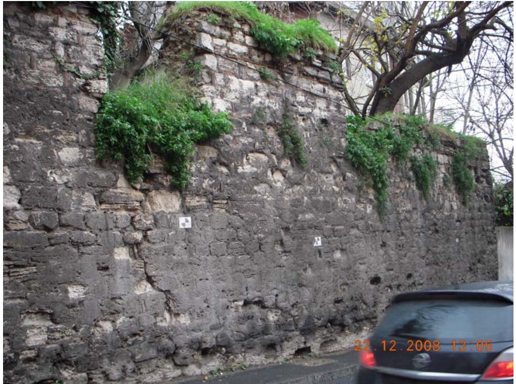
Foto 89 Süleymaniye Caddesi 3-4 parsel cephesi
