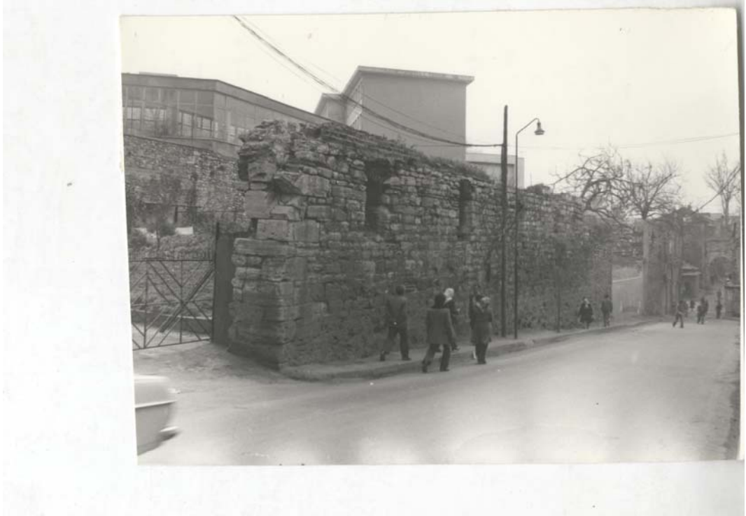
Foto 24 1980'li yıllara ait cephe fotoğrafı (Yenileme Kurulu Arşiv Dosyası)
