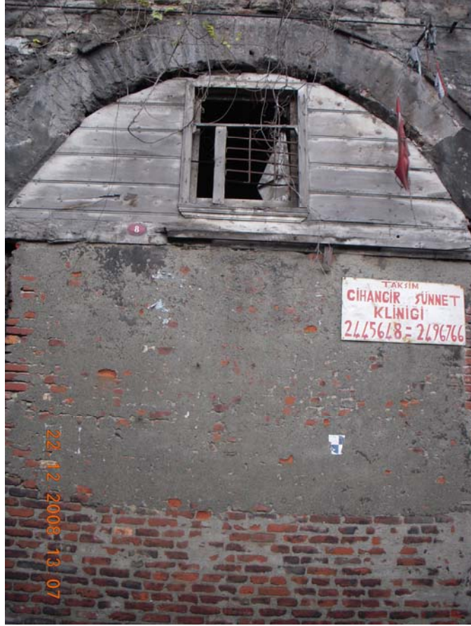
Foto 94 Süleymaniye Caddesi 26 parsel cephesi
