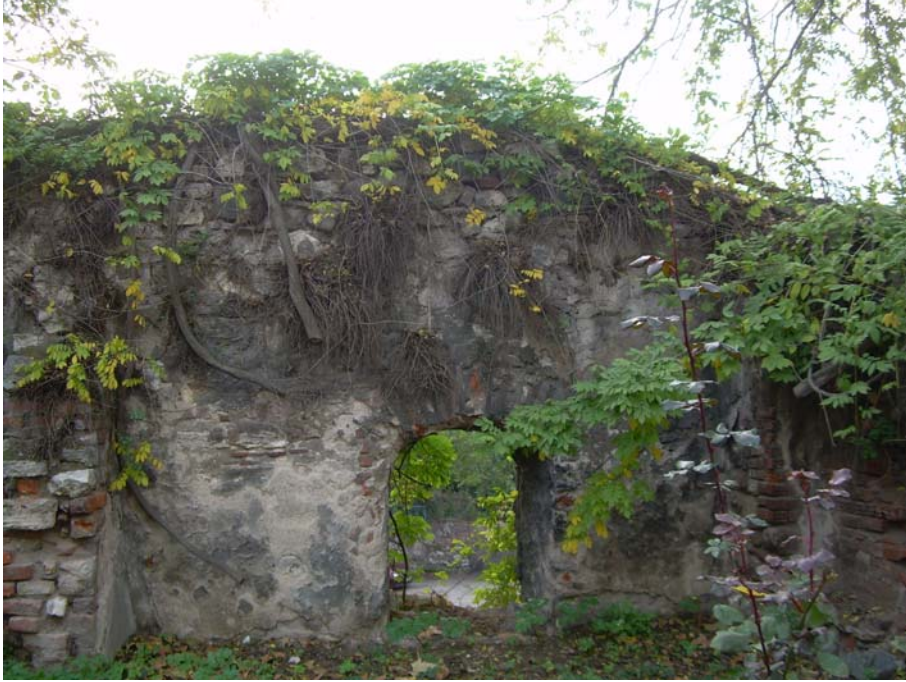
Foto 54 21 No'lu parsel üst kot
