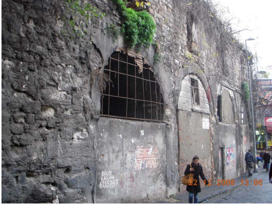
Foto 92 Süleymaniye Caddesi 24-25-26-27 parsel cephesi
