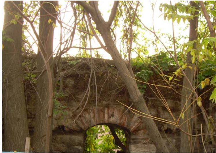
Foto 60 22 No'lu parsel cephe üst kot yoğun bitkilenme
