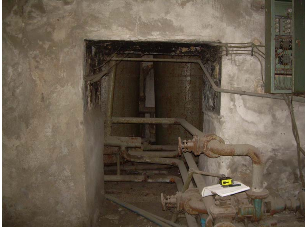
Foto 68 24 No'lu parsel sonradan açılan kapı boşluğu
