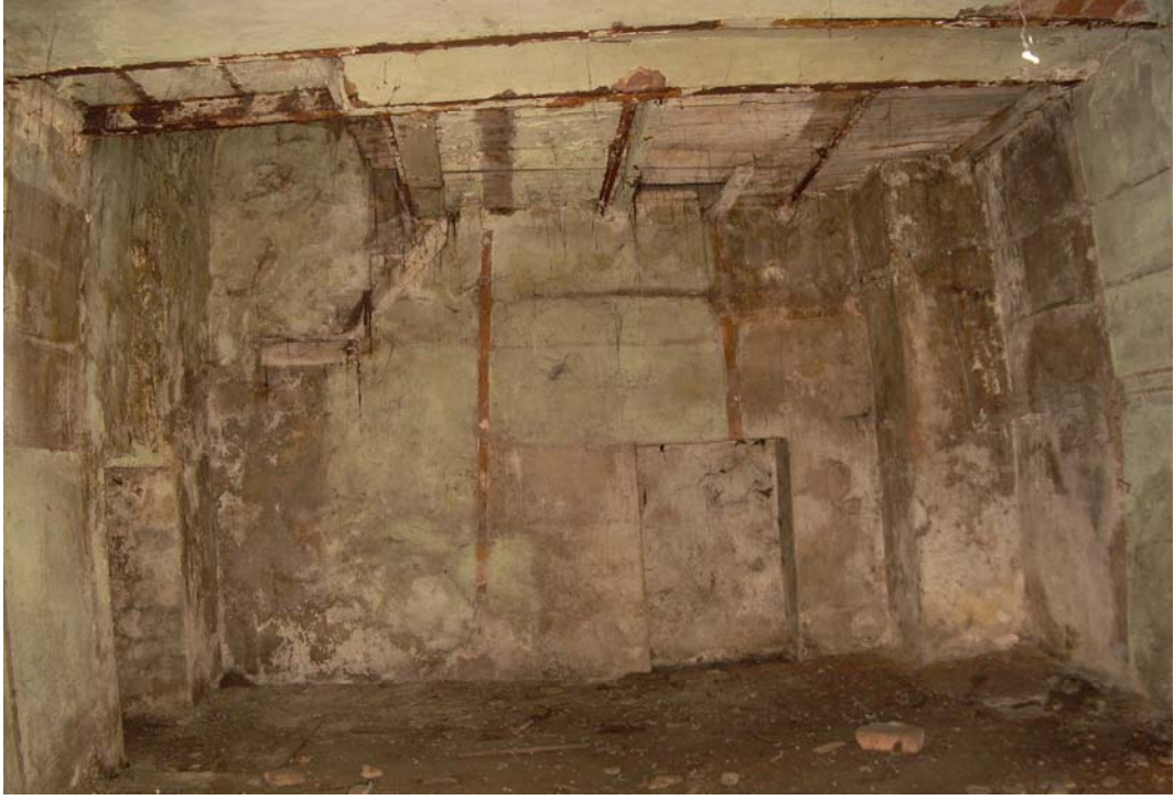
Foto 41 18 No'lu parsel iç mekan
