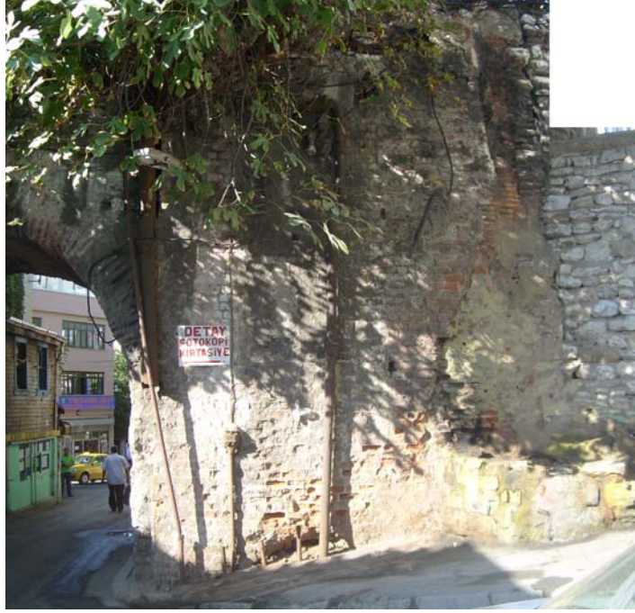
Foto 30 16 parsel güney duvarı
