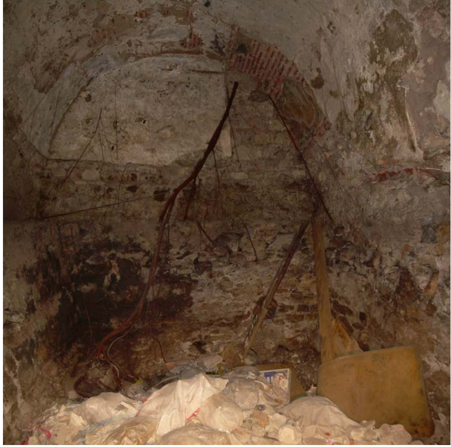
Foto 45 19 No'lu parsel iç görünüş
