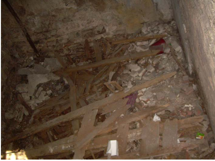
Foto 57 22 No'lu parsel iç görünüş
