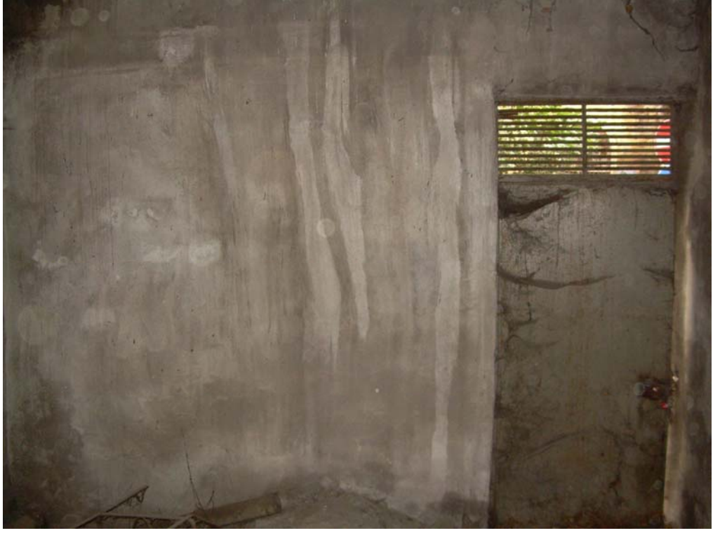
Foto 67 24 No'lu parsel iç mekan
