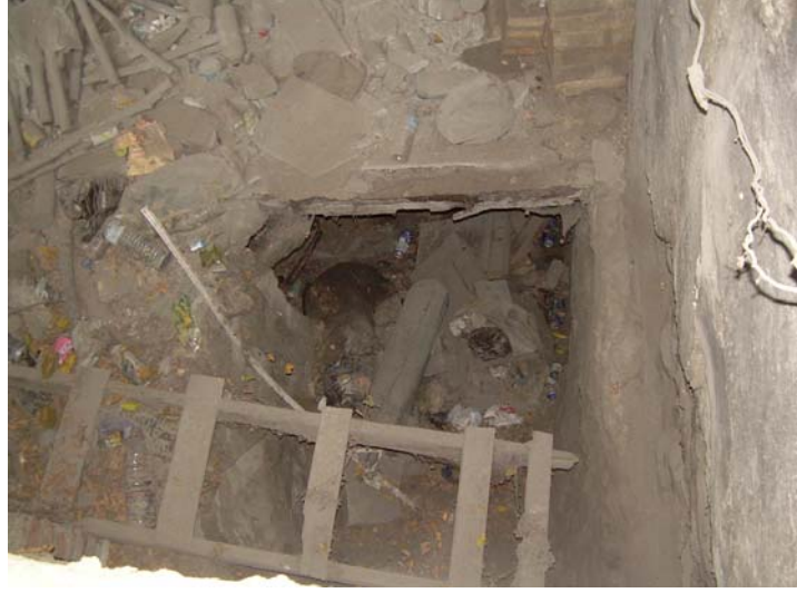
Foto 78 27 No'lu parsel iç mekan
