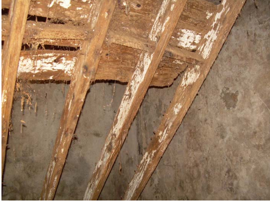
Foto 51 21 No'lu parsel iç görünüş
