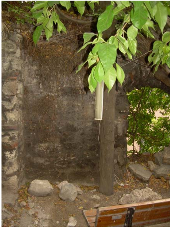
Foto 64 23 No'lu parsel üst kot
