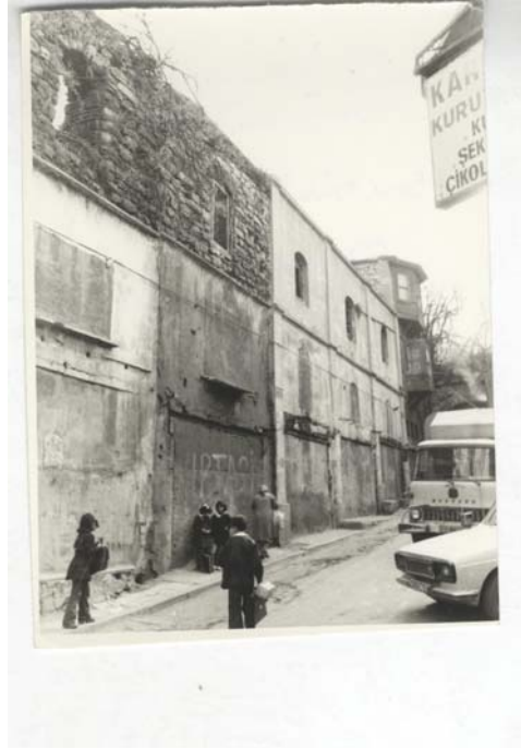
Foto 9 1970'li yıllara ait cephe fotoğrafı
