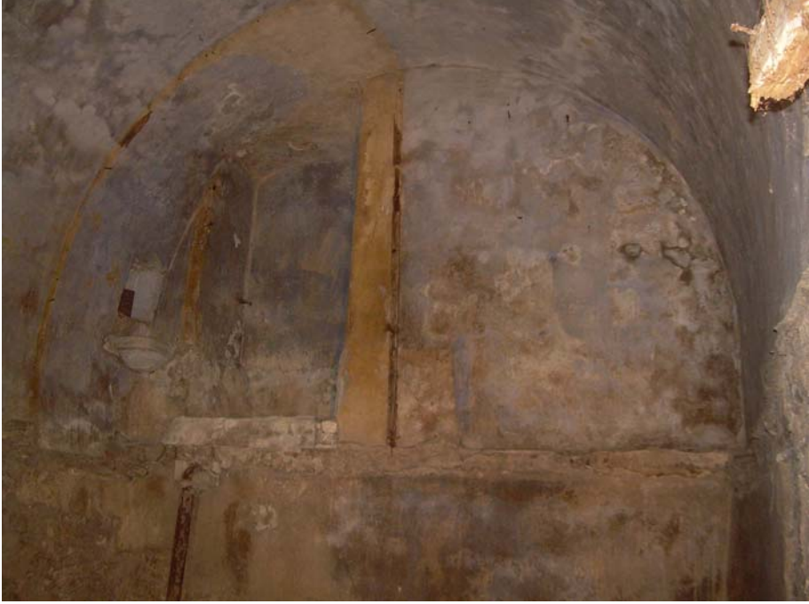
Foto 56 22 No'lu parsel iç görünüş
