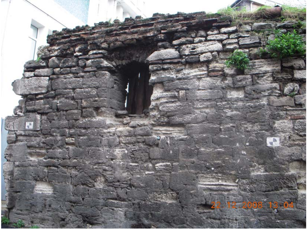
Foto 82 1 parsel cephesinde kirpi saçak hizasında su yolu künkler
