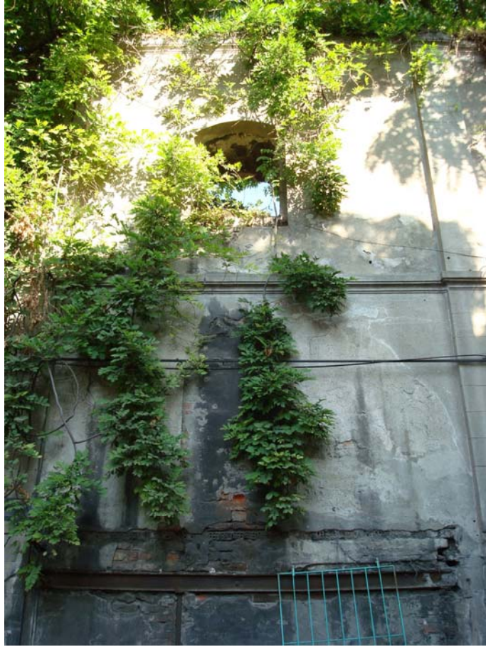
Foto 52. 21 No'lu parsel cephe fotoğrafı
