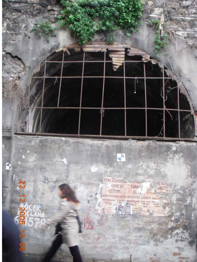
Foto 93 Süleymaniye Caddesi 27 parsel cephesi
