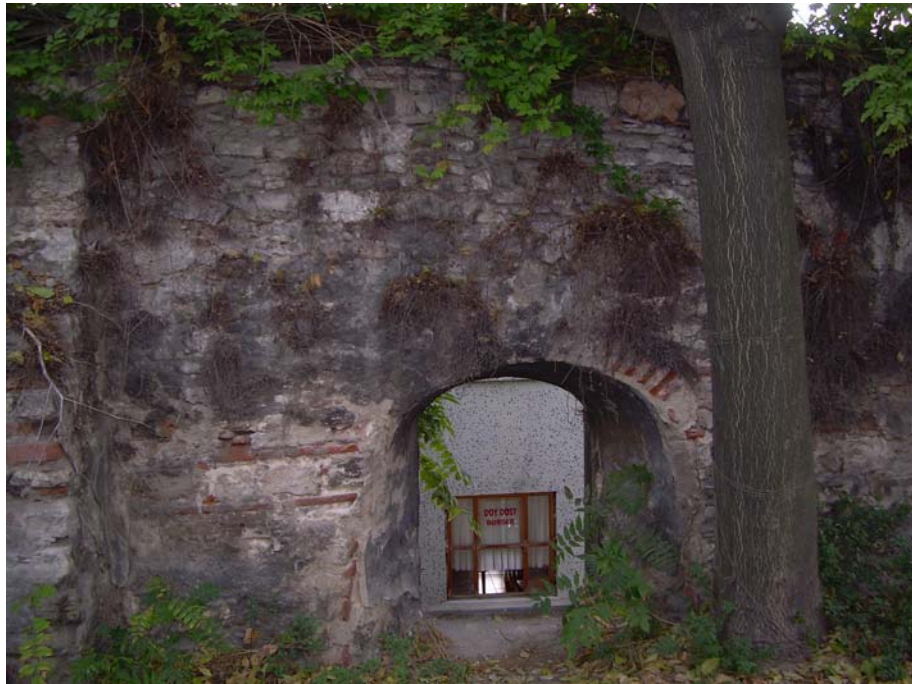
Foto 50 20 No'lu parsel üst kot
