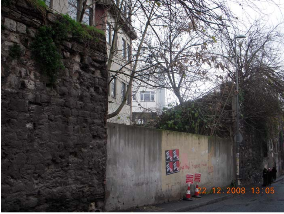
Foto 90 Süleymaniye Caddesi 6 parsel cephesi
