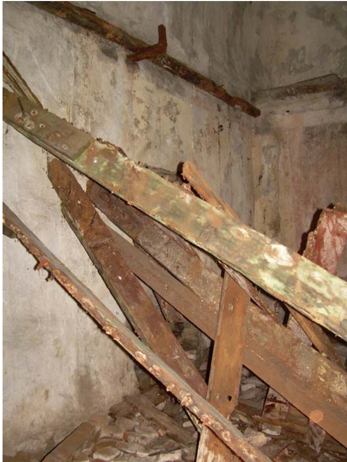
Foto 48 20 No'lu parsel iç görünüş
