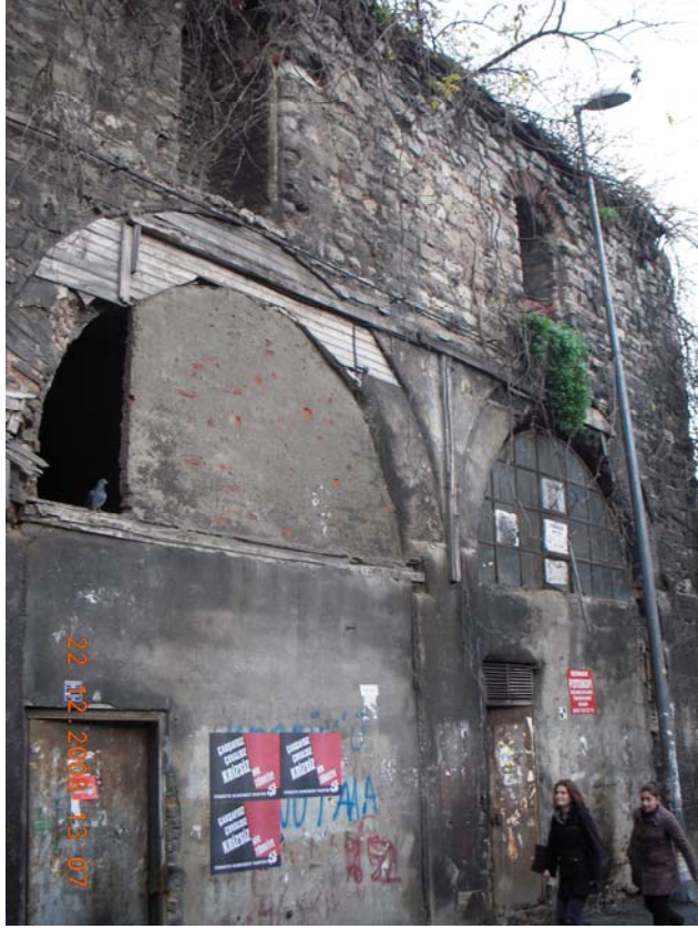
Foto 96 Süleymaniye Caddesi 24-25 parsel cephesi
