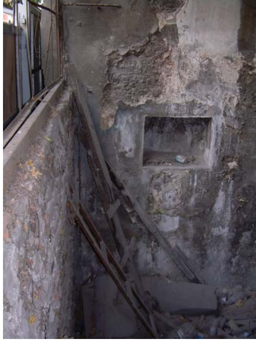
Foto 76 27 No'lu parsel iç mekan
