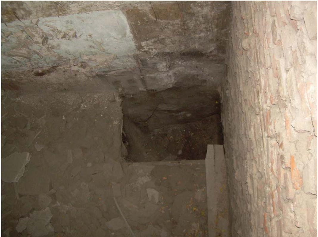
Foto 75 26 No'lu parsel iç mekan
