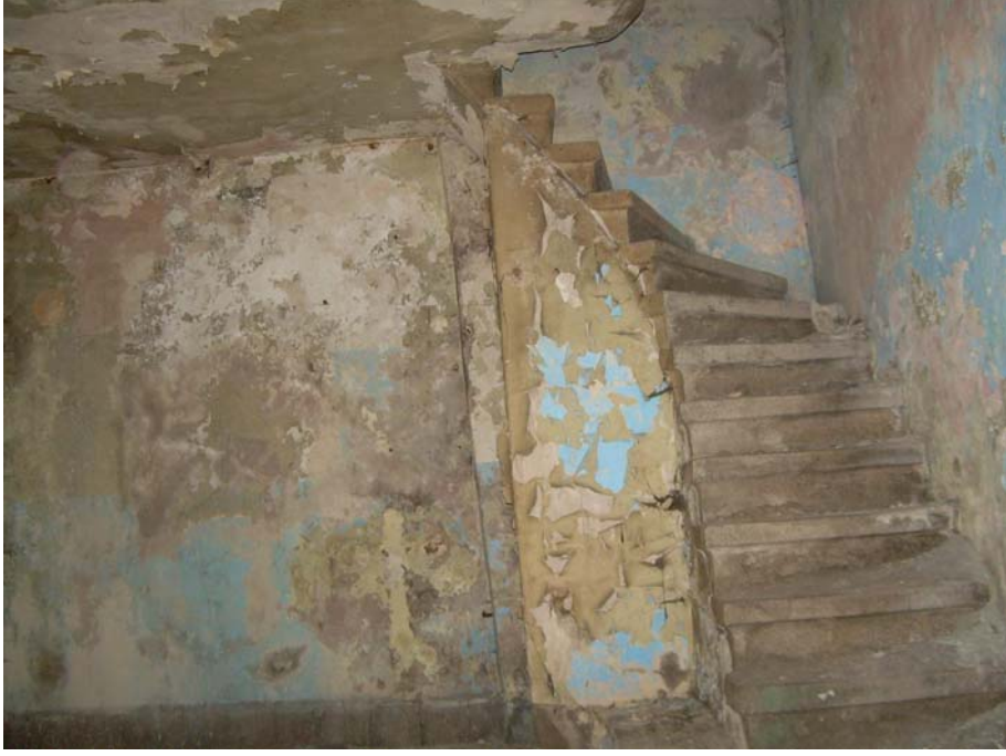
Foto 61 23 No'lu parsel merdiven
