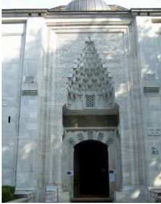
Şekil 13 Bursa Yeşil Cami Cümle Kapısı
