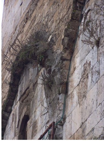
Şekil 76 Giriş Cephesi'ndeki mevcut kemer taşları
