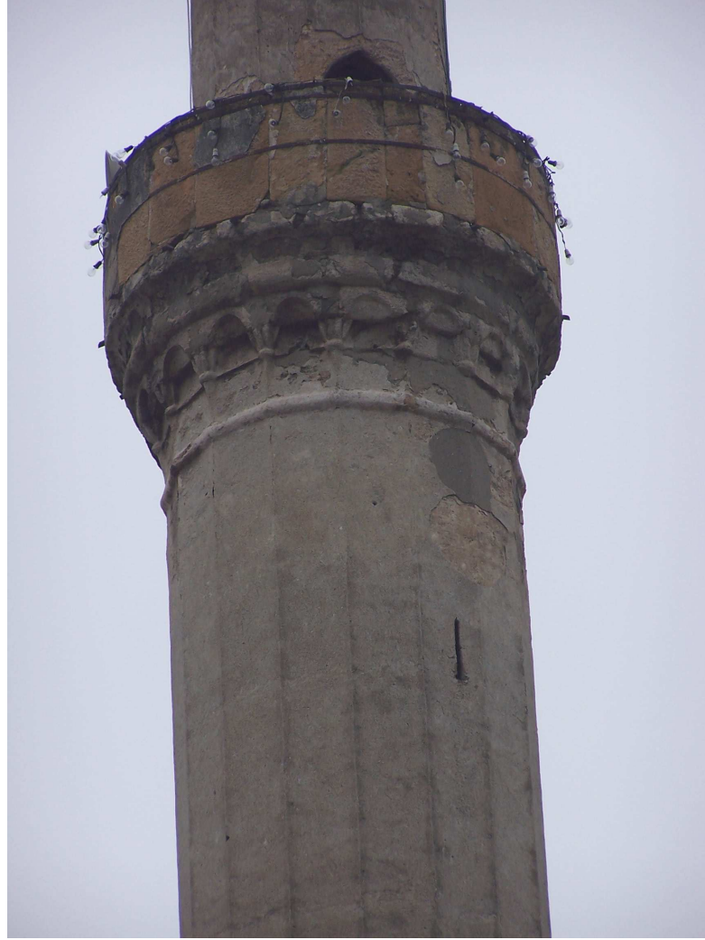
Şekil 47 Sinan Paşa Cami Minare Şerefesi
