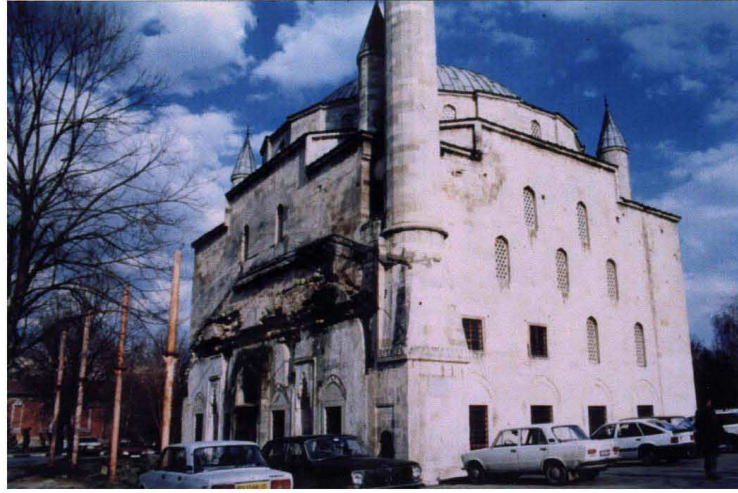
Şekil 64 Razgrad İbrahim Paşa Camisi genel görünüşü
