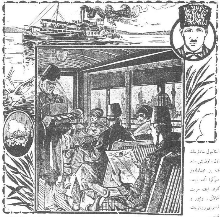
Şekil 4.2. Toplu taşıma araçlarında “harem-selamlık” bölümlenmesine dayanan mekan ayrışması ortadan kalkmıştır. (Belge, 1983)
