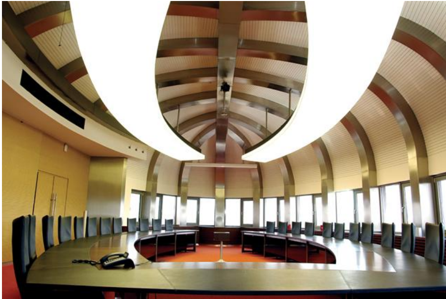
Şekil 1.30. Mekânda Akustik Sağlama Amaçlı Yapılan Tepe Yüzeyi 53
