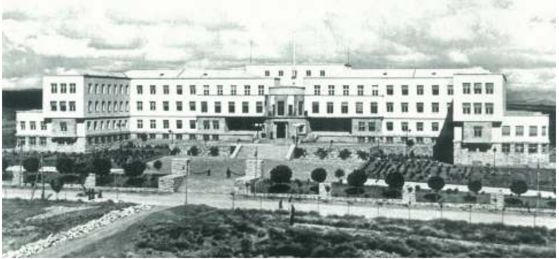
Şekil 5.9. Genel Kurmay Binası. Fotoğrafın tarihi 1935 civarı (Nicolai, 1998)
