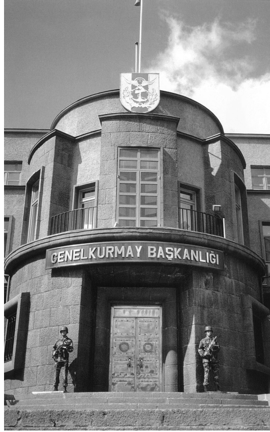
Şekil 5. 10. Genel Kurmay Binası'nın anıtsal girişi. (Nicolai, 1998)
