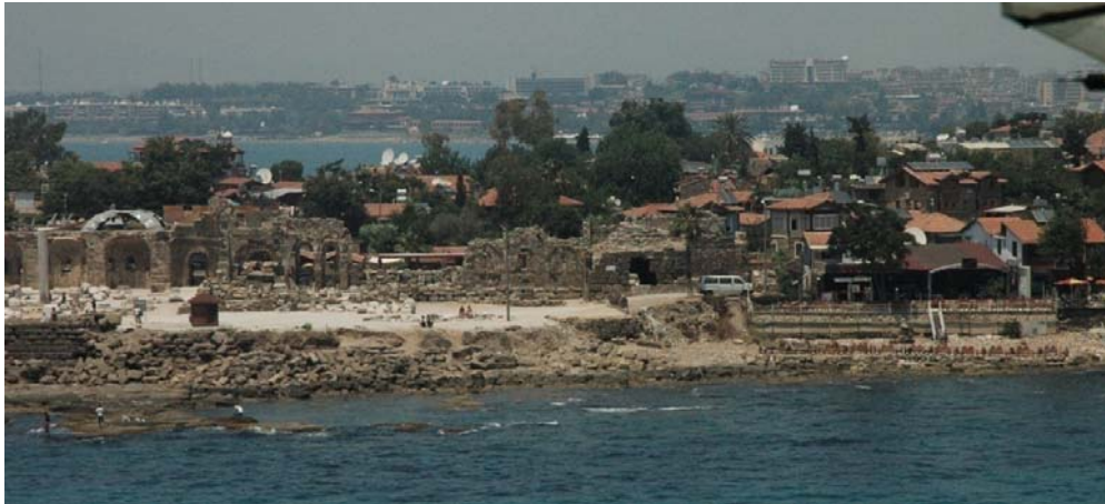
Resim 2.8. Side Antik kent, Güney Yarım Ada Deniz Surları, Side Belediyesi 2006
