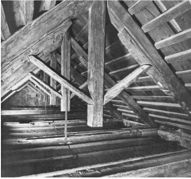
Resim 4.109. Sinai, Katherina Manastırı, Çatı Konstrüksiyonu, Mango 1995, 21.
