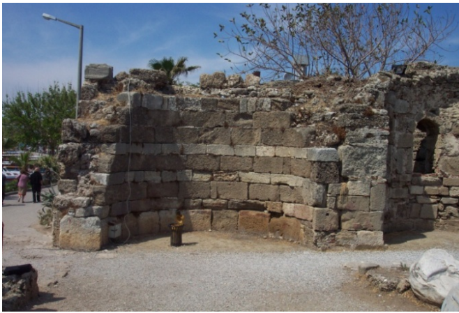
Resim 4.38. Büyük B., Güney Duvar, Kaderli 2006
