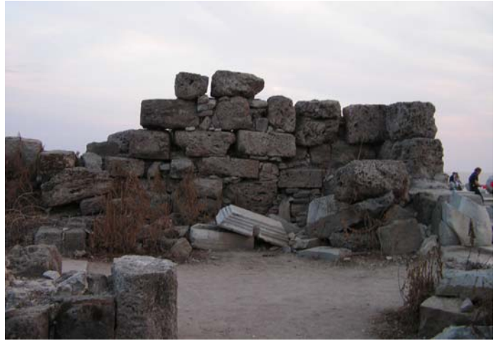
Resim 6.58. B. Bazilika Narteks, Güney Duvar, Kaderli 2005
