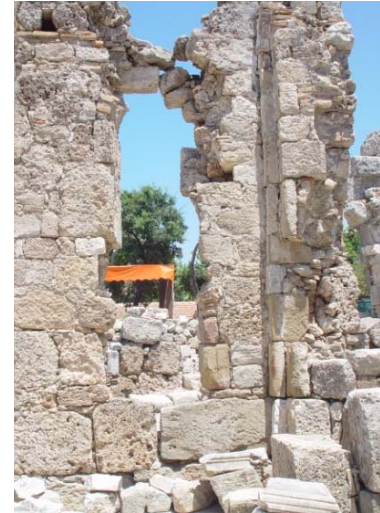
Resim 4.56. Küçük B., Kuzey Duvar İç, Kaderli 2006
