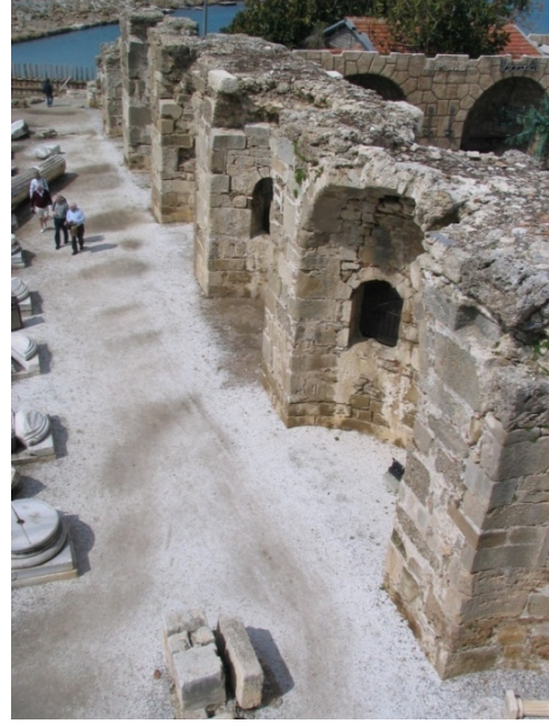
Resim 4.37. Büyük B., Güney Duvar, Kaderli 2006
