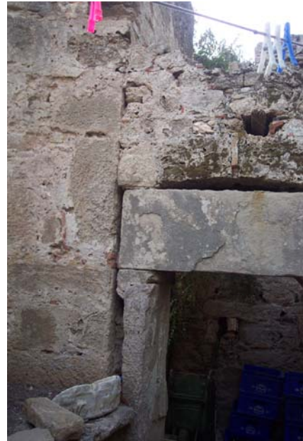
Resim 6.38. Kuzey Atrium Yan Kuzey Mekanlar, Kaderli 2006
