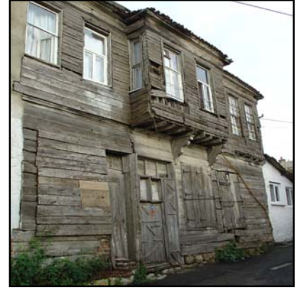
Şekil 3.20: Ahşap kaplama ile yer seviyesi arasındaki boşluk
