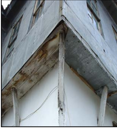
Şekil 3.23: Geleneksel Kıyıköy evlerindeki (Örnek Ev 11) iki yönlü çıkma
