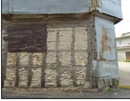
Şekil 3.3: Geleneksel Kıyıköy evlerinde sokl üzerine oturan taş duvar 1
