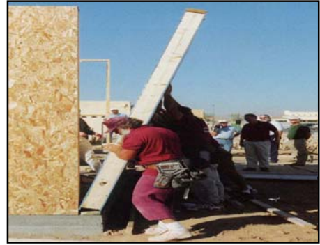
Şekil 4.4: Panel duvarların kaldırılmasında insan gücü kullanımı (Morley, 2000)
