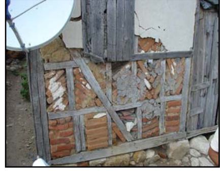
Şekil 3.4: Geleneksel Kıyıköy evlerinde sokl üzerine oturan taş duvar 2
