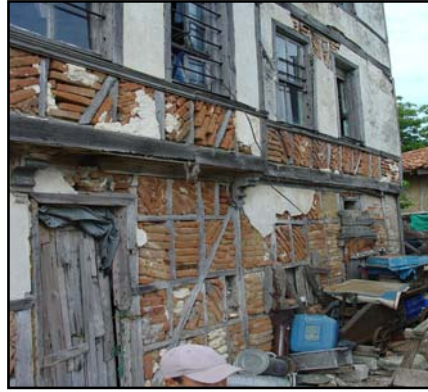
Şekil 3.1: Tuğla dolgulu geleneksel Kıyıköy evi
