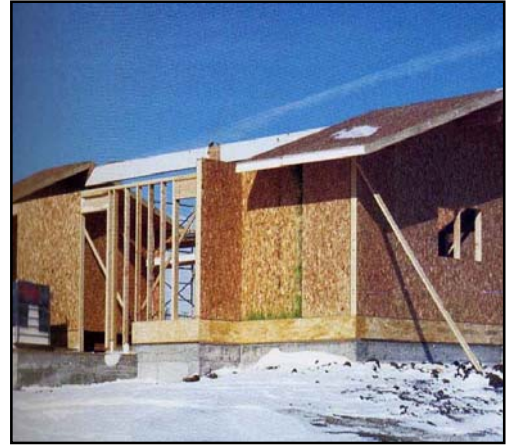
Şekil 4.2: İzole edilmiş strüktürel panel sistem (Morley, 2000)
