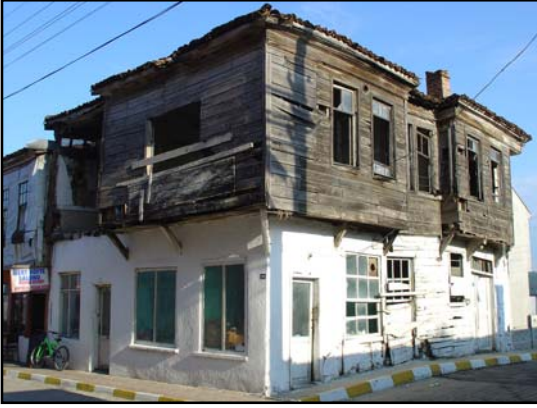
Şekil 3.19: Geleneksel Kıyıköy evlerinde kullanılan ahşap kaplama
