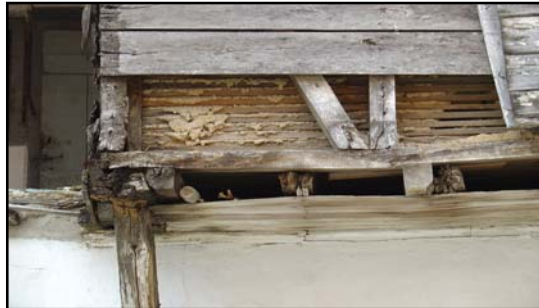
Şekil 3.7: Geleneksel Kıyıköy evi çıkma konstrüksiyon detayı
