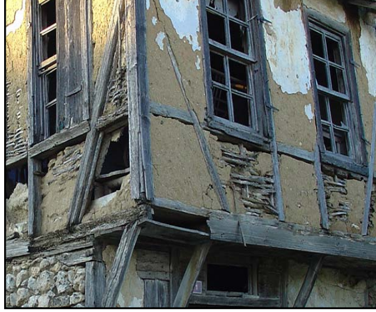
Şekil 3.18: Tek tabanlı ahşap karkas sistem ile inşa edilmiş bir Kıyıköy evi
