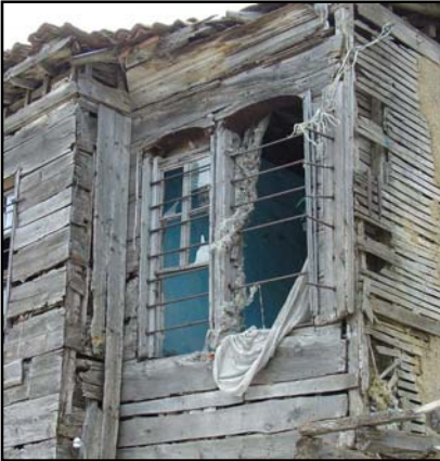
Şekil 3.16: Çitallerin kullanıldığı duvar konstrüksiyonu (Kıyıköy)
