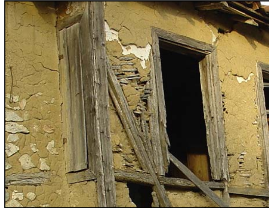
Şekil 3.17: İnce ağaç dallarının kullanıldığı duvar konstrüksiyonu (Kıyıköy)
