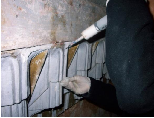
Resim 4.251. İnce çatlaklara enjeksiyon
