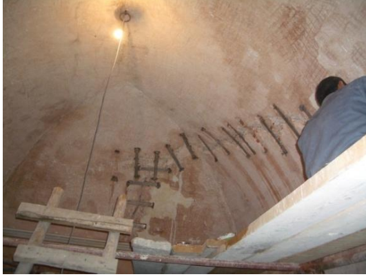
Resim 4.184. M11 mahalinde tonozda dikiş atılması
