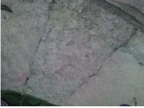
Resim 4.75. Kavlanma görülen taş yüzey
