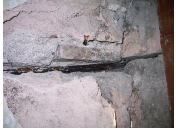
Resim 4.54. Pencere kenarlarındaki metal elemanlar
