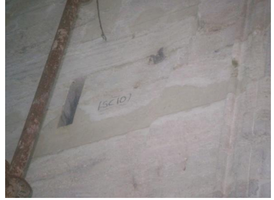
Resim 4.236. Kaidede plastik onarım
