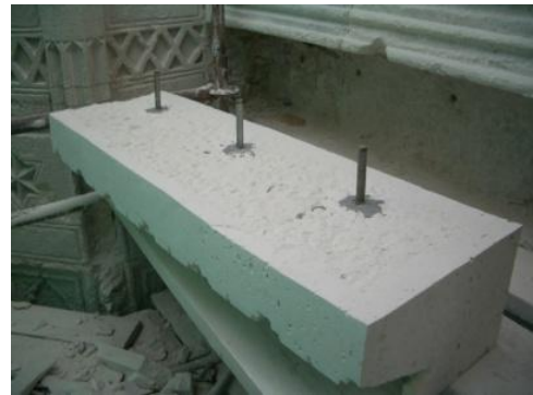
Resim 3.2. Metal zıvanalar
