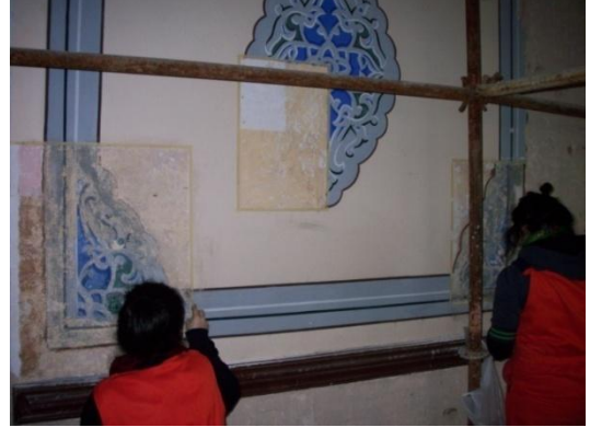
Resim 4.199. Kalem işi yüzeylerde mekanik raspa
