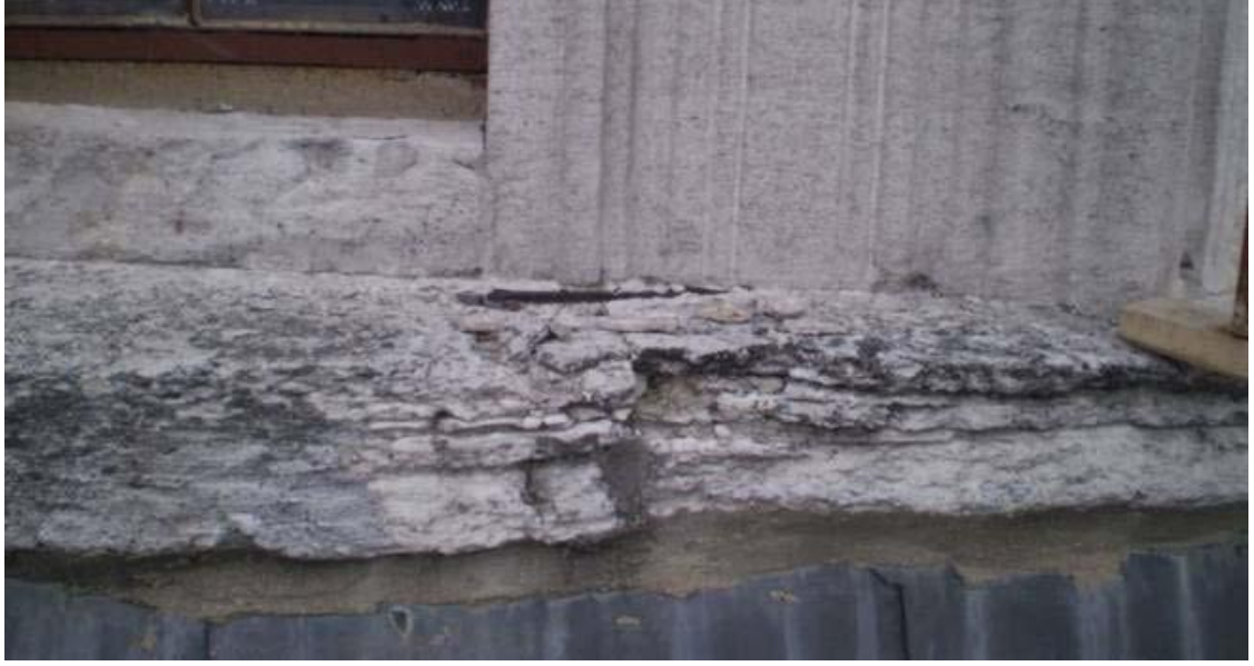
Resim 4.82. Yapraklanma görülen taş yüzey
