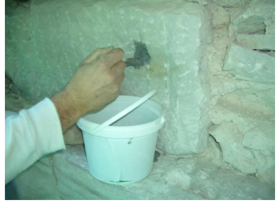
Resim 4.222. Bileşenin ankrj deliklerine doldurulması
