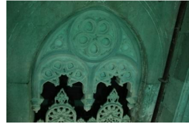
Resim 4.205. AB 57 ile kimyasal temizlik sonrası mermer yüzey
