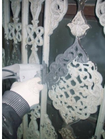
Resim 4.196. Kumlama yapılırken
