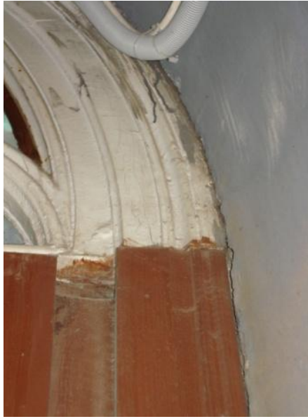
Resim 4.114-115. Kalitesiz malzeme kullanımı ve yetersiz işçilik
