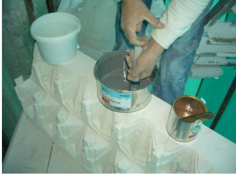
Resim 4.217. Araldite Anchorbond T karışımının hazırlanması
