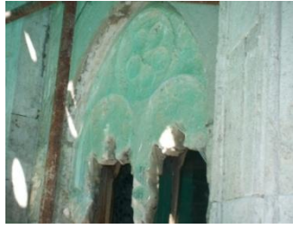
Resim 4.204. AB 57 ile kimyasal temizlik sırasında
