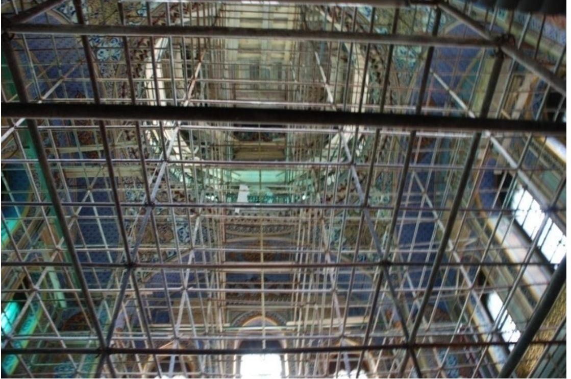
Resim 4.35. Camiye kurulan iç iskele
