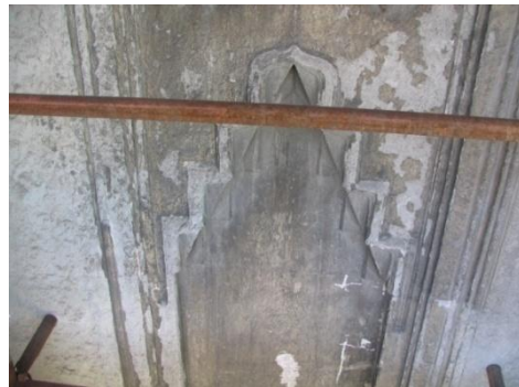
Resim 4.194. Taş yüzeylerde görülen badana katmanı
