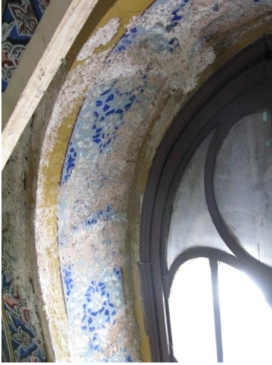
Resim 4.174. Rutubetlenmeden kaynaklanan tozuma
