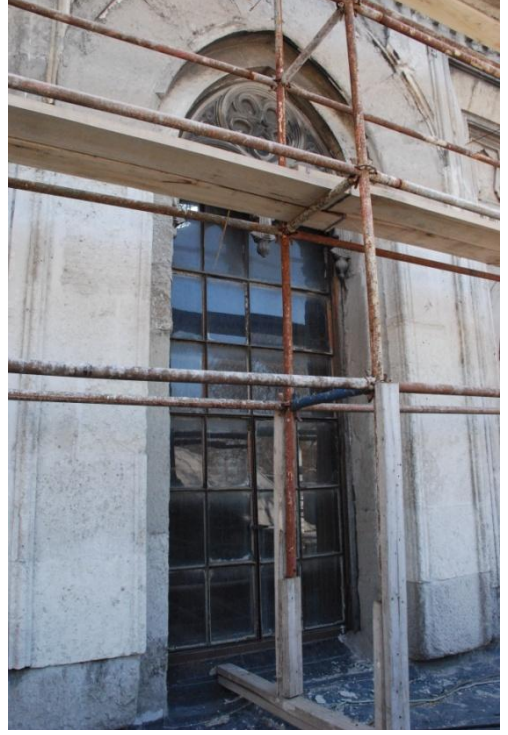
Resim 4.103. İkinci kattaki demir doğramalı pencere
