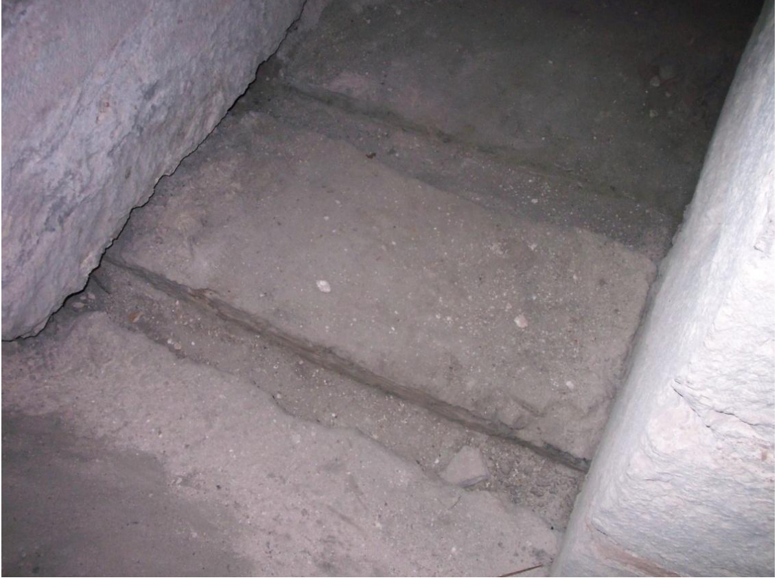
Resim 4.133. Bodrum kat B09 mahalinde bulunan ahşap hatıl yerleri
