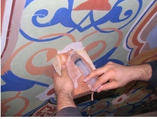
Resim 4.246. Çelik çubuk yerlerinin temizlenmesi
