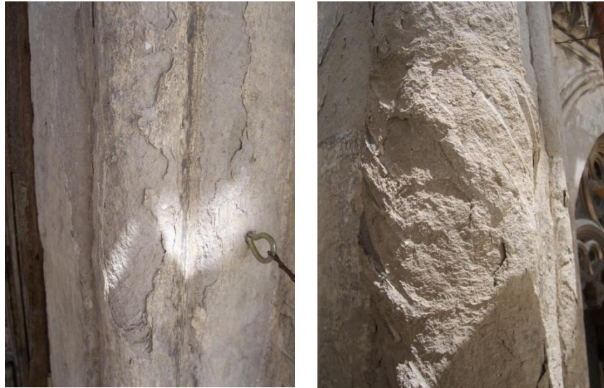
Resim 4.239-240. Sağlamlaştırma uygulaması yapılması gereken yüzey
