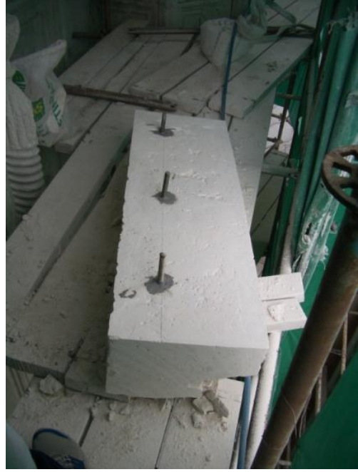
Resim 4.220. Ankraj çubuklarının yerine yerleştirilmesi
