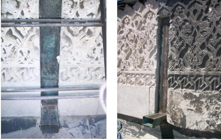
Resim 4.96-97. Alınlıklardaki bakır yağmur iniş borusu
