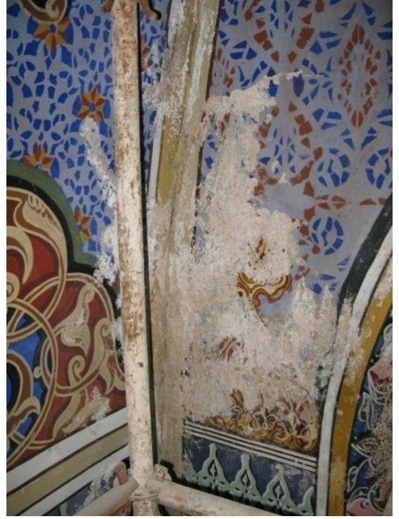
Resim 4.175. Rutubetlenmeden kaynaklanan tozuma
