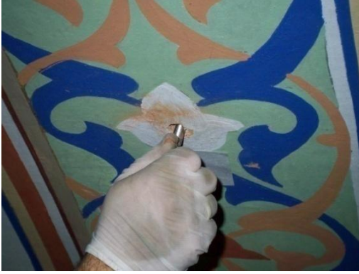
Resim 4.246. Çelik çubuk yerlerinin temizlenmesi
