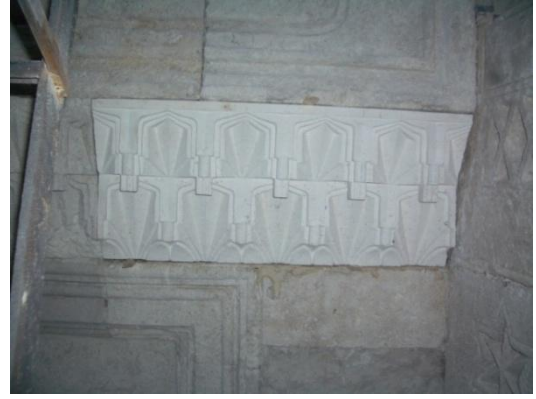
Resim 4.228. Taş değiştirme yapılan yüzey
