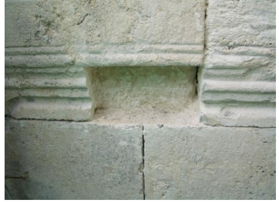
Resim 4.213. Çürütme yapılmış yüzey
