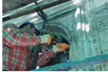
Resim 4.187. Çimento sökümü
