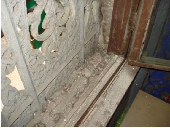
Resim 4.121. Harim kısmındaki özgün pencerenin kasasında çürüme
