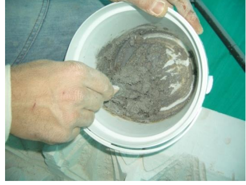
Resim 4.218. Araldite Anchorbond T karışımının hazırlanması
