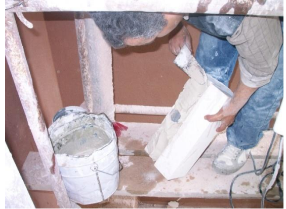
Resim 4.224. Harç malzemesi ile sıvama yapılması
