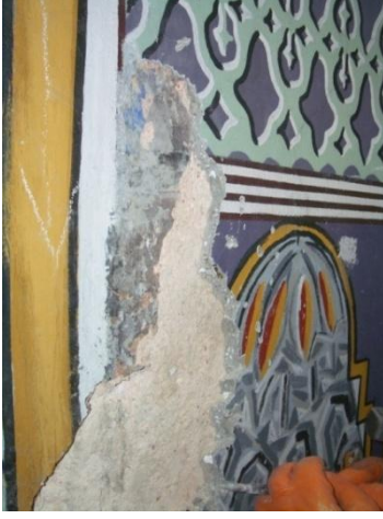
Resim 4.167. Çimento üzeri plastik boyalı yüzey
