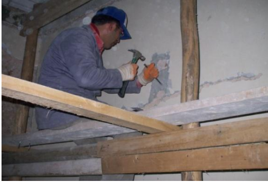
Resim 4.40. Raspa yapılması
