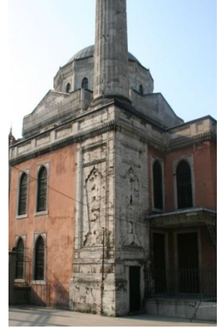
Resim 4.11. Pertevniyal Valide Sultan minare kaidesi
