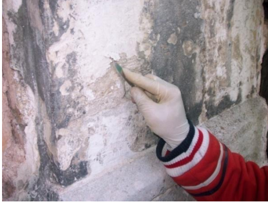
Resim 4.198. Taş yüzeylerde bistüri ile temizlik yapılması
