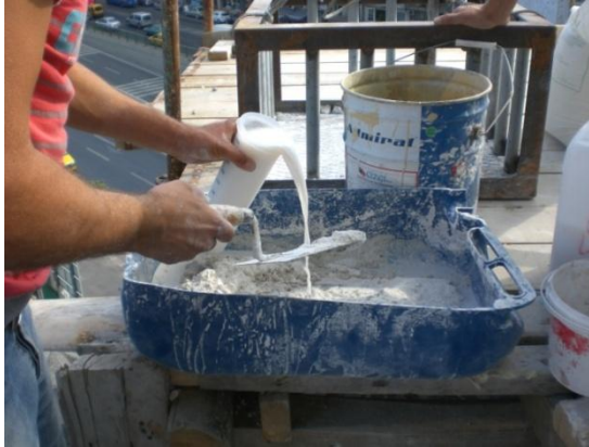
Resim 4.223. Harç malzemesinin hazırlanması
