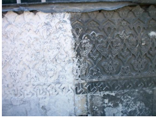
Resim 4.201. Kağıt hamuru ve amonyum bikarbonat sürülmüş taş yüzey
