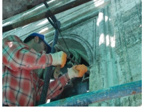
Resim 4.41. Çimento sökümü
