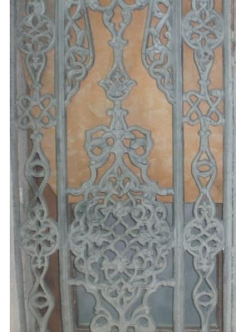
Resim 4.197. Kumlama sonrası
