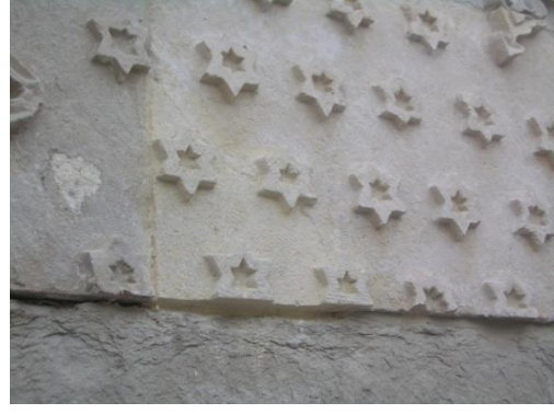
Resim 4.232. Donatılı plastik onarım sonrası
