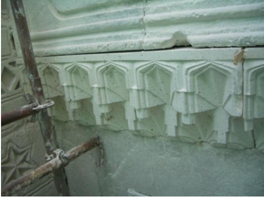
Resim 4.227. Taş değiştirme yapılan yüzey
