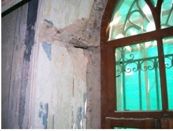
Resim.4.53. Pencere kenarlarındaki metal elemanlar
