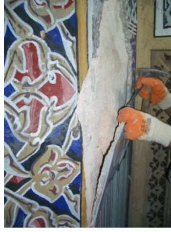
Resim 4.168. Çimento üzeri plastik boyalı yüzey
