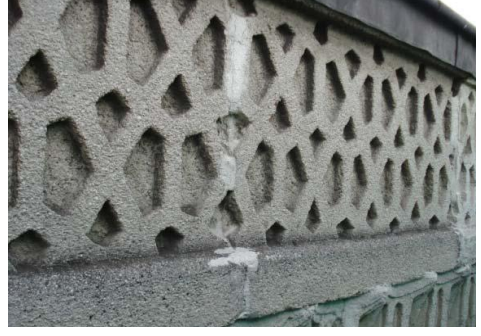
Resim 4.86. Portland çimentolu döküm eleman
