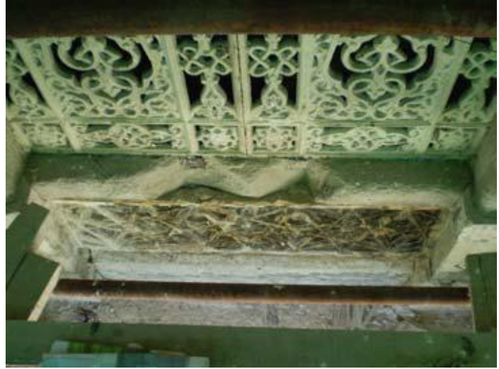
Resim 4.78. Parça kopması görülen taş yüzey
