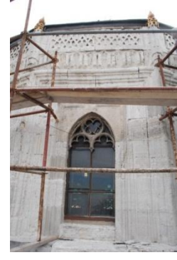
Resim 4.191. Ön yıkama sonrası taş yüzeyler
