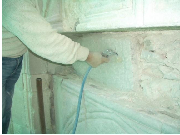
Resim 4.214. Ankraj deliklerinin basınçlı hava ile temizlenmesi
