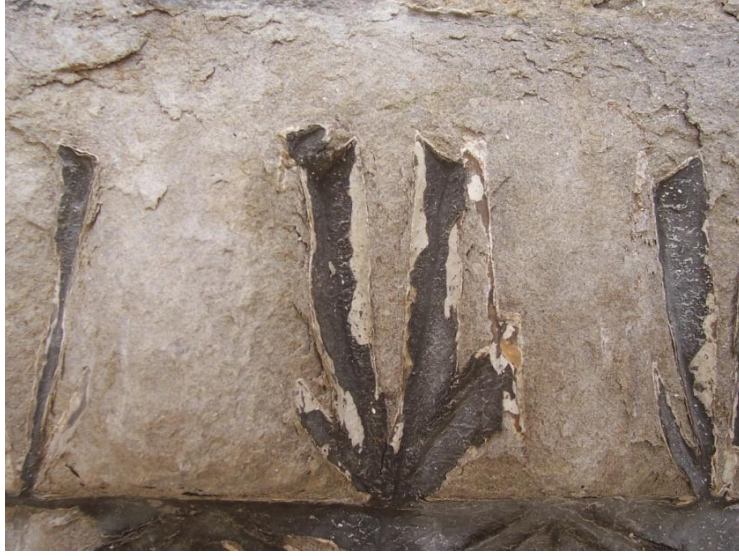
Resim 4.241. Sağlamaştırma uygulaması yapılması gereken yüzey
