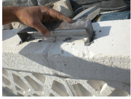
Resim 4.226. Kenetlerin yerleştirilmesi
