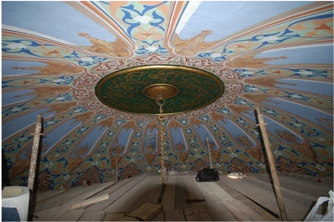
Resim 4.150. Kubbe i yzeyindeki plastik boya
