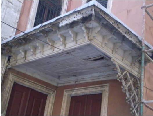
Resim 4.124. Sol ahşap saçak mevcut durum
