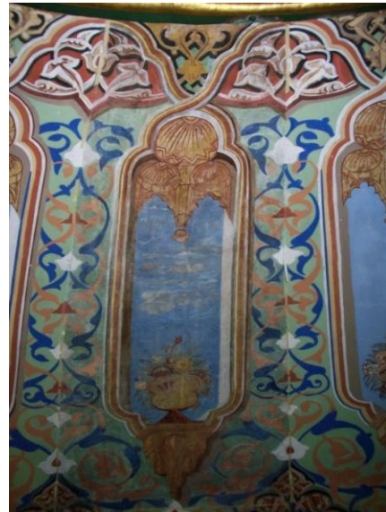
Resim 4.153. Raspa sonrası özgün kalem işi
