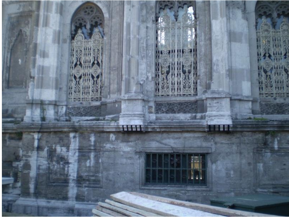
Resim 4.106. Zemin kat harim kısmındaki dökme demir şebekeler
