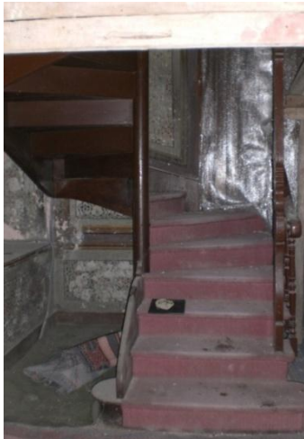
Resim 4.131. Z02 mahalindeki ahşap merdiven
