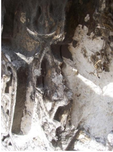
Resim 4.77. Parça kopması görülen taş yüzey
