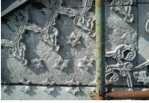
Resim 4.85. Taş yüzeylerde görülen çimento şerbeti
