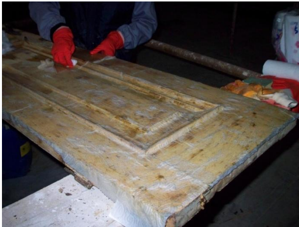
Resim 4.206-207. Ahşap elemanlarda temizlik yapılması
