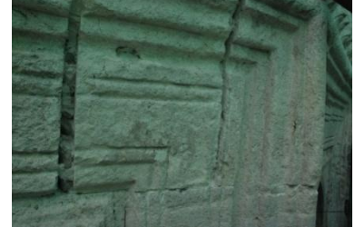
Resim 4.188. Çimento sökümü sonrası
