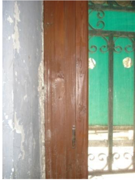
Resim 4.114-115. Kalitesiz malzeme kullanımı ve yetersiz işçilik
