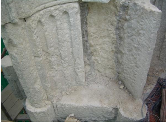
Resim 4.212. Çürütme yapılmış yüzey
