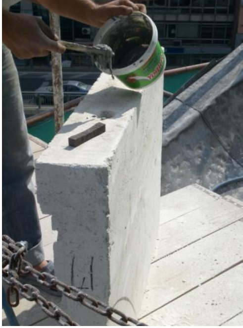
Resim 4.219. Ankraj deliklerine bileşenin doldurulması
