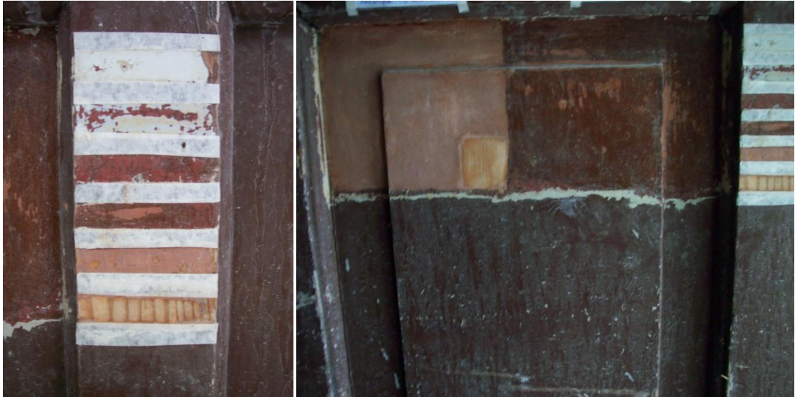
Resim 4.127-128. Ahşap elemanlarda yapılan araştırma raspaları
