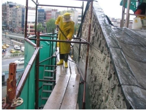
Resim 4.190. Düşük basınçlı su ile ön yıkama yapılması
