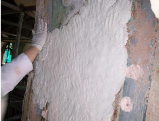
Resim 4.253. Kalem işi yüzeylerde tuz alımı
