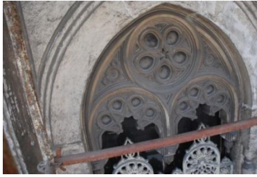
Resim 4.203. AB 57 ile kimyasal temizlik öncesi mermer yüzey
