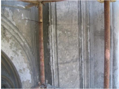
Resim 4.193. Taş yüzeylerde görülen badana katmanı
