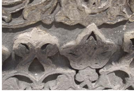
Resim 4.87. Taş yüzeylerde görülen badana katmanı
