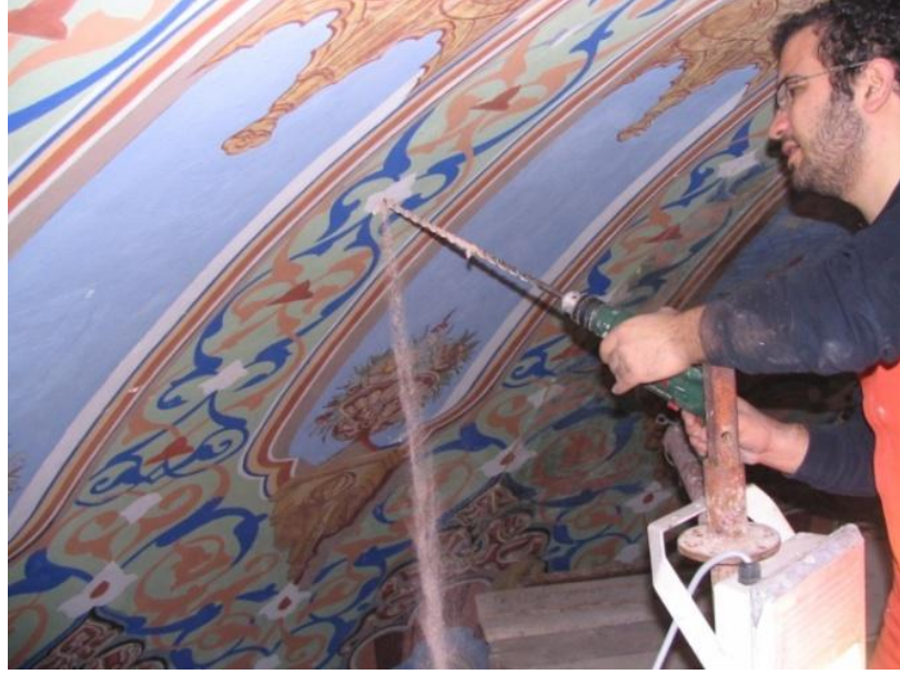
Resim 4.244. Kubbeye çelik çubuklar için boşluk açılması
