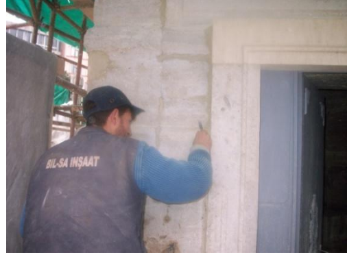
Resim 4.230. Plastik onarım yapılması
