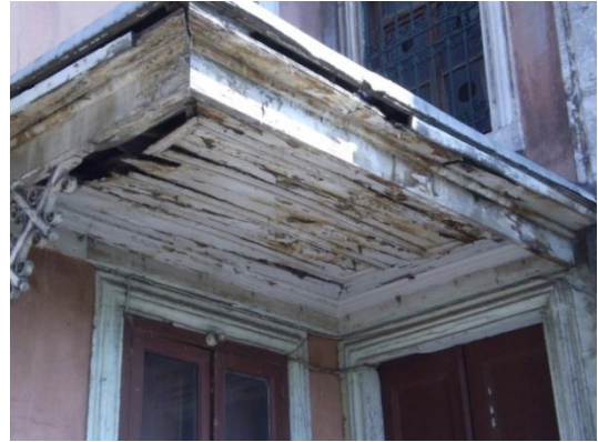
Resim 4.125. Sağ ahşap saçak mevcut durum
