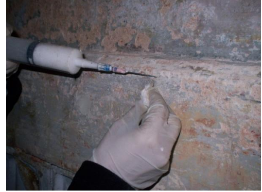
Resim 4.252. İnce çatlaklara enjeksiyon
