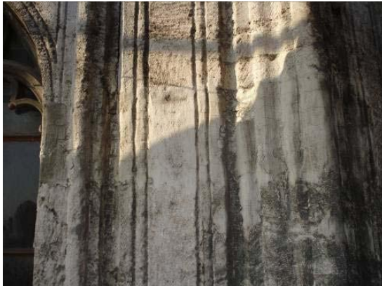
Resim 4.83. Taş yüzeylerdeki görülen beyaz çimento
