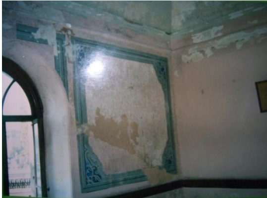
Resim 4.142 1995 onarımı öncesi M07 mahali [6]
