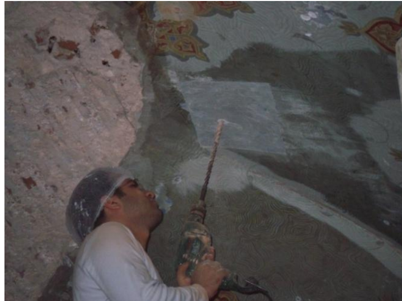
Resim 4.245. Tozonda çelik çubuklar için boşluk açılması
