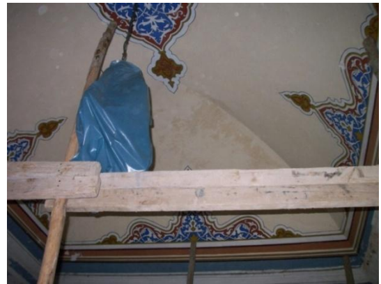
Resim 4.138. M11 mahalindeki tonozun mevcut durumu
