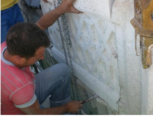
Resim 4.225. Taşların yerleştirilmesi
