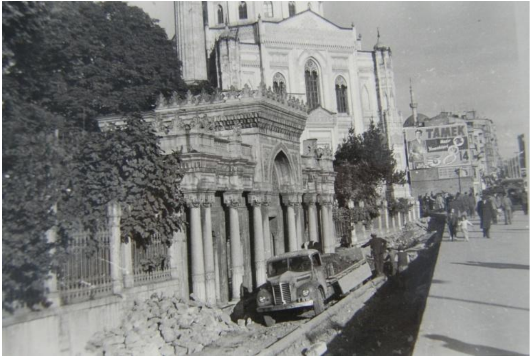
Resim 4.21. Yol çalışmalarının yapıldığı sırada cami, 1958 [6]
