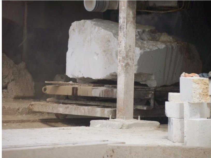
Resim 4.211. Ocakta taşların kesilmesi
