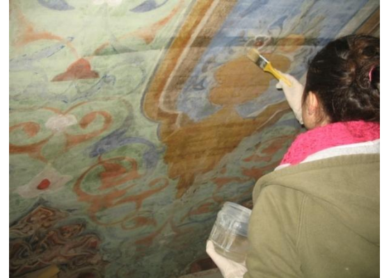
Resim 4.254. Kalem işi yüzeylere koruyucu sürülmesi
