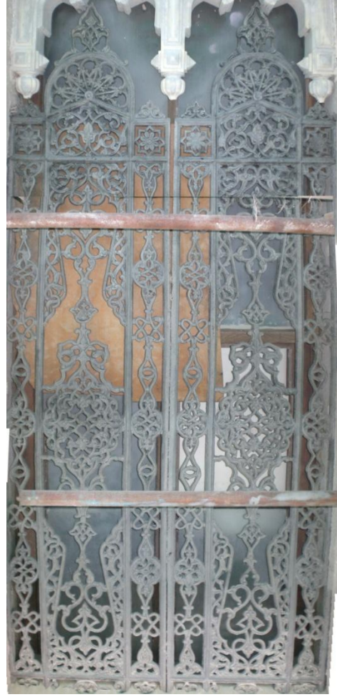
Resim 4.108. Dökme demir şebeke boya tabakası temizlendikten sonra
