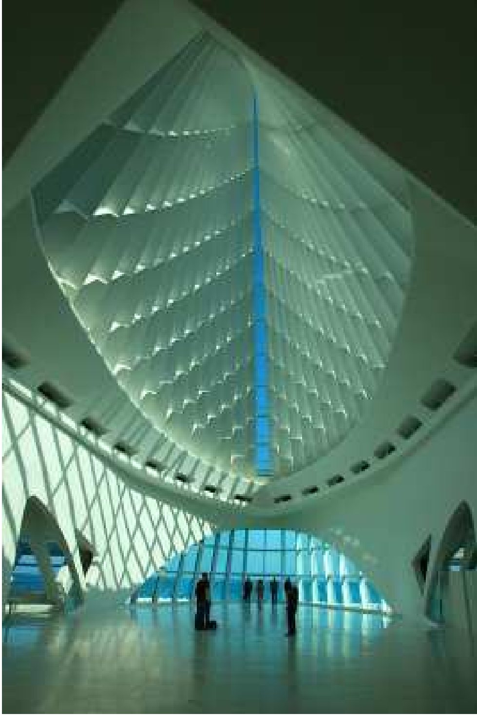
Resim 4.7. Çatıda Işık Rafı Kullanımına Örnek Müze Galerisi 56
