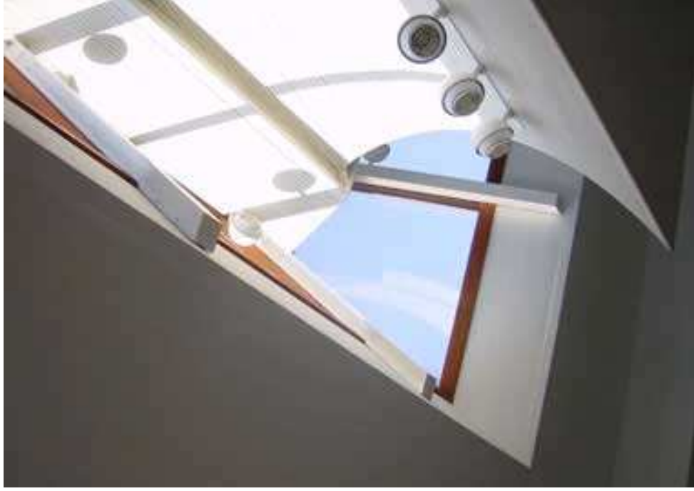
Resim 4.23. Çatı Işıklıklarında Kullanılan Kumaş Gölgeleler 82
