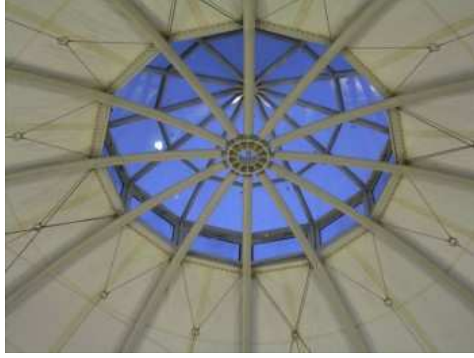
Resim 4.3. Çatı Feneri Örneği 49
