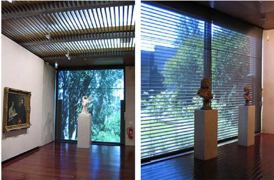
Resim 4.22. Do Chiado Müzesi (Lisbon) – Pencere ve Tavan Işıklıklarında Kullanılan Mekanik Panjur Sistemi 80
