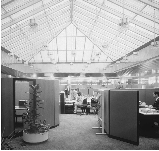
Şekil 4.10. Açısal Seçici Camların Tepe Işıklığında Kullanımı
