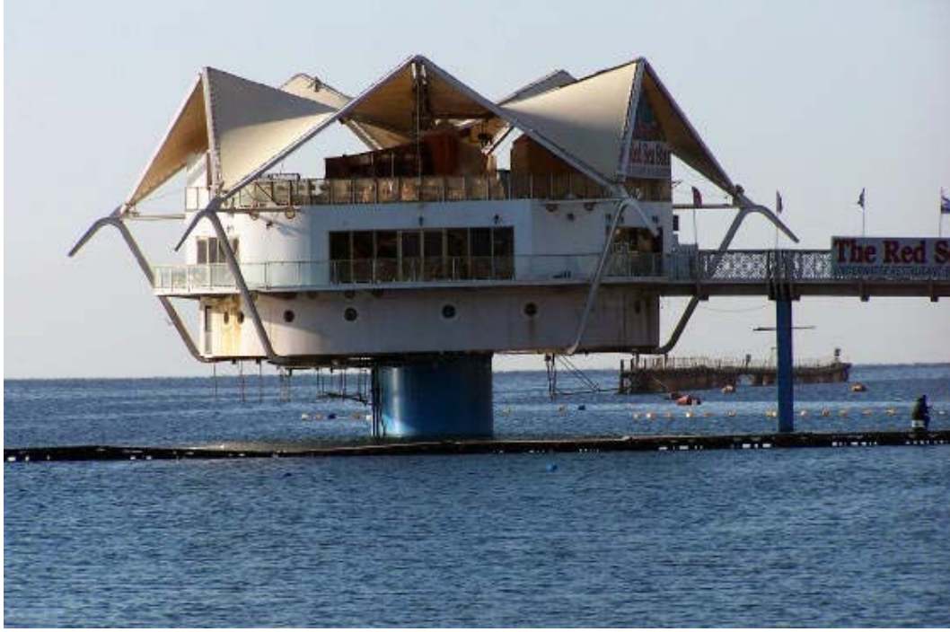
Resim 3.34. Barın giriş bölümü için oluşturulmuş olan yapı, burada bulunan asansör ile ziyaretçiler 6 metre derinlikte yer alan esas restoran ve bar bölümüne ulaşırlar.
