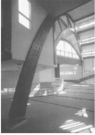
c) Kemer üzerinde aydınlatma için geliştirilen çözüm örneği (Gutdeutsch, 1996, syf.20).
