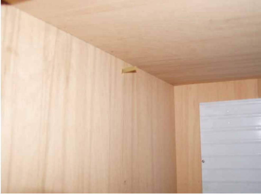
Resim 4-14-Buhar Jeneratörü Dışarıdan Takıldığı Durumlar İçin Buhar Girişi
