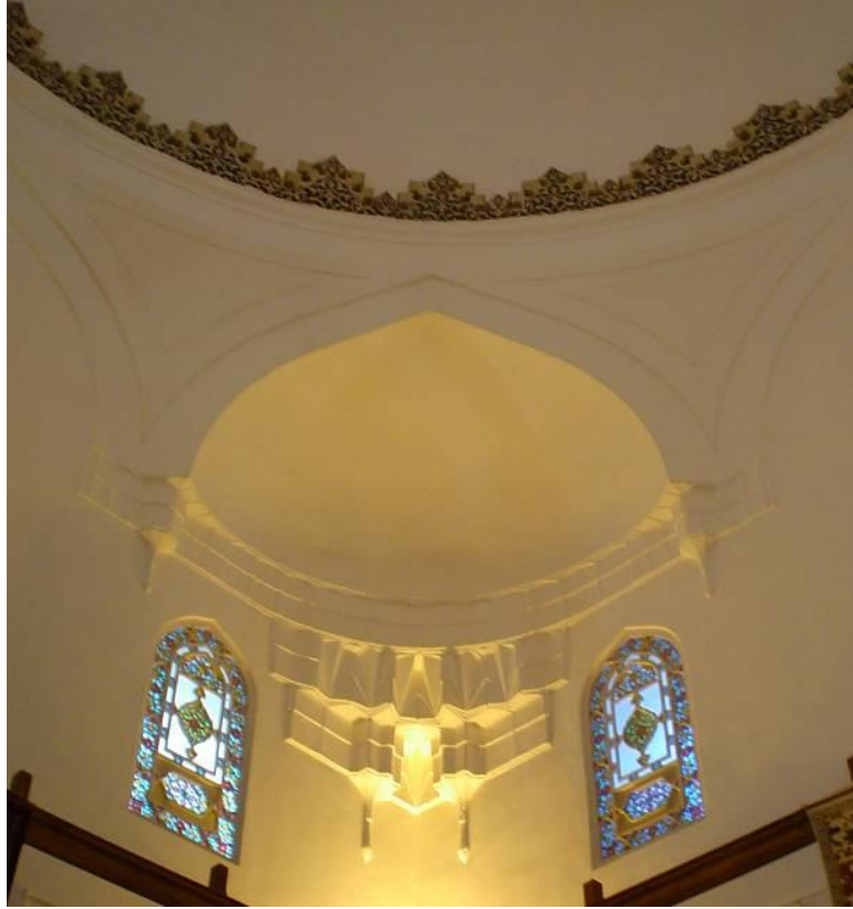
Resim 5.1.6-1- İstanbul – Ayasofya Haseki Hürrem Sultan Hamamı Camekanlık Bölümü Kornişleri (T. Cem Yaman)
