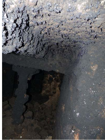
Resim 6-59- İstanbul – Çemberlitaş Hamamı Kadınlar Sıcaklığı Cehennemlik Kanalı (T. Cem Yaman)
