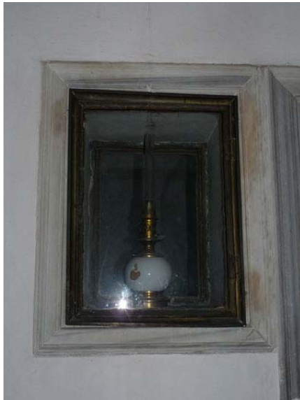
Resim 5.3.2-12- İstanbul – Dolmabahçe Sarayı Sol Taraf Kadınefendiler Hamamı Sıcaklık ile Ilıklık Ortak Duvarı İçindeki Yapay Aydınlatma Nişleri ve Kandilleri (T. Cem Yaman)
