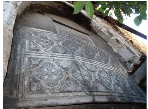
Resim 5.1.8-5- İstanbul – Çardaklı Hamamı Cümle Kapısı Kitabesi ve Altında Bulunan Süslemesi (T. Cem Yaman)
