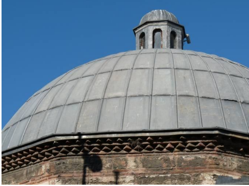
Resim 5.1.6-2- İstanbul – Süleymaniye Hamamı Tuğla Silmesi (T. Cem Yaman)
