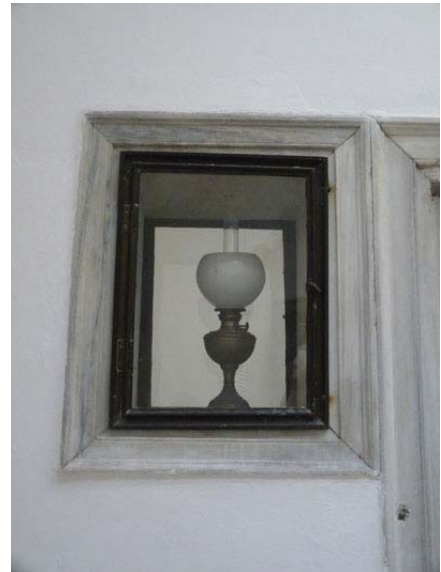
Resim 5.3.2-13- İstanbul – Dolmabahçe Sarayı Sağ Taraf Kadınefendiler Hamamı Sıcaklık ile Ilıklık Ortak Duvarı İçindeki Yapay Aydınlatma Nişleri ve Kandilleri (T. Cem Yaman)
