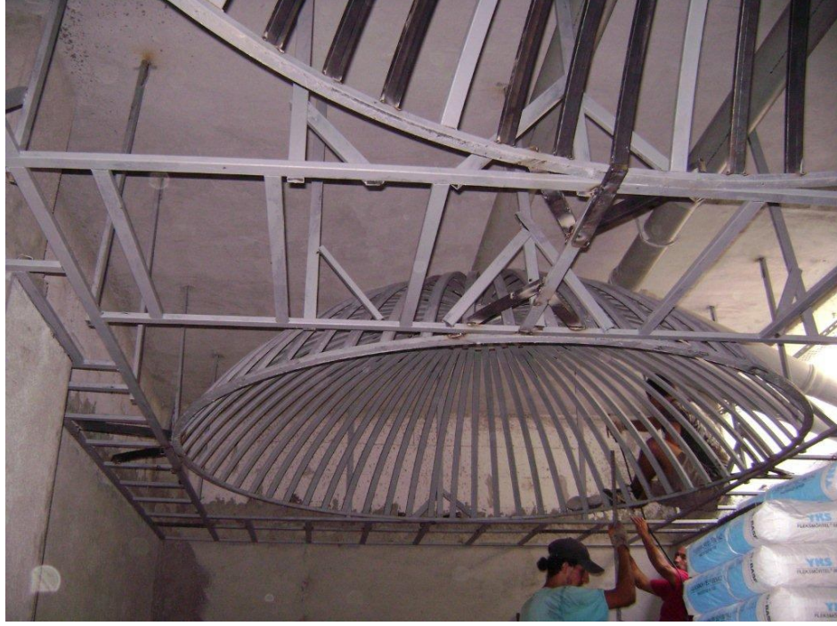
Resim 2.3.1-5- Sarıyer – Arıköy Sosyal Tesisleri Hamamı Çelik Karkas Tavan Yapımı (E.T.C. İnşaat)
