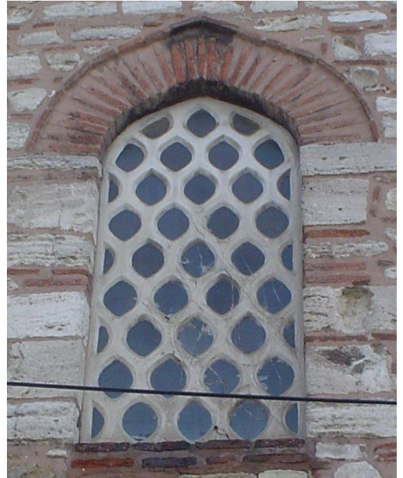
Resim 5.1.7-12- İstanbul - Ayasofya Hürrem Sultan Hamamı Filgözü Kayıtlı Dışlık Penceresi (T. Cem Yaman)
