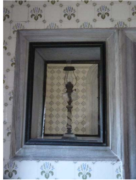
Resim 5.3.2-8- İstanbul – Dolmabahçe Sarayı Çinili Hamamı Sıcaklık ile Ilıklık Ortak Duvarı İçindeki Yapay Aydınlatma Nişi ve Şamdanı (T. Cem Yaman)
