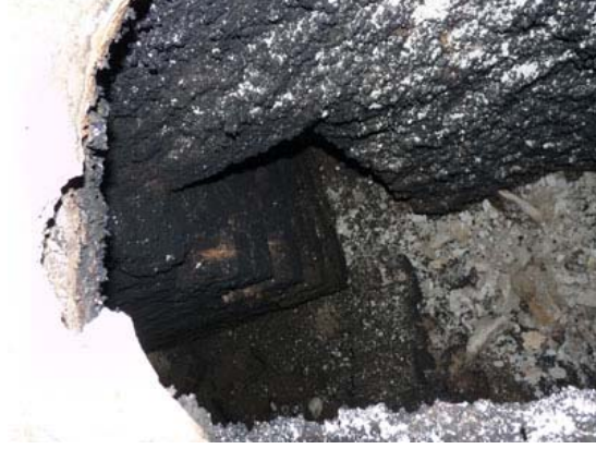
Resim 6-58- İstanbul – Çemberlitaş Hamamı Kadınlar Sıcaklığı Cehennemlik Kanalı (T. Cem Yaman)
