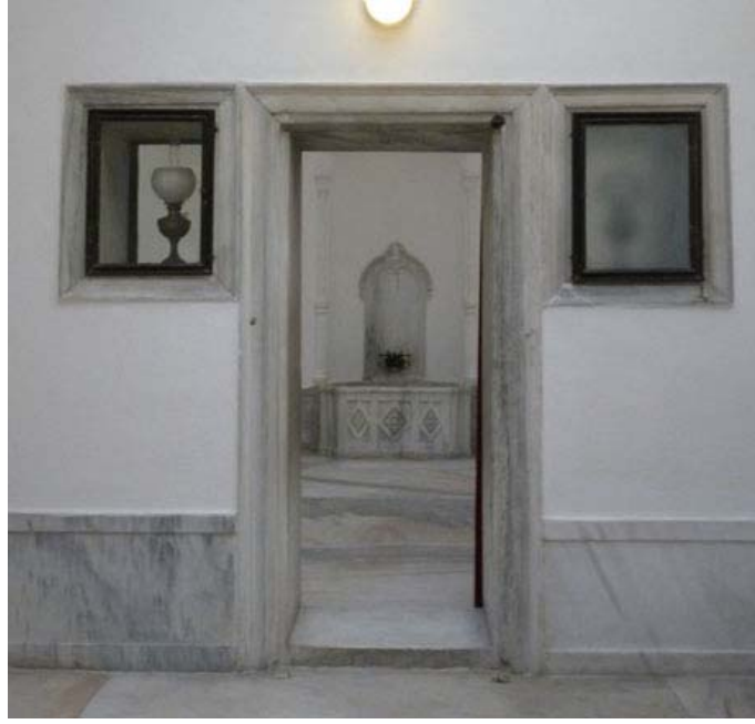
Resim 5.3.2-11- İstanbul – Dolmabahçe Sarayı Sağ Taraf Kadınefendiler Hamamı Sıcaklık ile Ilıklık Ortak Duvarı İçindeki Yapay Aydınlatma Nişleri ve Kandilleri (T. Cem Yaman)
