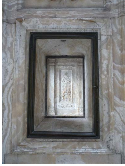
Resim 5.3.2-2- İstanbul – Dolmabahçe Sarayı Hünkar Hamamı Sıcaklık ile Ilıklık Ortak Duvarı İçindeki Yapay Aydınlatma Nişi (T. Cem Yaman)
