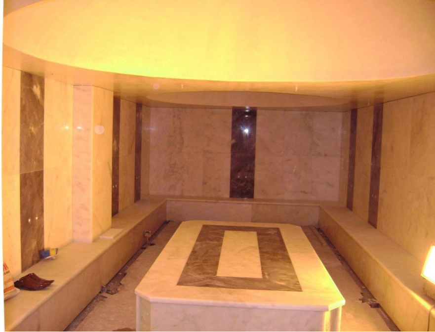
Resim 2.3.1-8- Sarıyer – Arıköy Sosyal Tesisleri Hamamı Mermer Kaplanması (E.T.C. İnşaat)
