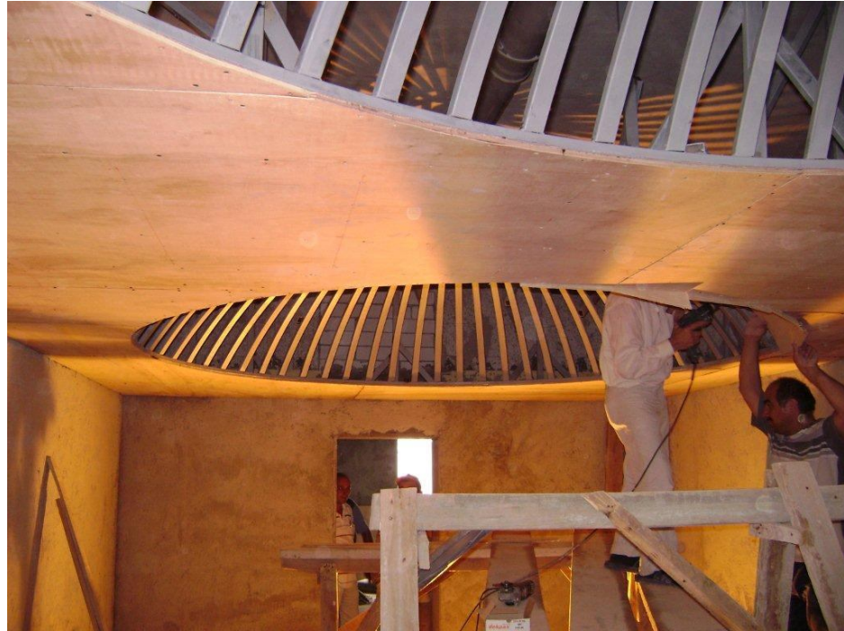
Resim 2.3.1-6- Sarıyer – Arıköy Sosyal Tesisleri Hamamı Tavanının Ceopan İle Kaplanması (E.T.C. İnşaat)
