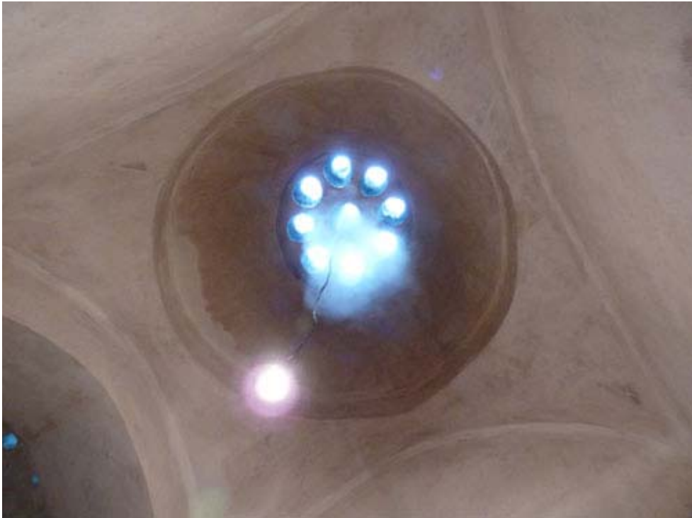
Resim 6-49- İstanbul – Çemberlitaş Hamamı Kadınlar Sıcaklığındaki Halvetin Kubbesi ve Işık Gözleri (T. Cem Yaman)
