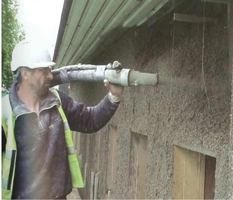
Resim 4.2. Selüloz Üfleli Yalıtım Uygulaması
