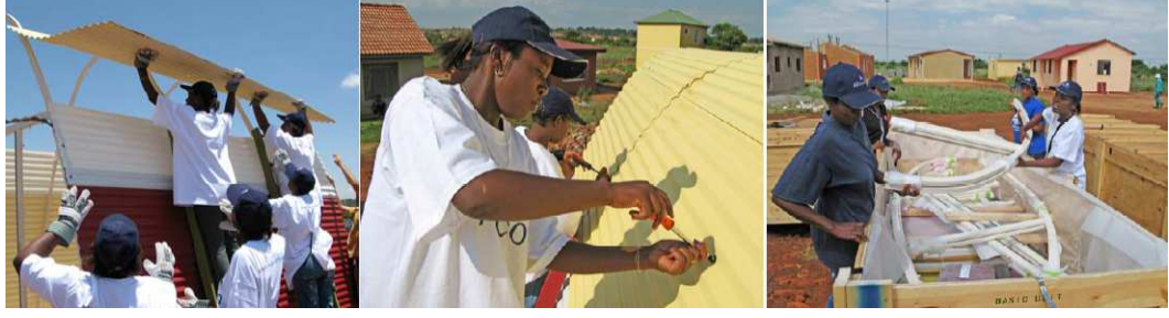
Resim 2.24. Abod House Kutu İçinde Teslim Edilir ve Basitçe Monte Edilir.
