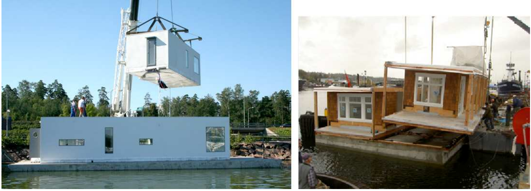
Resim 2.17. Yüzer Ev Modüllerinin Taşıyıcı Beton Duba Üzerine Yerleştirilmesi
