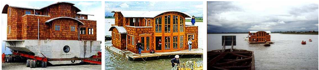
Resim 2.16. Bir Yüzer Evin Denize İndirilmesi ve Çekilerek Yerine Taşınması
