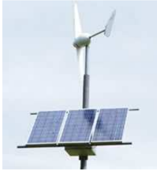
Resim 4.1. Rüzgar Türbini ve PV Panelin Bir Arada Kullanıldığı Hibrid Sistem
