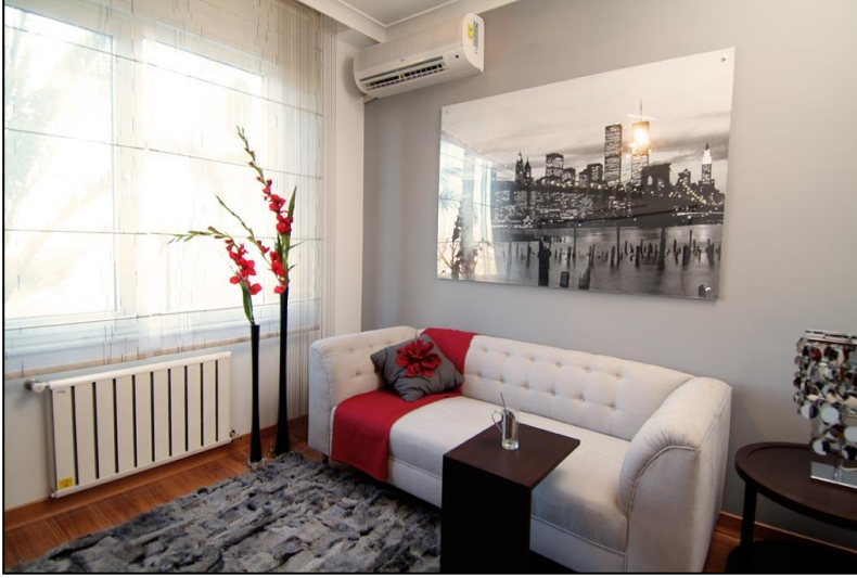
Resim 3.9 : Radyatör ve klima kullanım örneği Kaynak: http://www.uphillcourt.com
