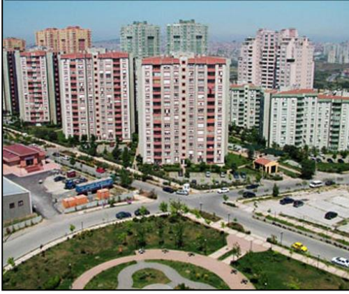
Resim 1.11: Emlak Bankası Ataşehir Konutları genel görünüm 1 Kaynak: http://www.emlakgyo.com.tr/projeler.eski.asp
