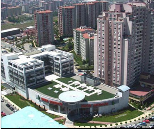
Resim 1.12: Emlak Bankası Ataşehir Konutları genel görünüm 2 Kaynak: http://www.emlakgyo.com.tr/projeler.eski.asp
