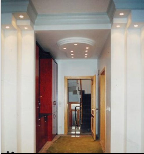
Resim 1.38: Emirgan'da bir konutun tavanında alçı asma tavan ve gömme spotlarla aydınlatma örneği Kaynak: Argun Mimarlık arşivi 1993
