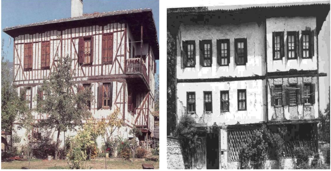
Şekil 2.6. Safranbolu’da Ahşap Konstrüksiyon İçine Kerpiç Blokların Yerleştirildiği Geleneksel Mimarimizden Örnekler.
