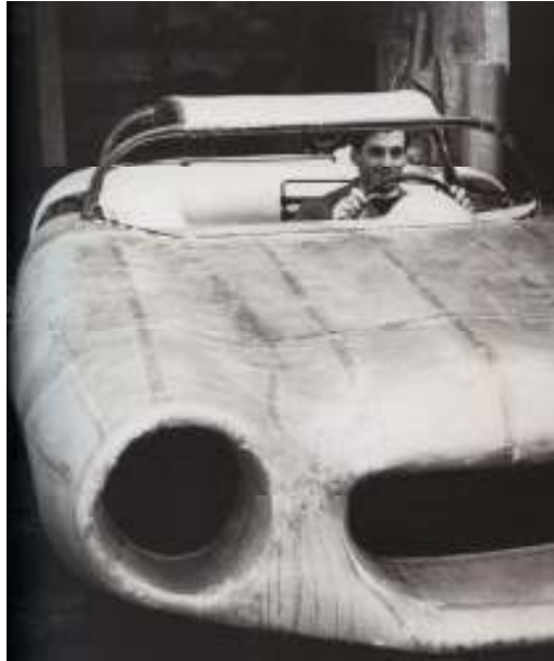
Şekil 4.48. Tamamiyle plastikten araba yapma çalışmaları 146
