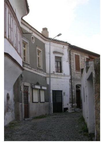
Şekil 4.127 Bölge C-2 No'lu Yapı
