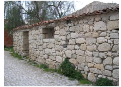
Şekil 4.134 Bölge C-3 No'lu Yapı
