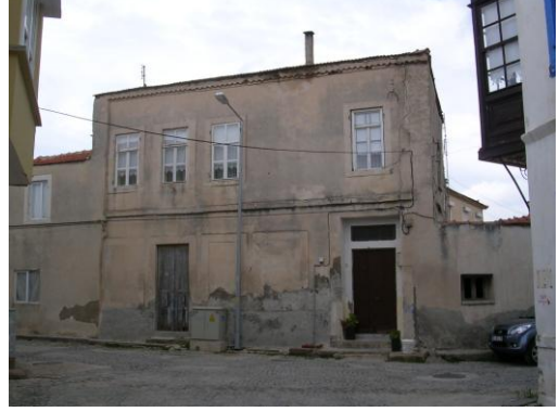
Şekil 5.57 Bölge B – 3 No'lu Yapı
