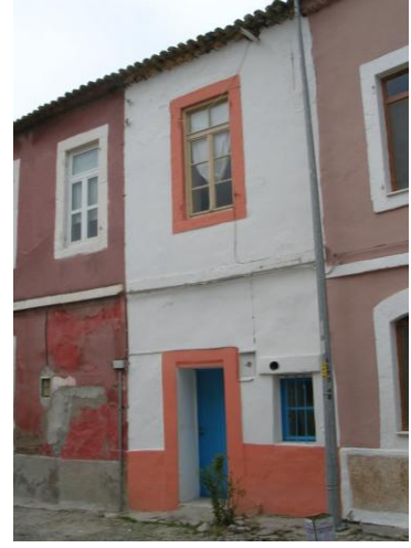
Şekil 4.21 Bölge A – 3 No'lu Yapı
