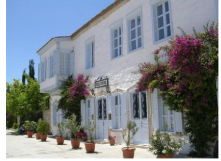
(Cemaliye Caddesi cephesi)
