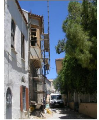
Şekil 4.219 Bölge F – 3 No'lu Yapı (2. Mektep Sokak cephesi)
