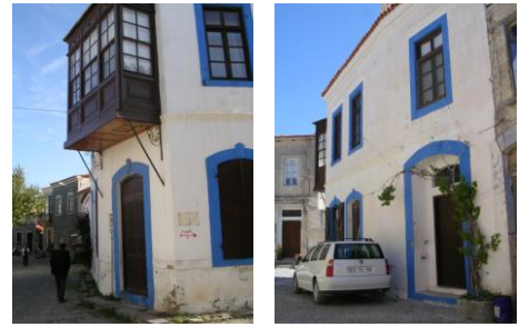
Şekil 4.42 Bölge B – 1 No'lu Yapı
