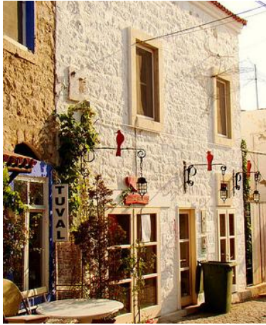
Şekil 5.12 Sıvalı Taş Duvar örneği Şekil 5.13 – Şekil 5.14 Sıvasız Taş Duvar örnekleri
