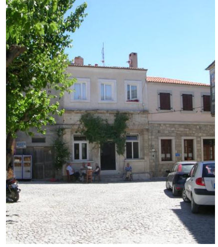
Şekil 4.94 Bölge B – 10 No'lu Yapı
