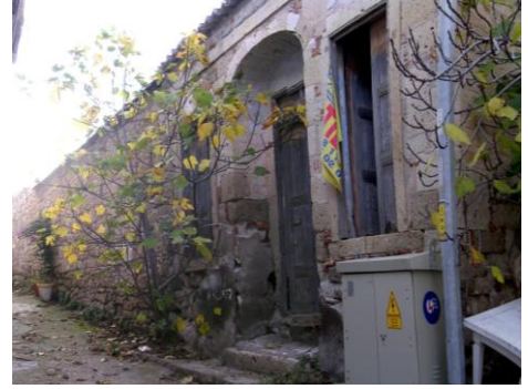
Şekil 4.186 Bölge E – 2 No'lu Yapı
