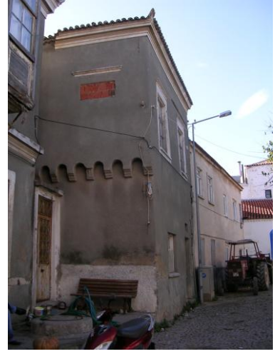
Şekil 4.114 Bölge B – 13 No'lu Yapı
