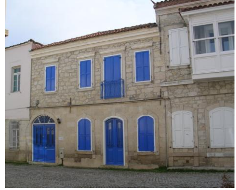
Şekil 4.224 Bölge G – 1 No'lu Yapı
