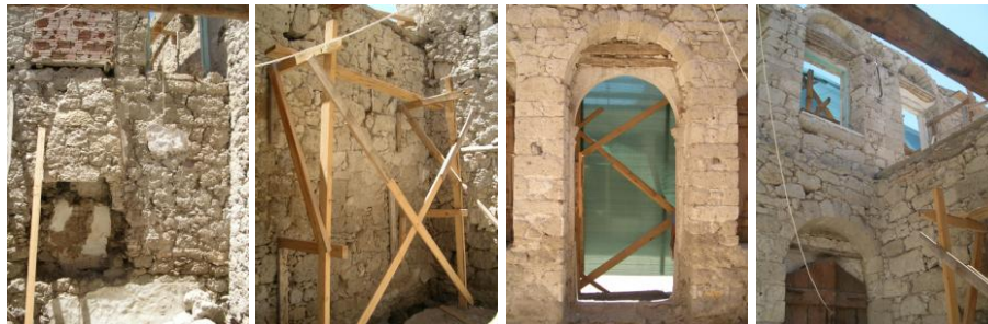
Şekil 4.157 D Bölgesi 2 No'lu yapı restorasyonu (Fotoğraflar: N. Melis Kocmanoğlu)
