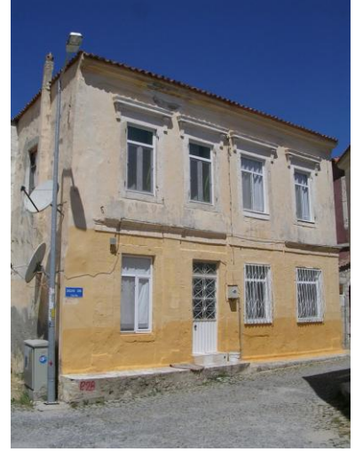
Şekil 4.6 Bölge A – 1 No'lu Yapı
