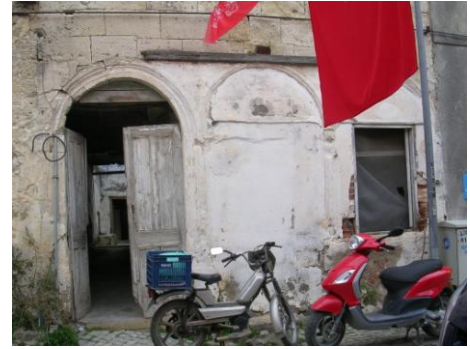
Şekil 4.87 Bölge B – 9 No'lu Yapı
