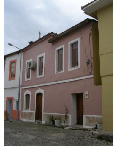
Şekil 4.28 Bölge A – 4 No'lu Yapı
