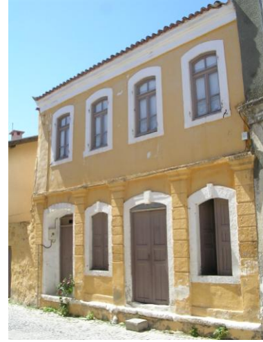
Şekil 4.108 Bölge B – 12 No'lu Yapı
