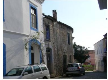
Şekil 4.50 Bölge B – 2 No'lu Yapı
