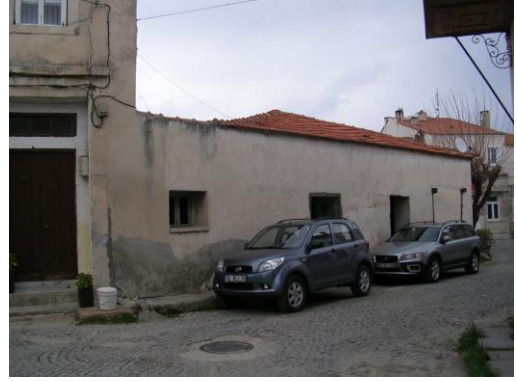
Şekil 4.64 Bölge B – 4 No'lu Yapı
