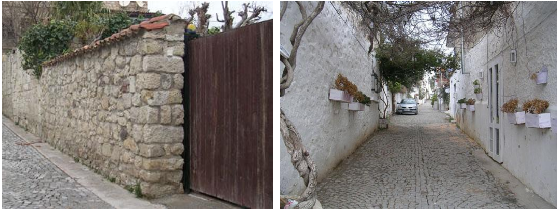
Şekil 5.15 - Şekil 5.16 Bahçe Duvarı Örnekleri
