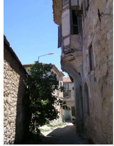
Şekil 4.180 Bölge E – 1 No'lu Yapı
