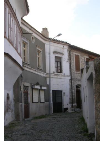
Şekil 4.121 Bölge C-1 No'lu Yapı
