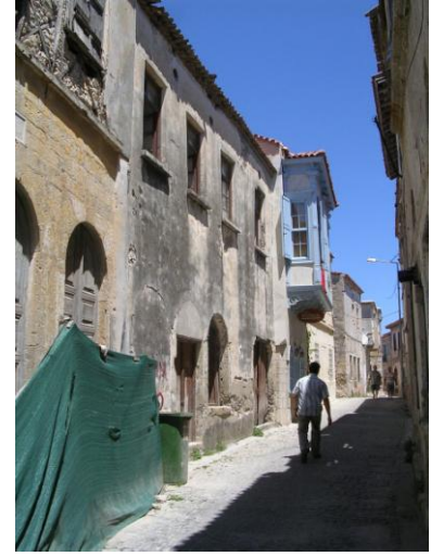
Şekil 4.199 Bölge E – 4 No'lu Yapı
