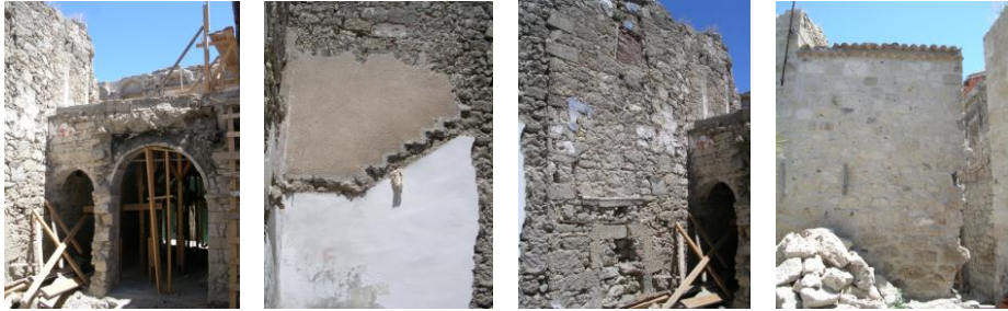
Şekil 4.149 D Bölgesi 1 No'lu yapı restorasyonu (Fotoğraflar: N. Melis Kocamanoğlu)
