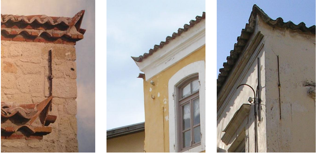
Şekil 5.24- Şekil 5.25- Şekil 5.26 Çatı Köşelerindeki Kartal Kanadı Detayları
