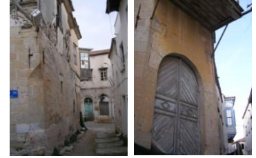
Şekil 4.192 Bölge E – 3 No'lu Yapı
