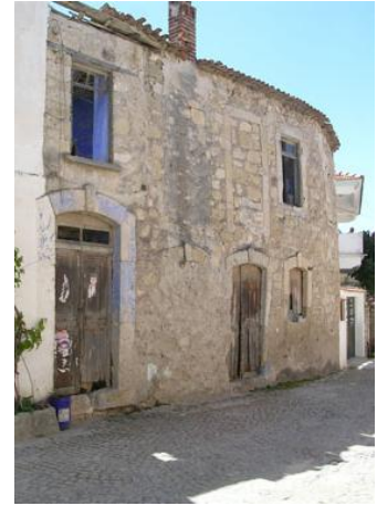
Şekil 5.12 Sıvalı Taş Duvar örneği Şekil 5.13 – Şekil 5.14 Sıvasız Taş Duvar örnekleri
