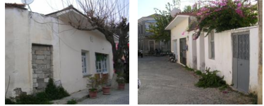
Şekil 4.69 Bölge B – 5 ve 6 No'lu Yapılar
