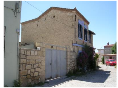
Şekil 4.137 Bölge C-4 No'lu Yapı
