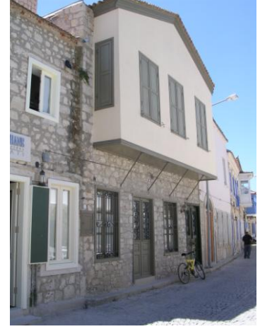
Şekil 4.231 Bölge G – 2 No'lu Yapı
