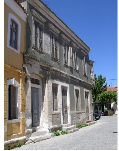
Şekil 4.99 Bölge B – 11 No'lu Yapı
