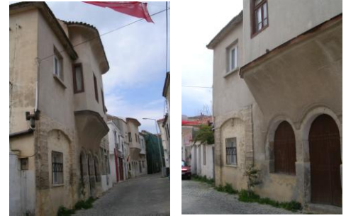
Şekil 4.80 Bölge B - 8 No'lu Yapı
