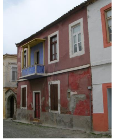
Şekil 4.14 Bölge A – 2 No'lu Yapı
