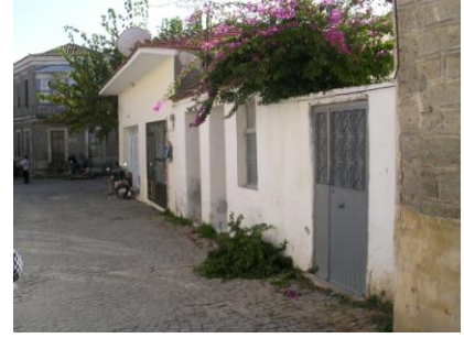
Şekil 4.75 Bölge B – 7 No'lu Yapı
