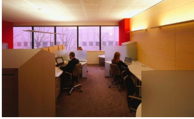
Resim 2.8. Endirekt aydınlatma armatürü uygulanmış ofis 114
