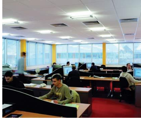
Resim 2.7. Yarı endirekt aydınlatma armatürleri uygulaması yapılmış ofis 112
