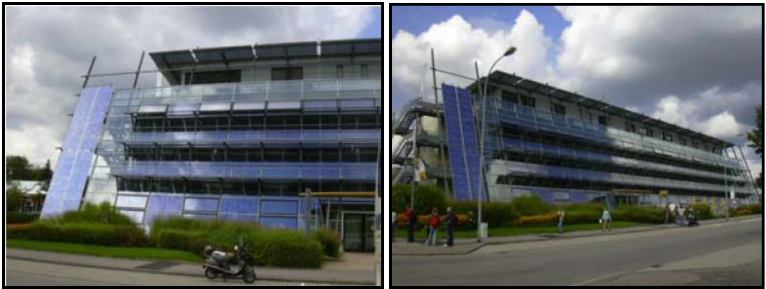
Şekil 2.1. Almanya Freiburg'da tüm cephesi ve çatısı fotovoltaik piller ile donatılarak aktif solar kazanım sağlayan Solar-Fabrik Binası ( Mimar: Rolf&Hotz) 7 .
