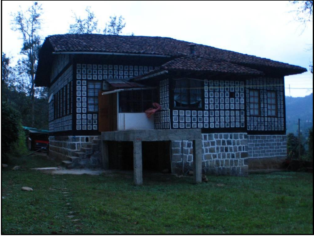
Şekil 3.39. Orhan Hacaloğlu Konağı Güneydoğu Görünüşü
