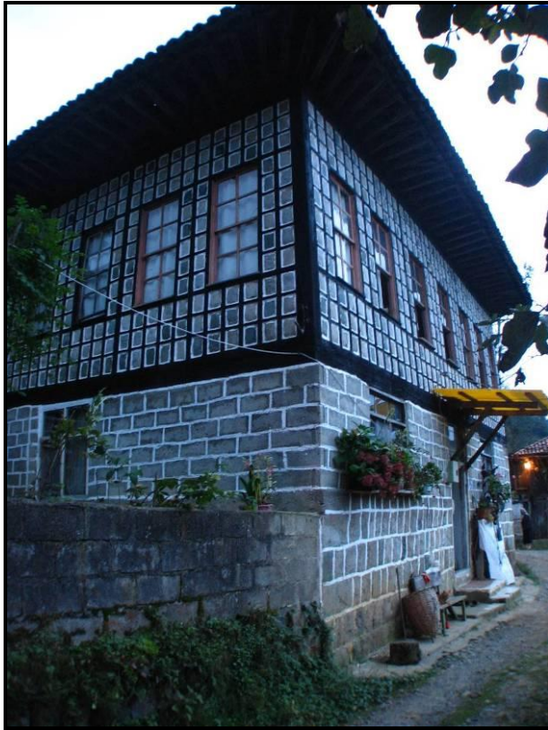
Şekil 3.27. Orhan Hacaloğlu Konağı Kuzeydoğu Görünüşü
