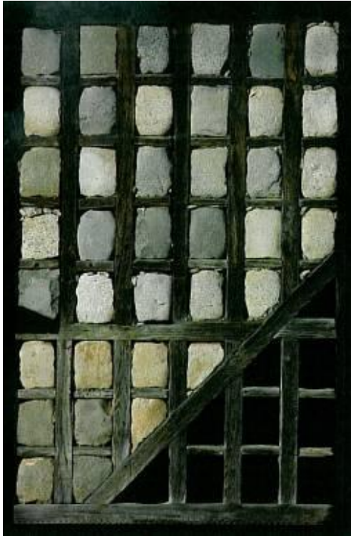
Şekil 3.9. Göz Dolma Duvar Örneği
