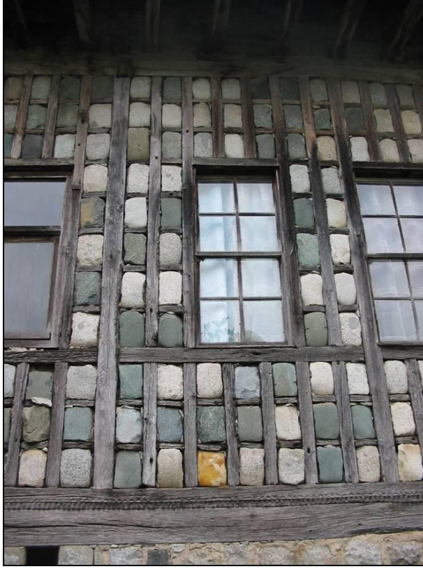
Şekil 3.5. Ahşap Çatma Göz Dolma Duvar Tekniği
