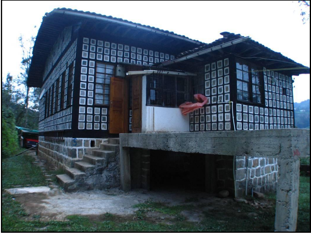
Şekil 3.40. Orhan Hacaloğlu Konağı Güneydoğu Görünüşü
