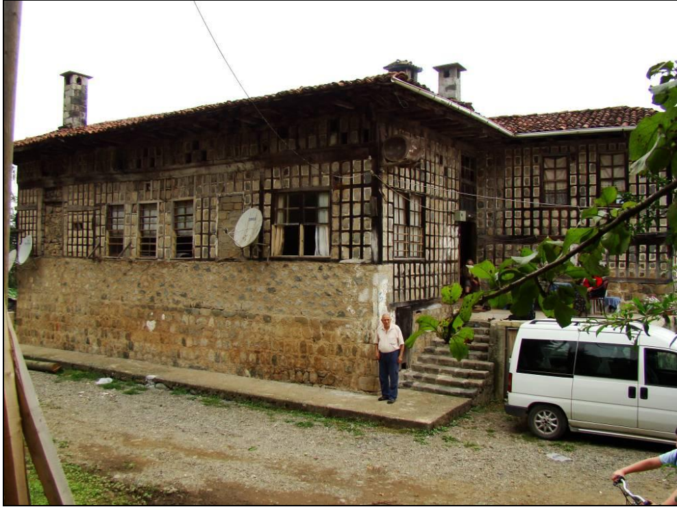
EK – 12. Şevketbeyođlu Konađı GÜneydođu Görünüđu
