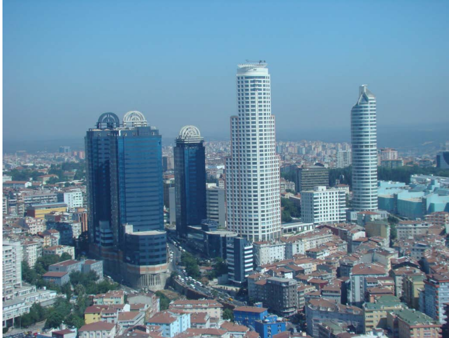
Şekil 2.61. Şişli Plaza, Şişli Elit Rezidans, Şişli Tat Plaza-İstanbul
