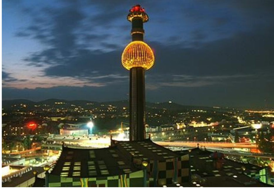
Resim 1.23. Resimdeki kule Avusturya'dadır ve 1000 ışıklı nokta; 8 adet 150W lamba, 1000 adet fiber kablo ve özel aygıt kullanılarak fiber optik sistem ile ışıklandırılmıştır, kulenin yüksekliği 130 metre, soğan şeklindeki ortadaki kürenin çapı ise 30 metredir. 105
