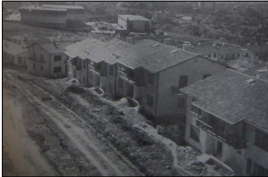
Fotoğraf 3.18. Mecidiyeköy'deki Gazeteciler Mahallesinden Bir Görünüm
