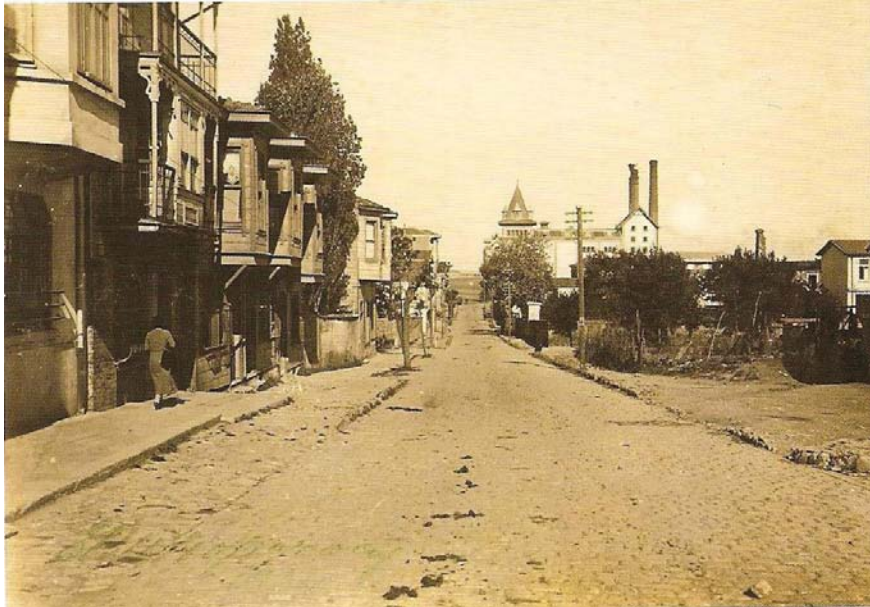
Şekil 4.52. 1930'lu Yıllar Bomonti Bira Fabrikası'na Giden Yol
