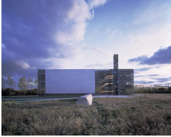
Şekil 5.42. Saydam ve opak bileşenlerin bir arada kullanıldığı The Royal Library Binası kuzey cephe görünüşü, Amager, Denmark (URL-24, 2009)
