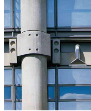
Şekil 6.39.b. Lloyds Binası cephe sistemi (URL-62, 2010)
