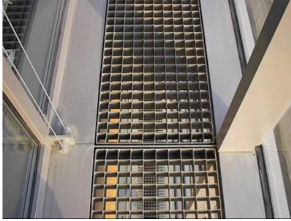
Şekil 5.86. Yürüme yolu görünüşü (URL-17, 2009)
