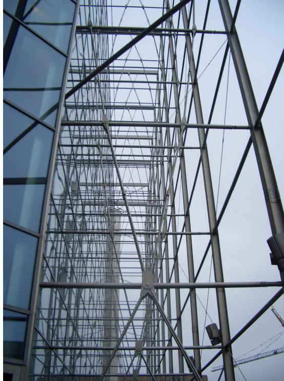
Şekil 5.10. Hybrid destekli strüktürlü çift kabuk cephe örneği (Foto. Çiçek A.)
