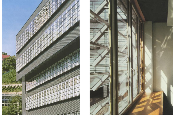
Şekil 5.77. Energy-Versorgung Schwaben AG Binasının harici güneş kontrol elemanlarının görünüşü (Oestrelle ve diğ., 2001, s.126)
