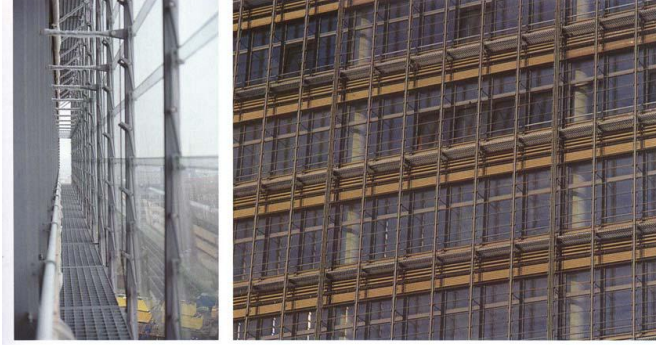
Şekil 4.36. Debis Binası'nda dış kabuğu oluşturan hareketli cam lamellerin ara boşluktan ve dıştan görünüşü (Gür 2007, s. 49)
