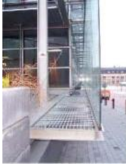
Şekil 5.8. Sanomatalo konsol taşıyıcılı strüktür görünüşü (Uuttu 2001, ek1/3)
