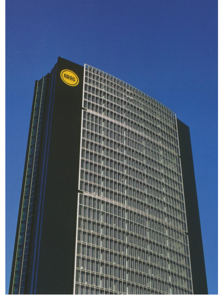
Şekil 6.54.a. Arag 2000 Binası görünüşü (Compagno 2002, s.156)
