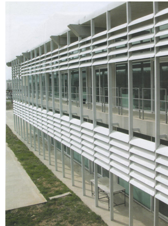
Şekil 6.16.c. MATPUM Binası güney cephesi (Çatı ve Cephe 2008a, s.40)
