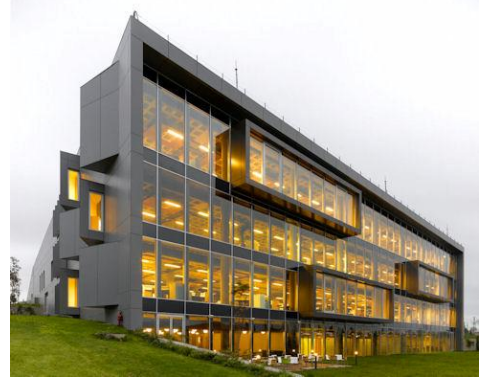
Şekil 6.18.a. Turkcell Ar-Ge Binası görünüşü (URL-41, 2010)
