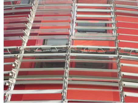
Şekil 6.58.b. Agbar Kulesi kabuk detayı (Foto.Ö.Eren)
