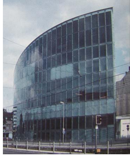
Şekil 6.41.a. Business Promotion Center Binası görünüşü (Lakot 2007, s.87)
