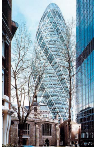
Şekil 2.19. Swiss Re Merkez Binası görünüşü (Compagno 2003, s.248)
