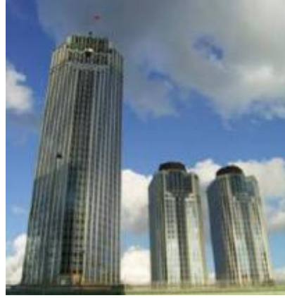
Şekil 5.31. İş Bankası Genel Müdürlük Binaları (Yılmaz 2005, s.396)
