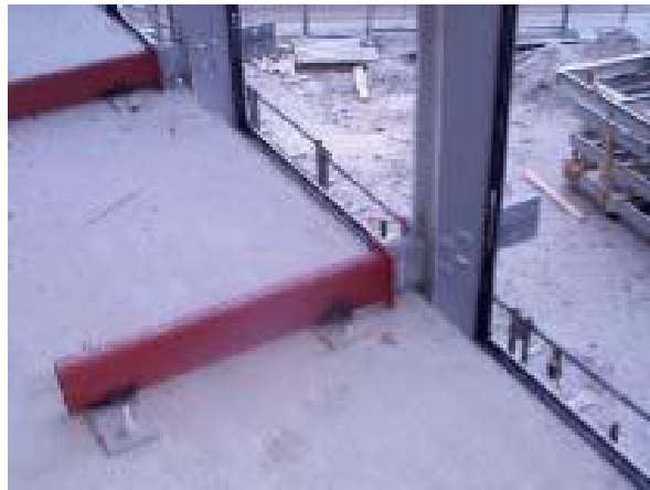
Şekil 5.7. Uzatılmış konsol strüktür örneği (Uuttu 2001, s.24)
