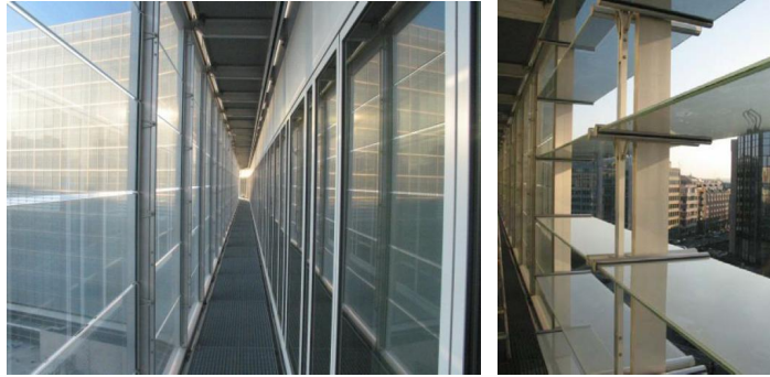
Şekil.5.78. Cam panjurların düşey ve yatay pozisyonundaki durumları (Loncour ve diğ., 2004, s.12)
