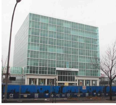
Şekil 2.14. Hooker Ofis Binası dış cephe görünüşü (URL-1, 2009)
