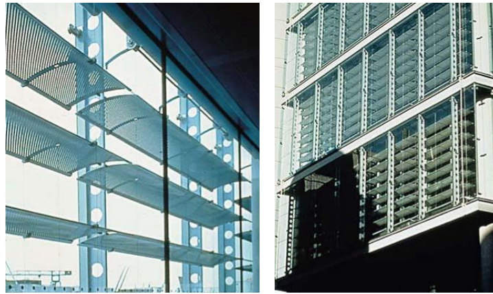
Şekil 4.18. Helicon Finsburg Binası gölgeleme elemanları (Yellamraju 2004, s.34)
