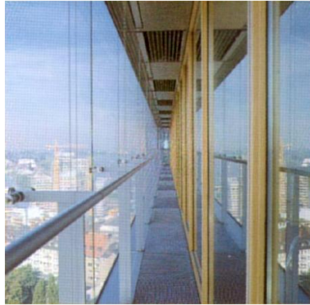
Şekil 4.53. Tüm kat boyunca uzayan boşluk ve havalandırma kutuları yardımıyla kontrollü havalandırma (Loncour ve diğ., 2004, s.28)
