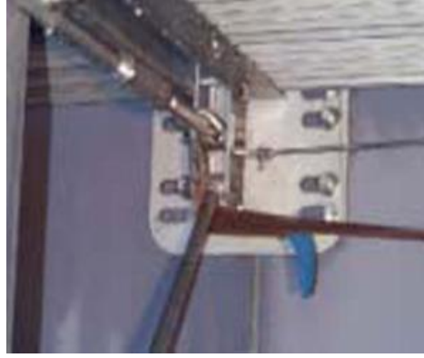
Şekil 5.17. Asma strüktür ve C-profil bağlantısı (Uttu 2001, s.25)
