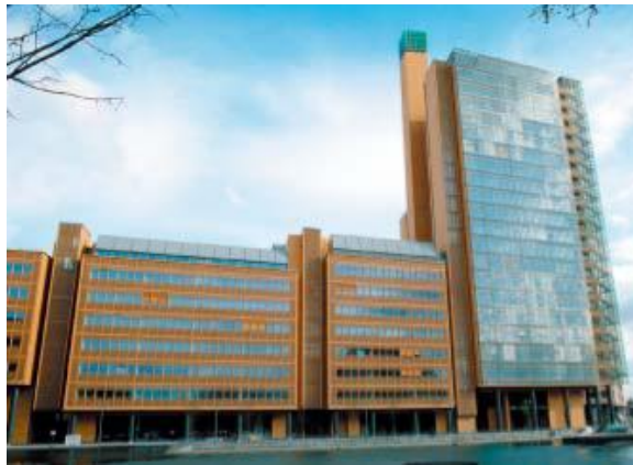
Şekil 2.16. Debis Tower görünüşü (Compagno 2003, s.246)
