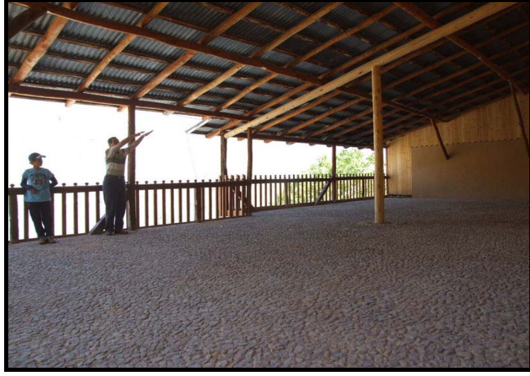
Resim 3. 2. 18: Kemaliye(Eğın) evinde yeni yapım bir dam
