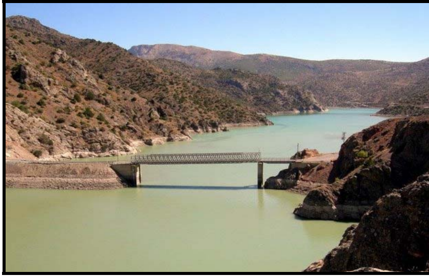
Resim 3. 1. 13. Yeni yapılan Başpınar Köprüsü
