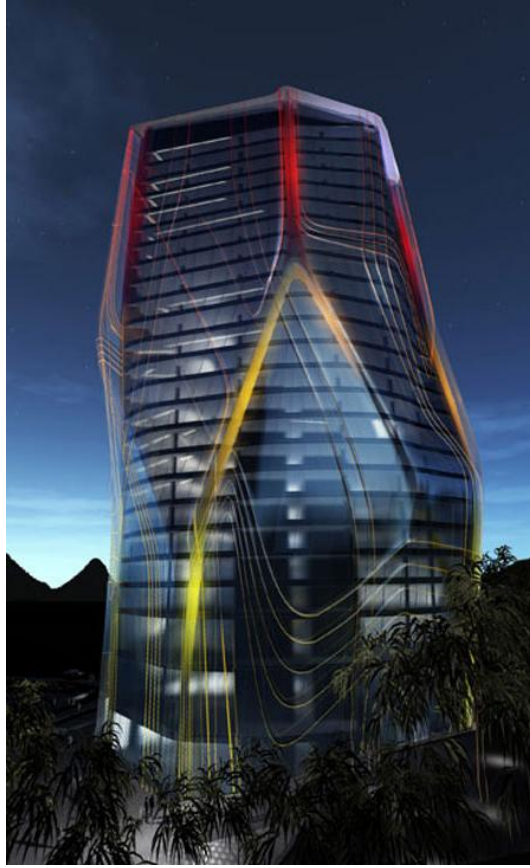
Şekil 4.215. Huaxi Kent Merkezi Binası 461
