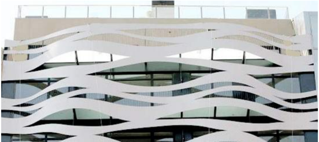
Şekil 4.160. Suites Avenue Apartmanı, Detay Görünümü 405
