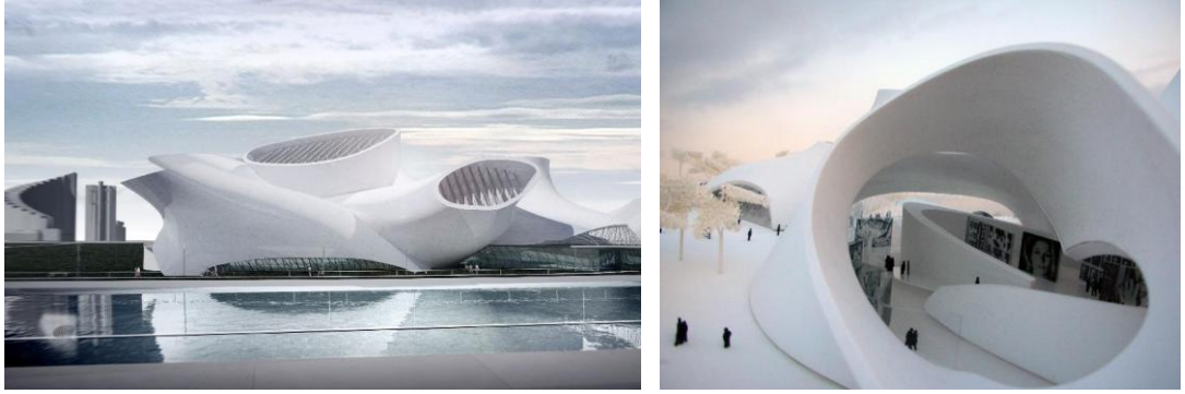
Şekil 4.85. Guggenheim Müzesi, Çeşitli Görünümler 321
