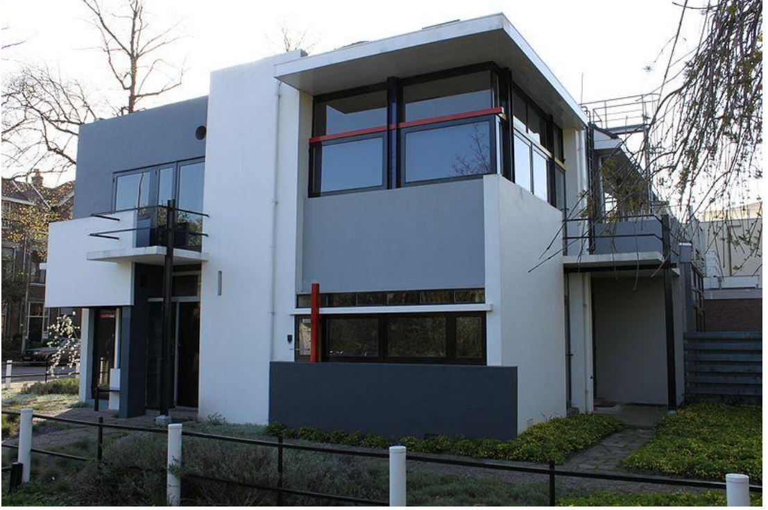
Şekil 3.31. Schröder Evi, Rietveld, Dış Mekan Görüntüsü, 1924-1919 200
