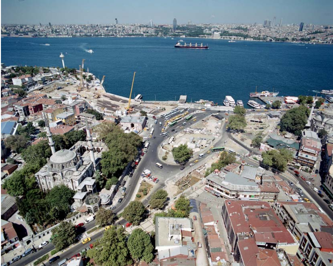
Resim 5.1 Üsküdar Meydanı'nın günümüzdeki durumu (Marmaray Projesi Kazı Ekibi Arşivi)
