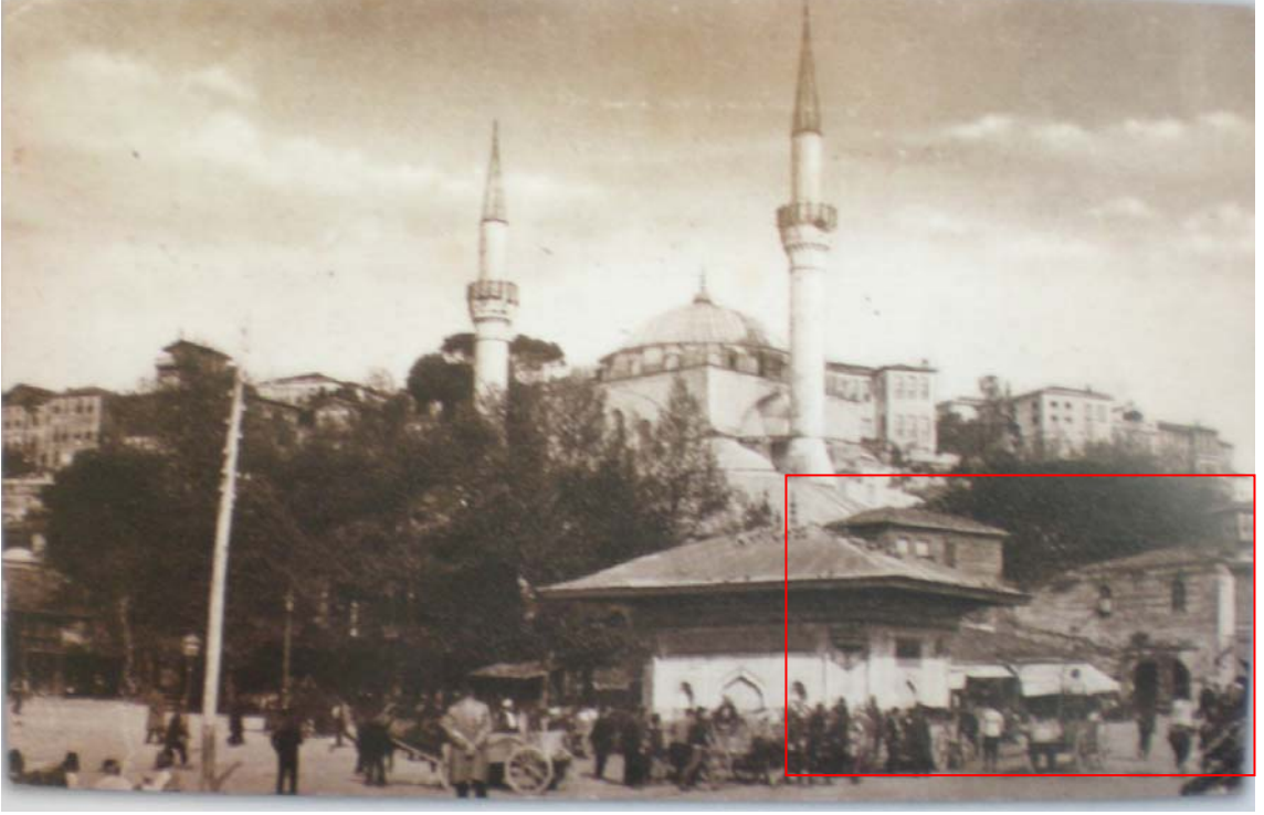
Resim 4.33 Almasıık Duvarlı Yapı ve ahşap fevkani yapı (Anıtlar Kurulu, 2008a)
