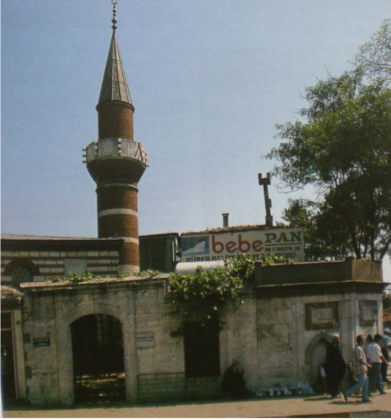
Resim 4.12 Selman Ağa Camii Avlu Duvarı (Anıtlar Kurulu Arşivi)
