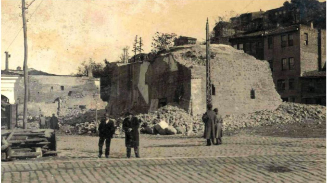
Resim 4.42 1931 yılında Kervansaray binası yıktırılırken (Göncüoğlu, 2008)
