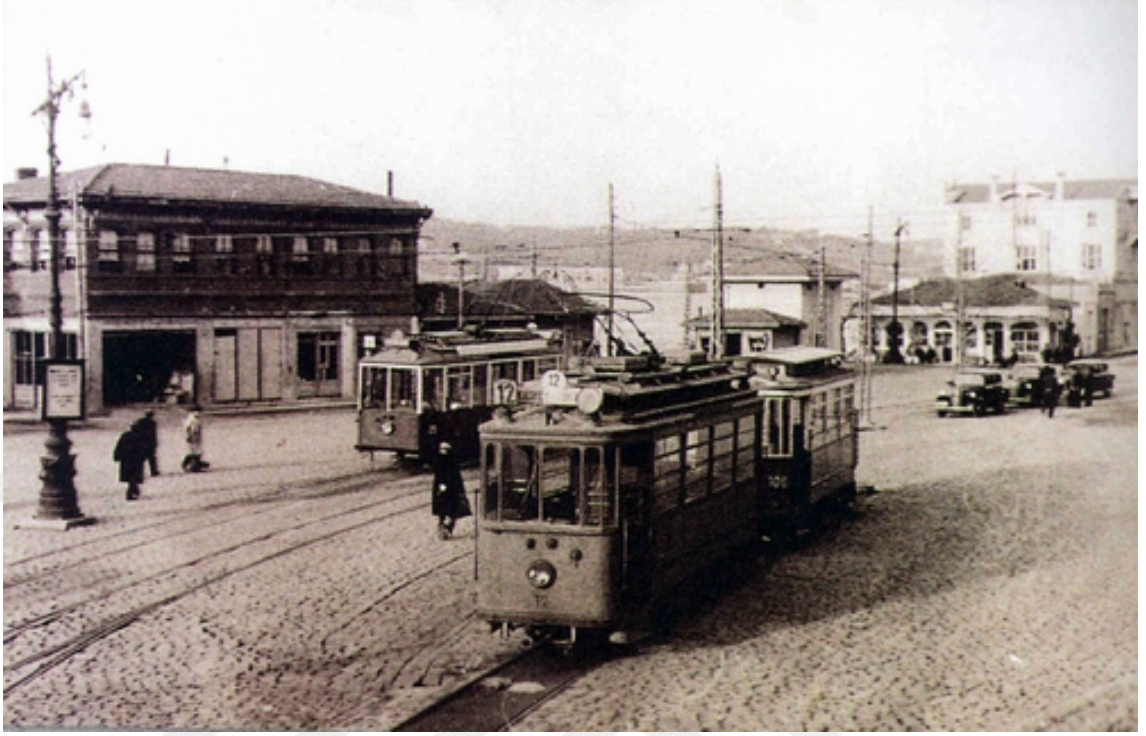
Resim 4.66 Üsküdar Meydanı ve İtfaiye Teşkilatı binası (Ünlü ve diğ., 2003)
