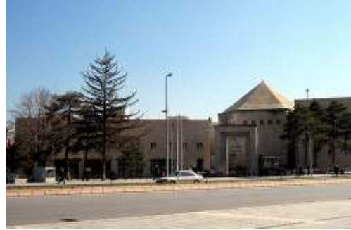
Şekil 4.28. 1960'ların Sonuna Doğru Yıkılarak Yenilenen Mevcut Kayseri Valilik Binası Alıntı: http://www.flickr.com
