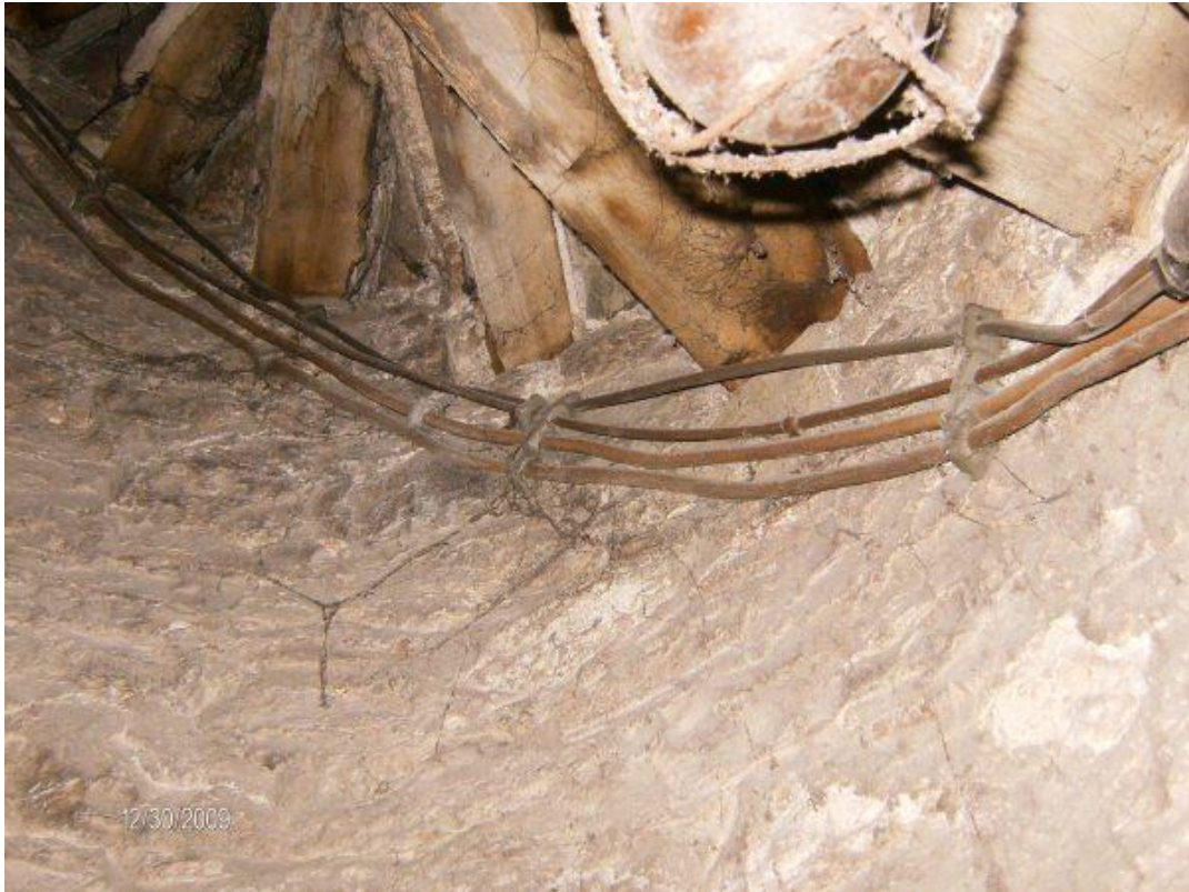
Resim.31: Karaali Çavuş Camii Minaresi
