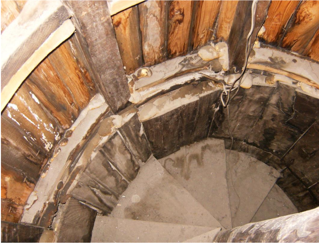
Resim.37: Makbul İbrahim Paşa Camii Minaresi Beden Duvarı
