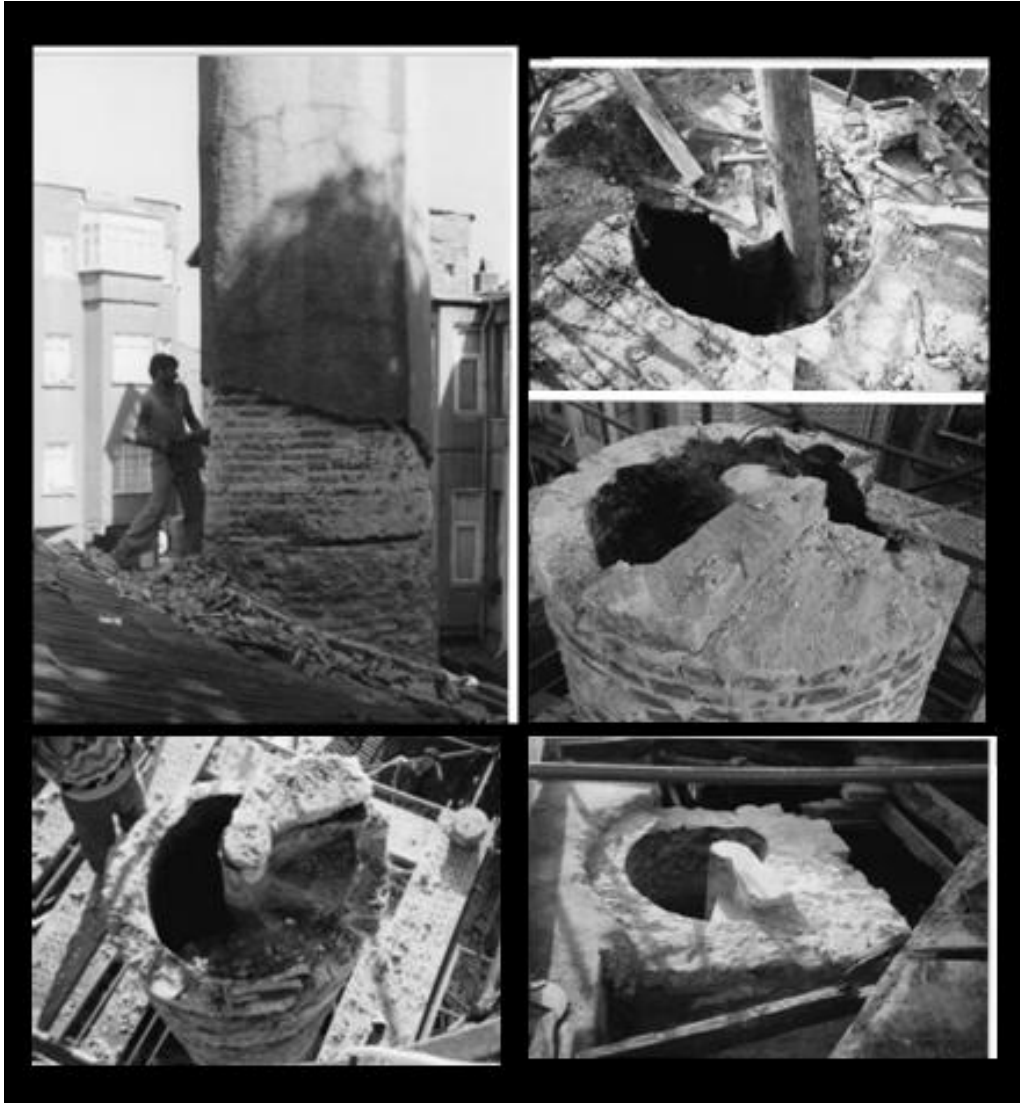
Resim.74: Balat Tahta Minare Camii Minare Gövde Ve Kaidesi Söküm Aşaması
