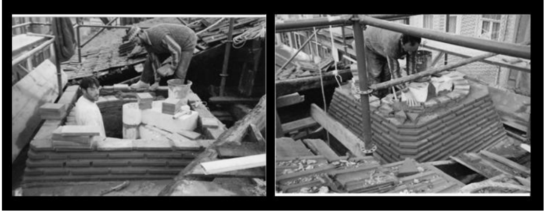
Resim75: Balat Tahta Minare Camii Minare Pabuç Bölümü İmalat Aşaması
