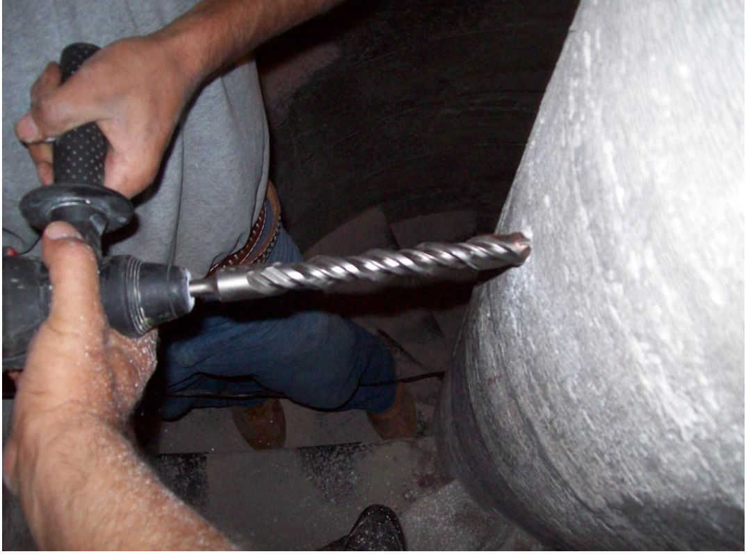
Resim.59: Süleymaniye Camii Minare Çekirdeği
