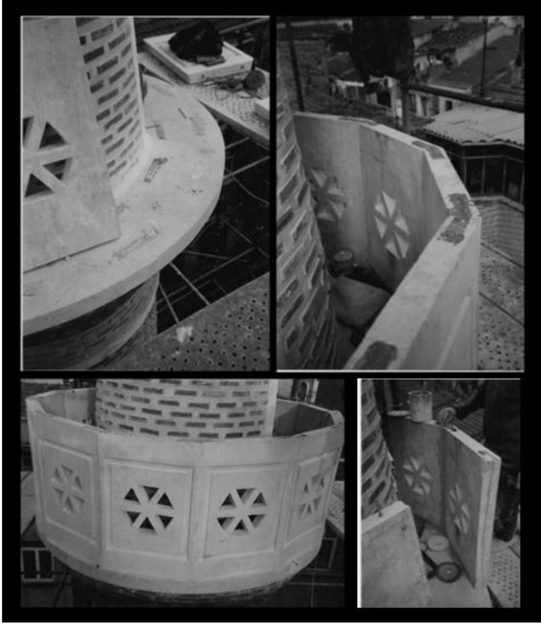
Resim.80: Balat Tahta Minare Camii Minare Şerefe Korkuluđu İmalat Aşaması
