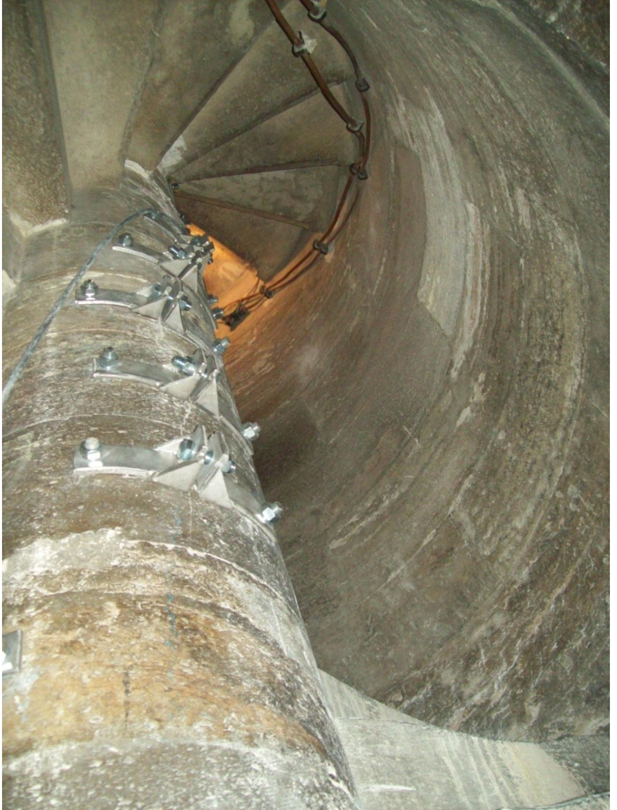
Resim.105: Süleymaniye Cami Minare Çekirdeđi
