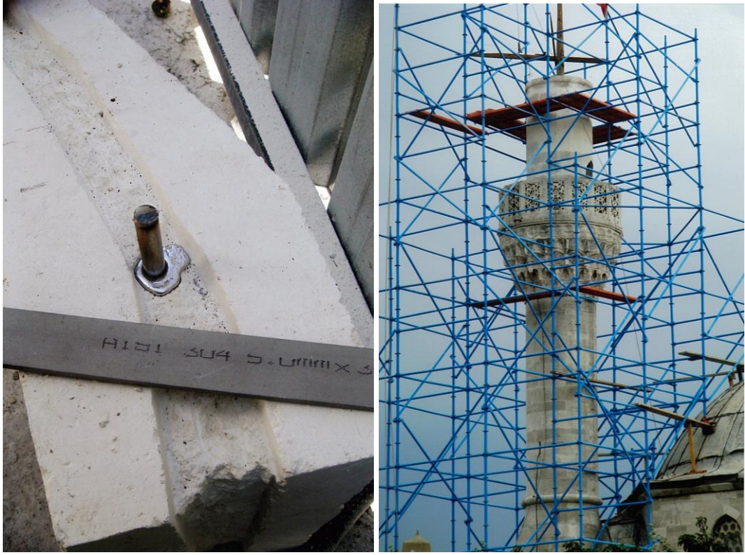
Resim.46-47 : Şemsi Paşa Camii (Gövde Kenet Detayı)
