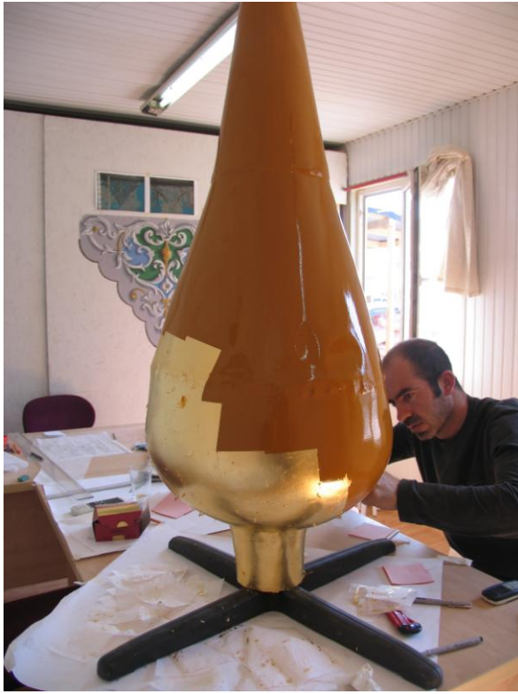
Resim.107-108 Süleymaniye Cami Minare Bakır Alemleri Tamiri (2009)
