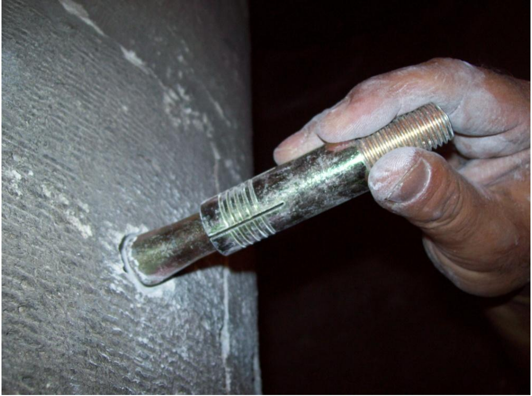
Resim.60: Süleymaniye Camii Minare Çekirdeği
