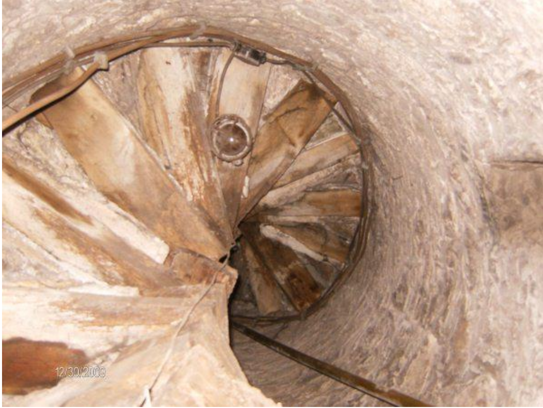
Resim.30: Karaali Çavuş Camii Minaresi Çekirdeksiz Minare Basamakları
