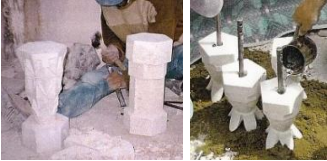
Resim.67-68: Eyüp Sultan Camii Şerefe Püskülleri (İmalat Aşaması)
