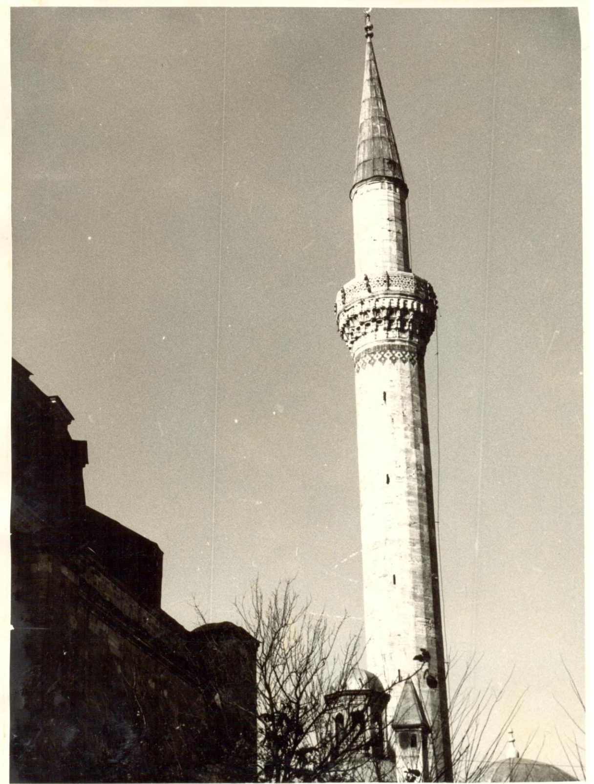
Resim .90: Yavuz Selim Camii 1961 Onarımı
