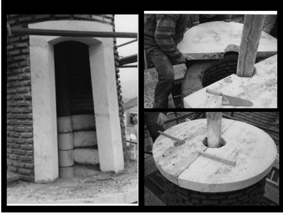
Resim.78: Balat Tahta Minare Camii Minare Petek Bölümü İmalat Aşaması
