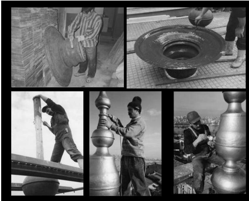
Resim.79: Balat Tahta Minare Camii Minare Alemi Montaj Aşaması
