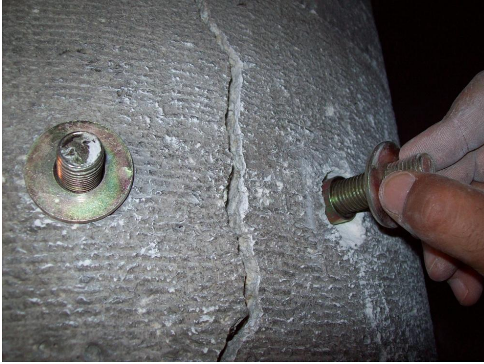
Resim.61: Süleymaniye Camii Minare Çekirdeği
