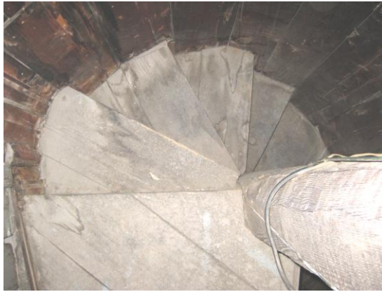
Resim.9: Muradiye Camii Minaresi Ahşap Basamakları (Kaynak: İVBMA)
