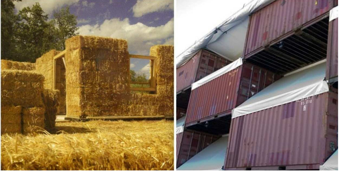
Şekil 3.11 Organik ve inorganik geri dönüştürülebilir malzemelerin yapı bileşenleri olarak kullanılması
