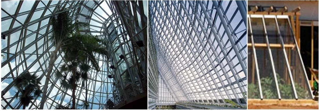
Şekil 3.5 Pasif cephe sistemlerinden güneş odaları(sun space),
