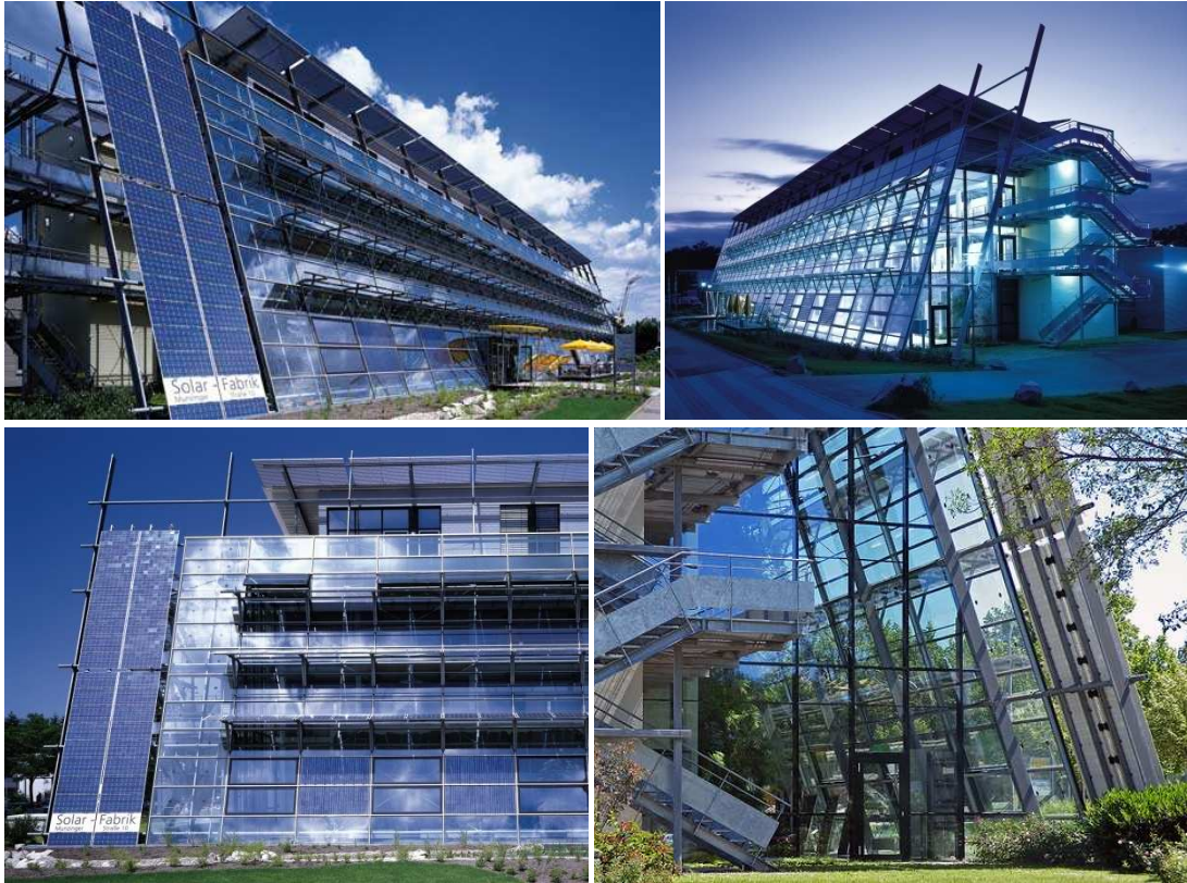
Şekil 4.6 Solar-Fabrik Güneş paneli üretim fabrikası
