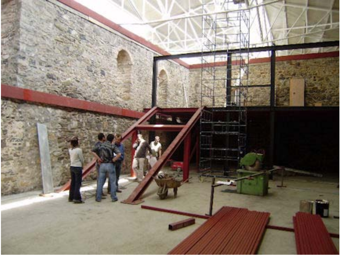
Resim 56. Kasımpaşa Tuz Ambarı restorasyon çalışmaları
