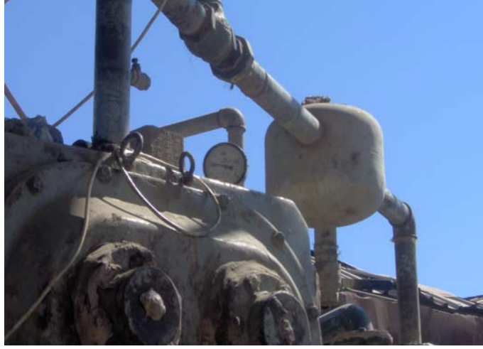
Şekil 3.11. Plastik Tuğla Hamurunun Stoklandığı Basınçlı Depo
